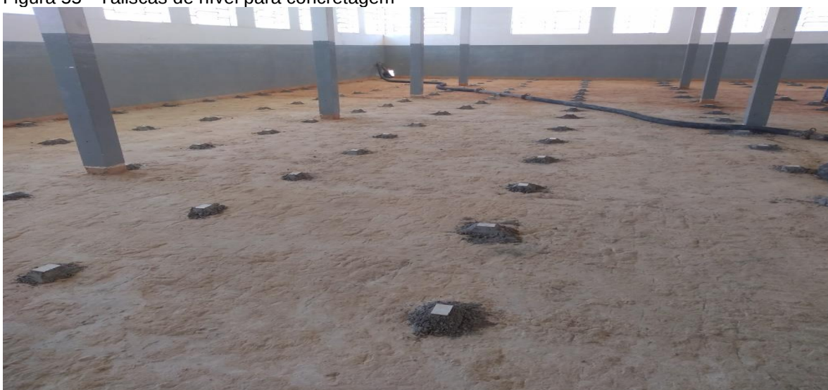
Figura 55 - Taliscas de nível para concretagem
