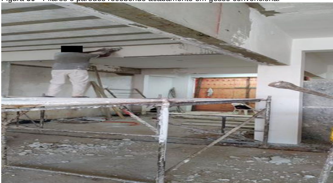
Figura 30 - Pilares e paredes recebendo acabamento em gesso convencional
