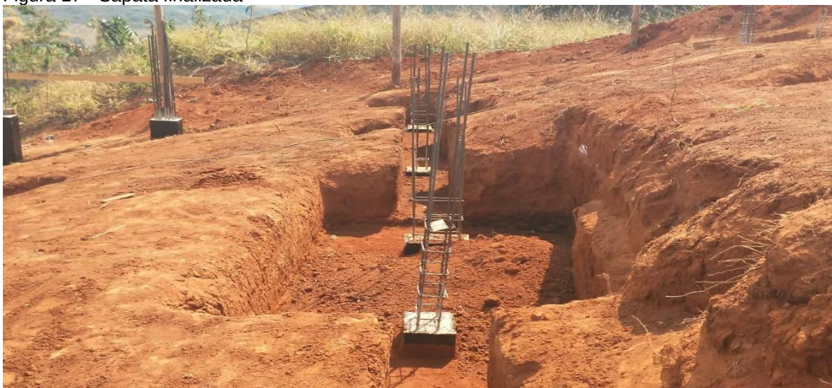
Figura 17 - Sapata finalizada
