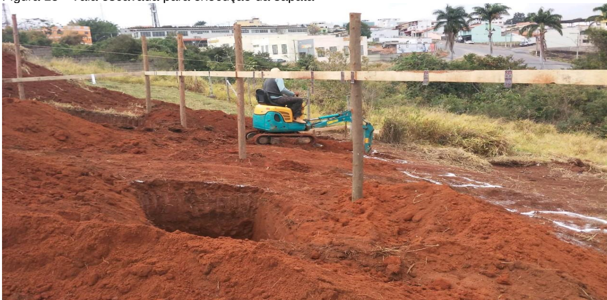
Figura 15 - Vala escavada para execução da sapata
