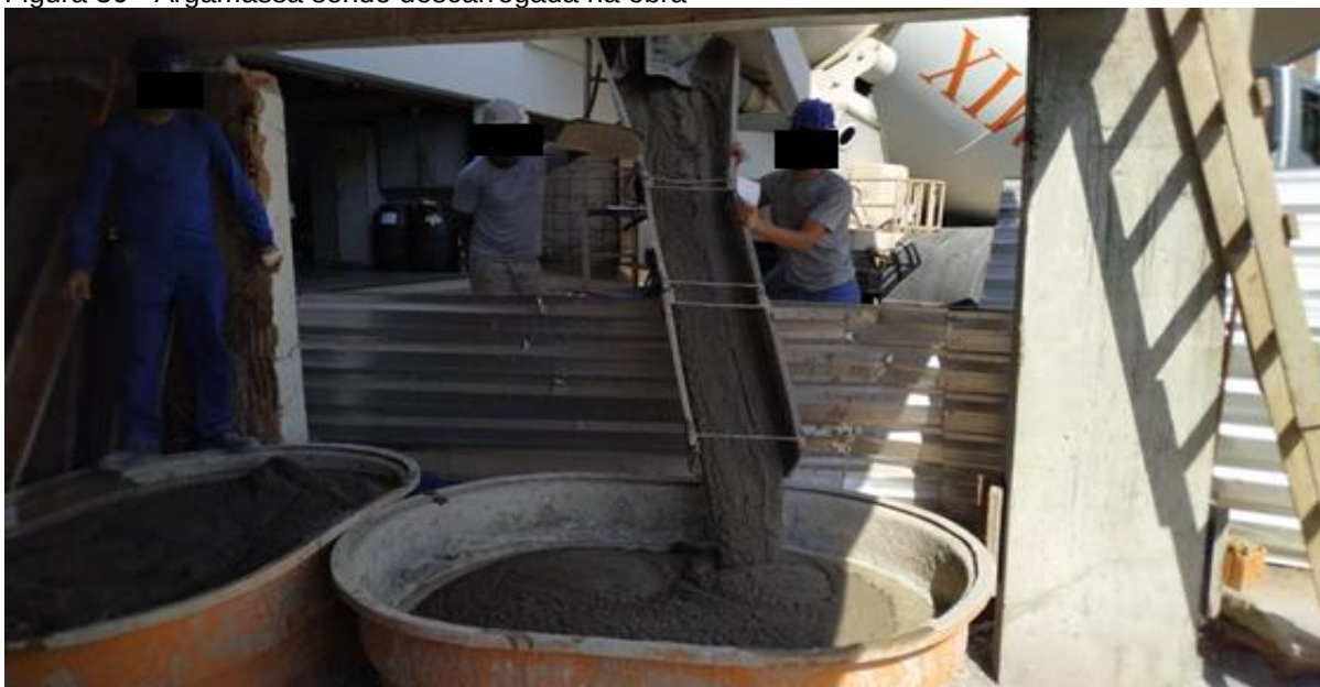
Figura 36 - Argamassa sendo descarregada na obra
