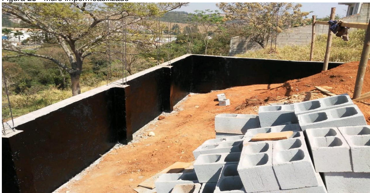
Figura 23 - Muro impermeabilizado
