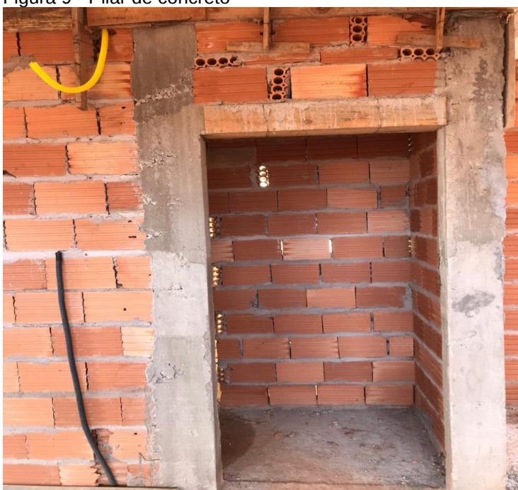
Figura 9 - Pilar de concreto
