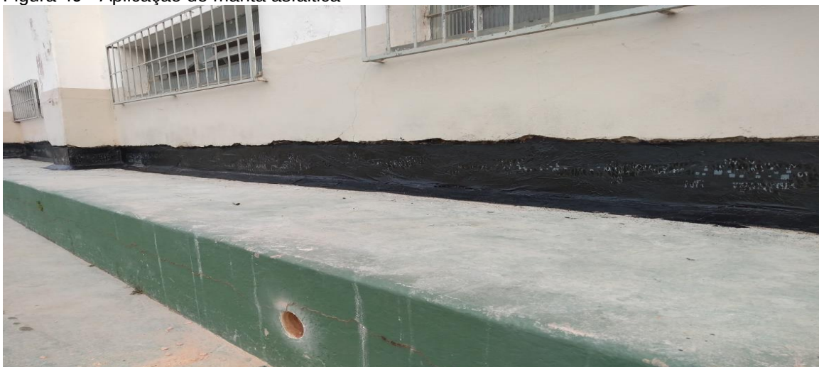
Figura 49 - Aplicação de manta asfáltica
