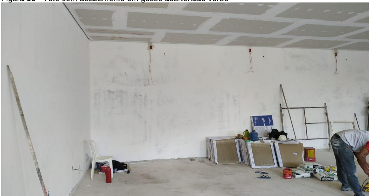
Figura 33 - Teto com acabamento em gesso acartonado verde
