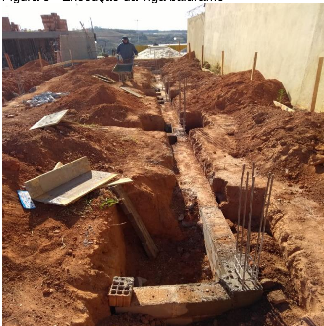
Figura 5 - Execução da viga baldrame
