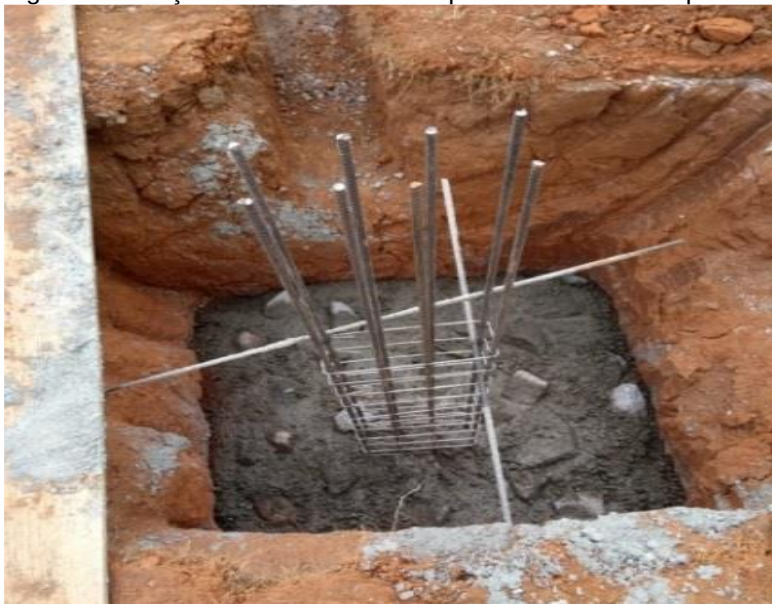
Figura 4 - Lançamento do concreto e pedra de mão na sapata
