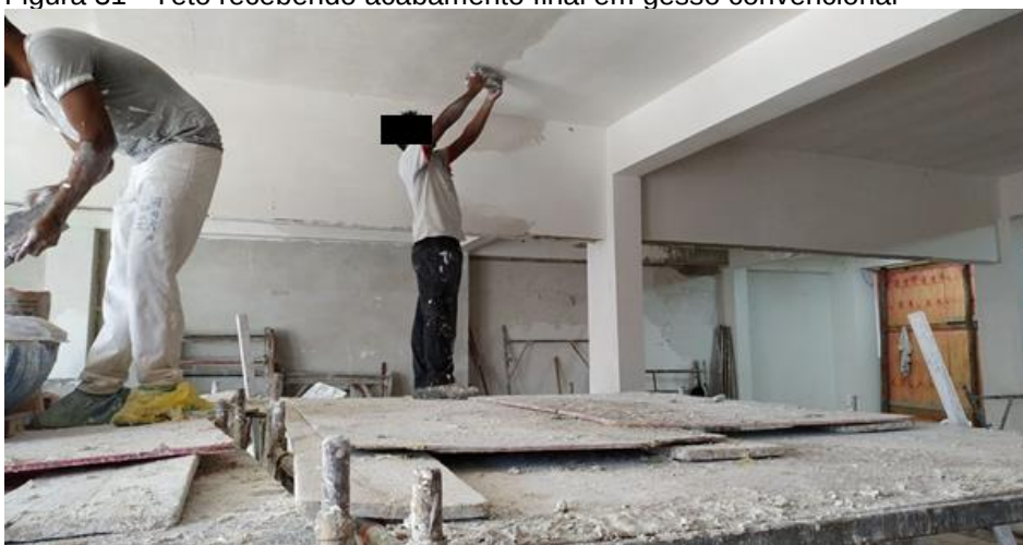
Figura 31 - Teto recebendo acabamento final em gesso convencional
