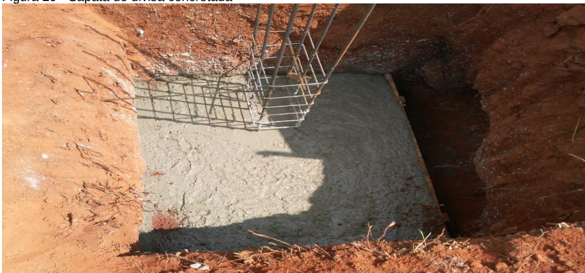
Figura 20 - Sapata de divisa concretada
