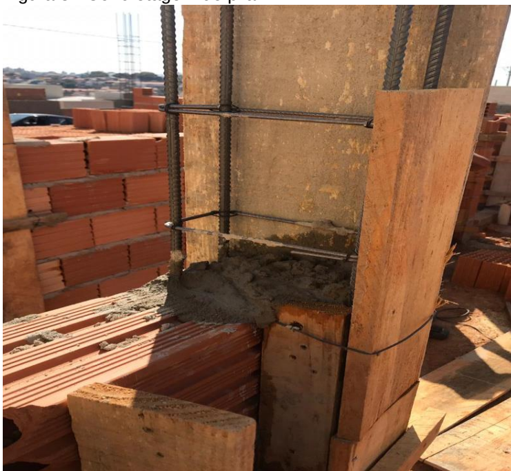
Figura 8 - Concretagem do pilar
