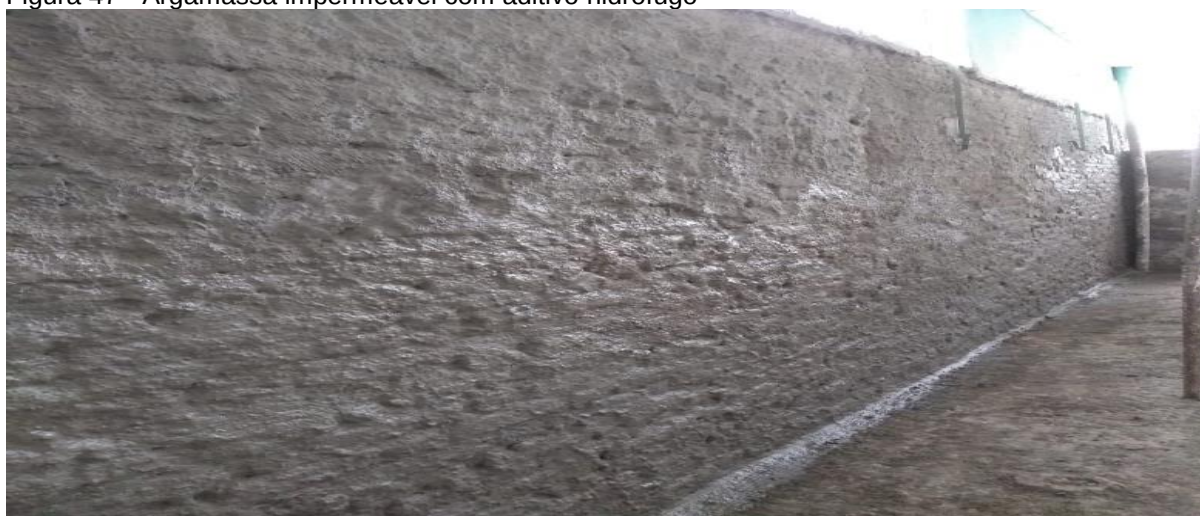
Figura 47 - Argamassa impermeável com aditivo hidrófugo
