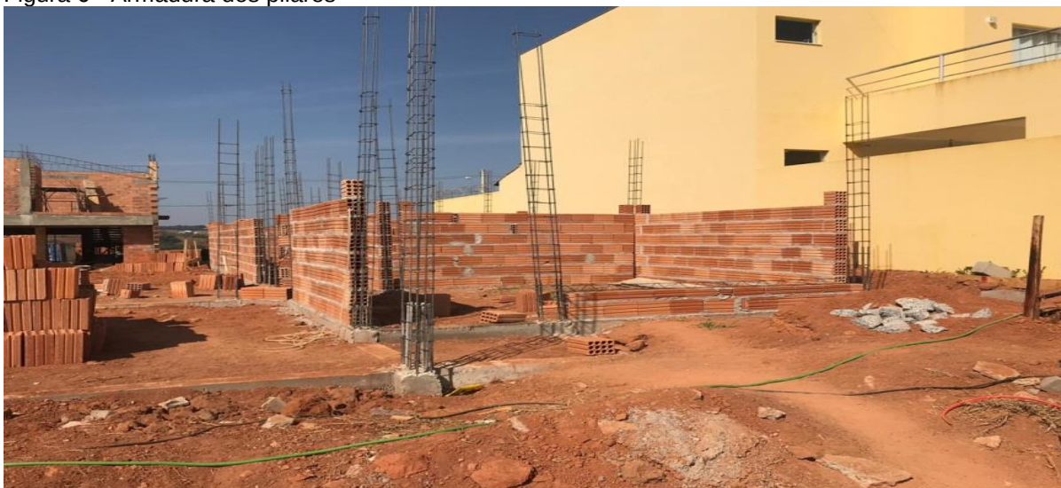
Figura 6 - Armadura dos pilares
