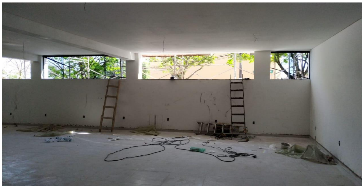
Figura 34 - Acabamento em gesso acartonado verde
