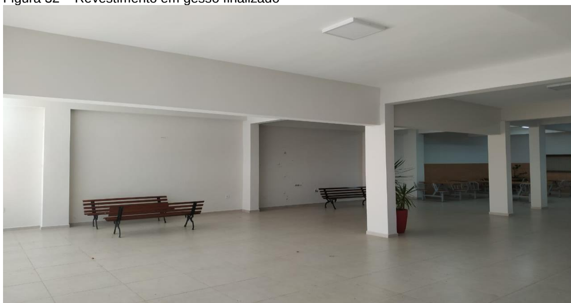
Figura 32 – Revestimento em gesso finalizado
