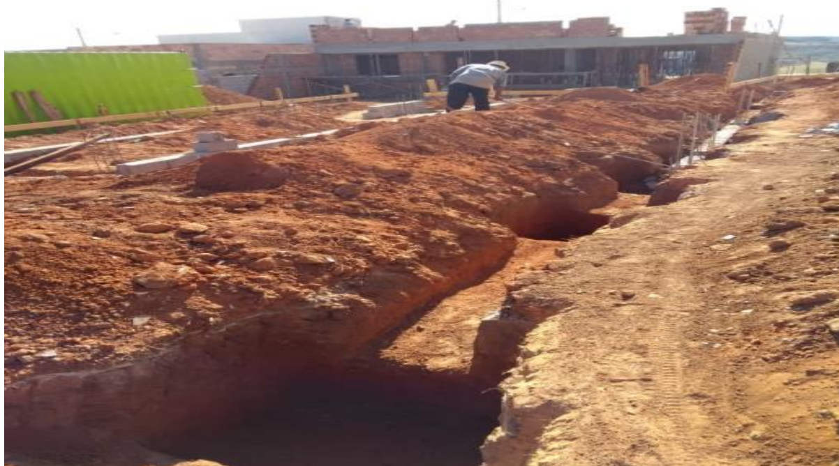
Figura 3 - Perfuração do terreno
