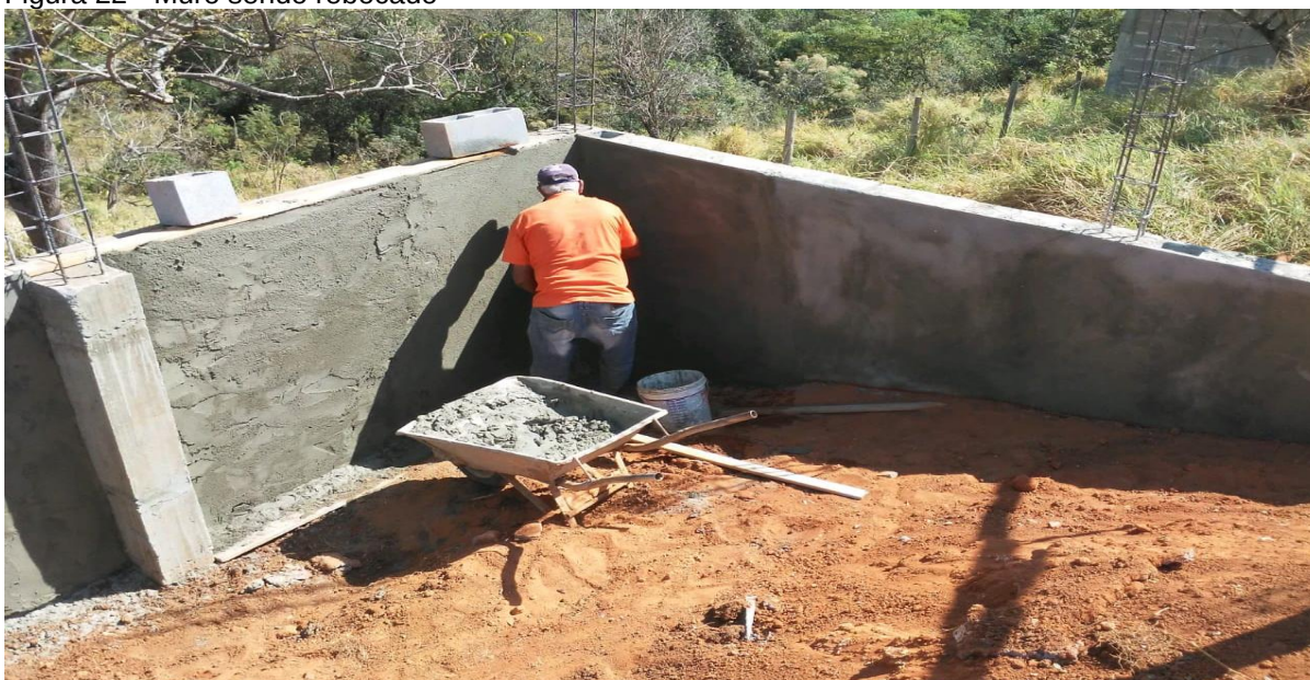
Figura 22 - Muro sendo rebocado
