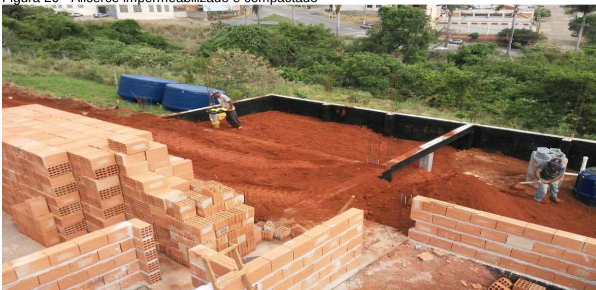
Figura 26 - Alicerce impermeabilizado e compactado
