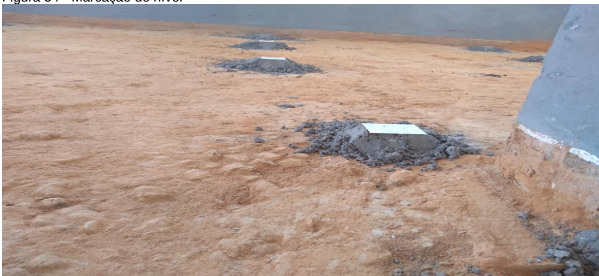
Figura 54 - Marcação de nível
