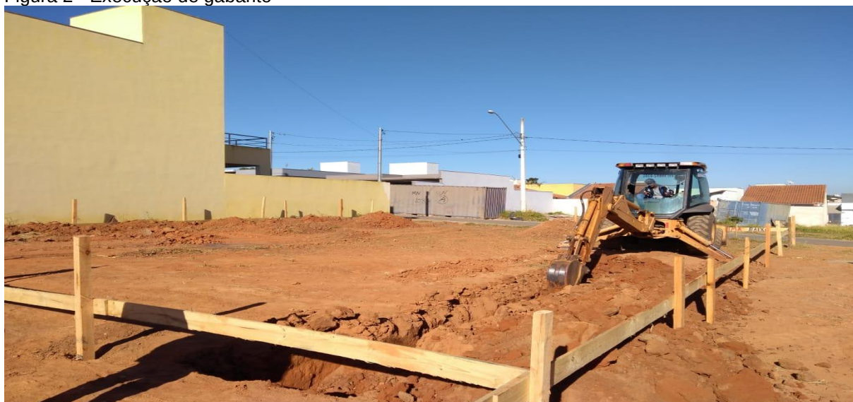
Figura 2 - Execução de gabarito
