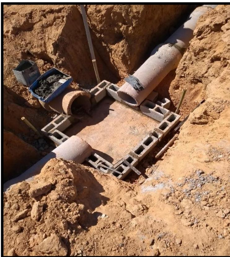
Os poços de visita, além de permitir e facilitar possíveis manutenções na rede, têm função de mudar a direção da mesma, visto que os tubos de concreto não contam com conexões que permitam tal mudança, como joelhos e tês. Além disso, é através dos poços de visita que se promove a união de redes distintas.
