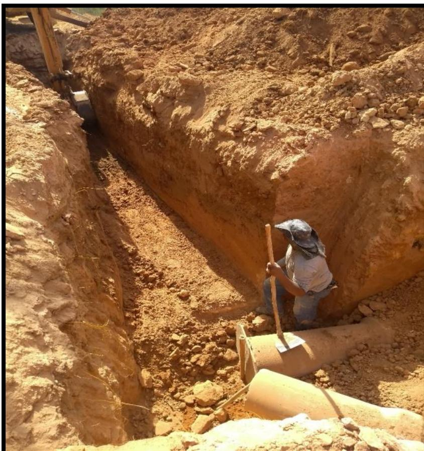
Com o objetivo de facilitar o andamento da obra, foi utilizada uma retroescavadeira para fazer os cortes das valas, já que seu sistema hidráulico otimiza o trabalho de escavação. Para manter a conformidade dos cortes, o operador deve posicionar o eixo da máquina sobre a marca de cal, movimentando-a sobre a linha demarcada.
