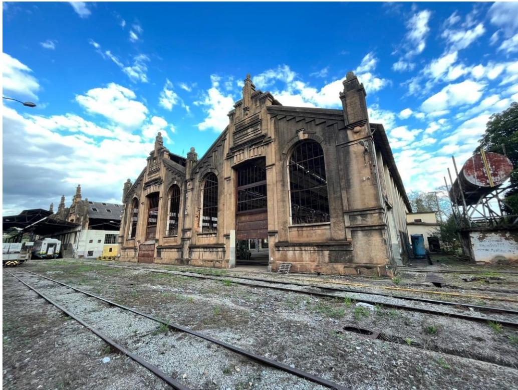
Imagem 7 - Galpões da Antiga Rede Ferroviária
