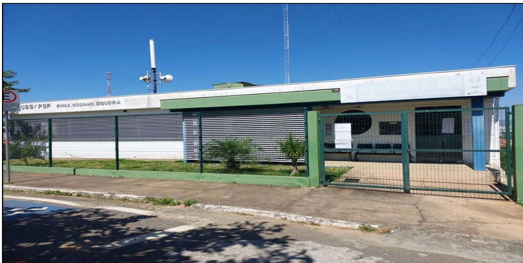
Imagem 1 - Fachada da ESF 03 –Caminho das Águas.
