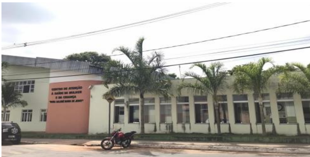
Imagem 21 - Fachada do Centro de Atenção Secundária de Campo Belo-MG.
