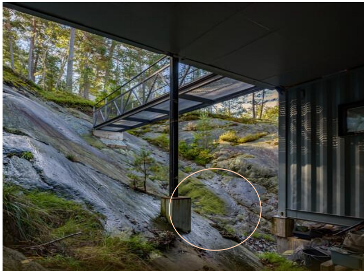
Imagem 4: Implantação da sustentação dos containers
