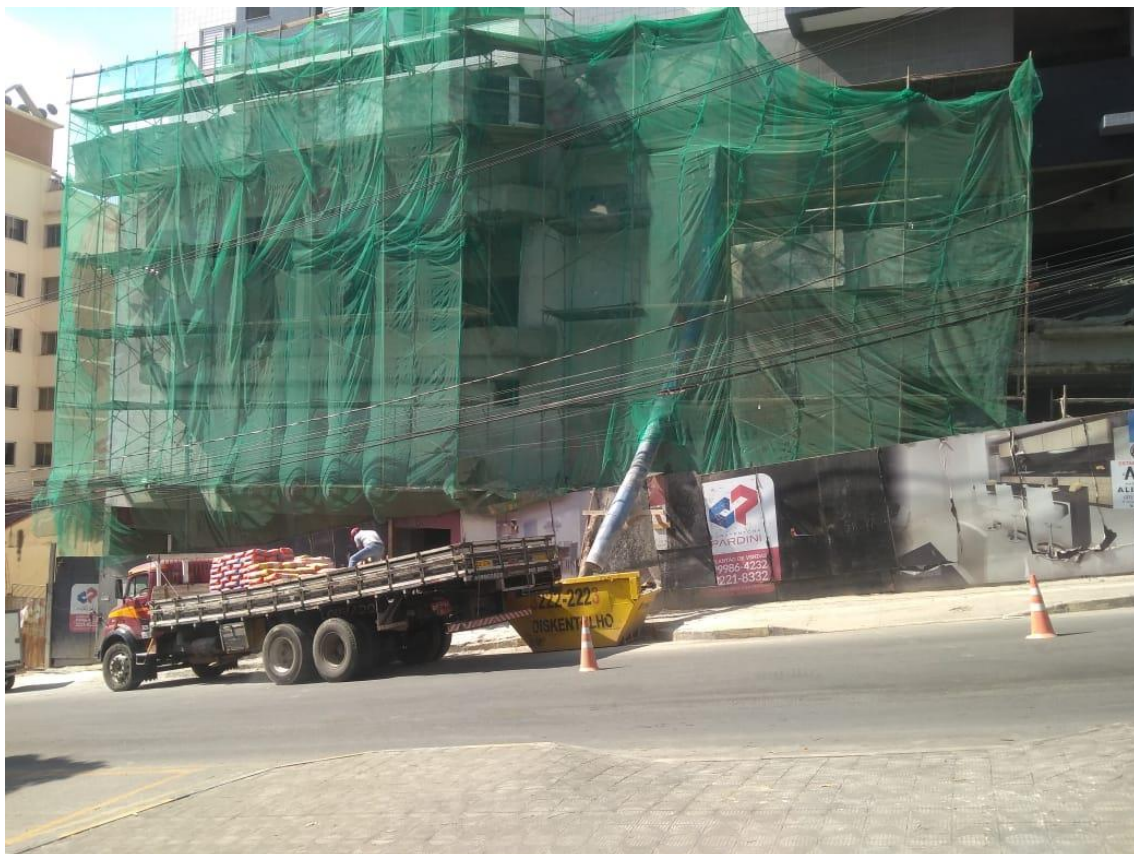
Figura 1 – Exemplo de EPC's na Indústria de Construção Civil.
