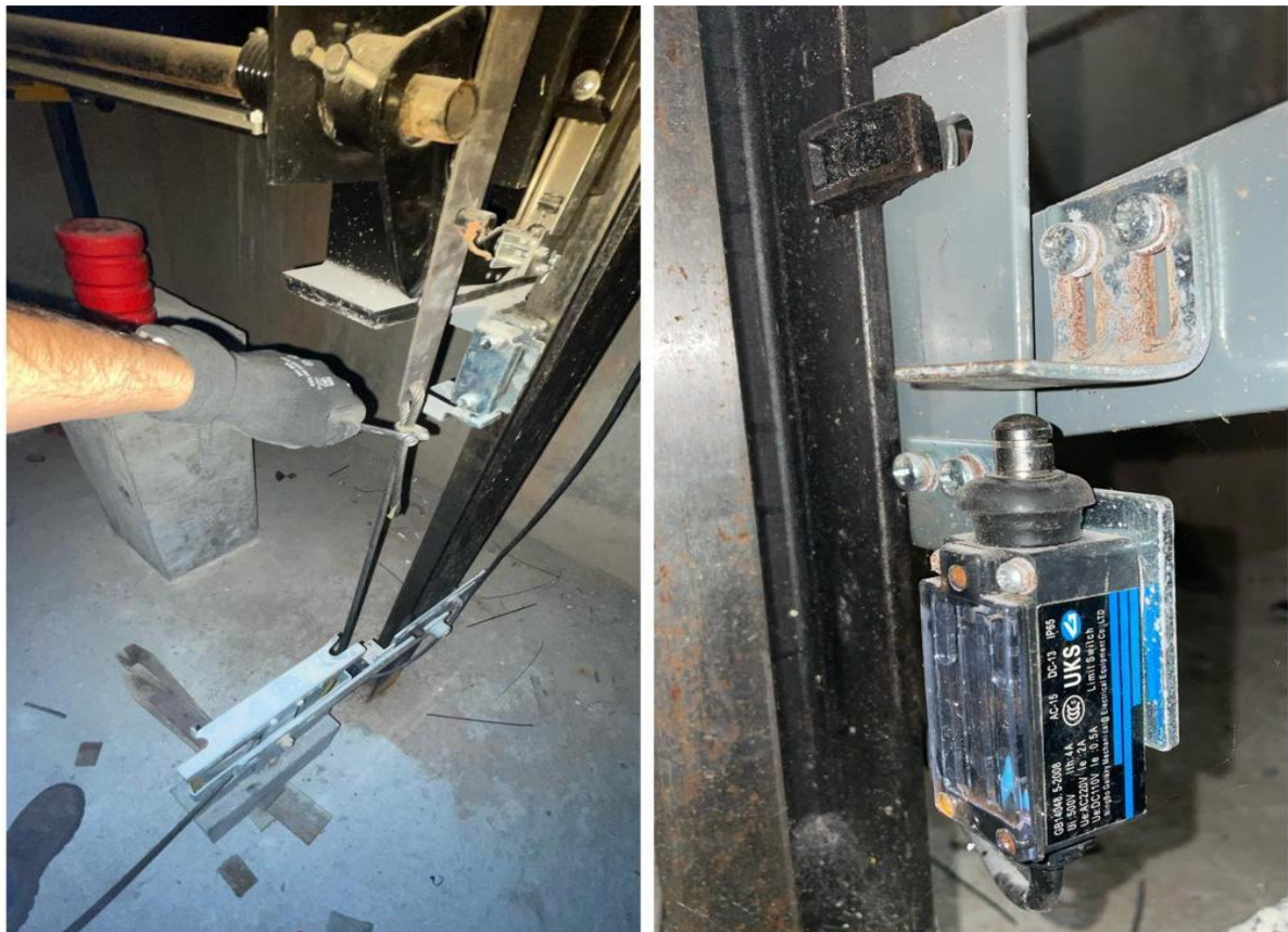
Imagem 13 - Encurtamento do cabo da polia tensora
