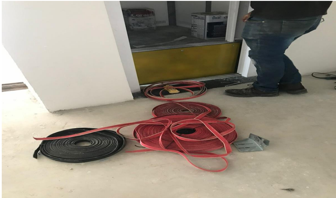
Imagem 11 - Montagem da cabina
