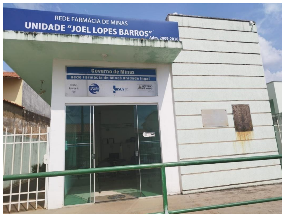
Imagem 11 – Estrutura e fachada da farmácia de Minas da cidade de Ingai/MG.
