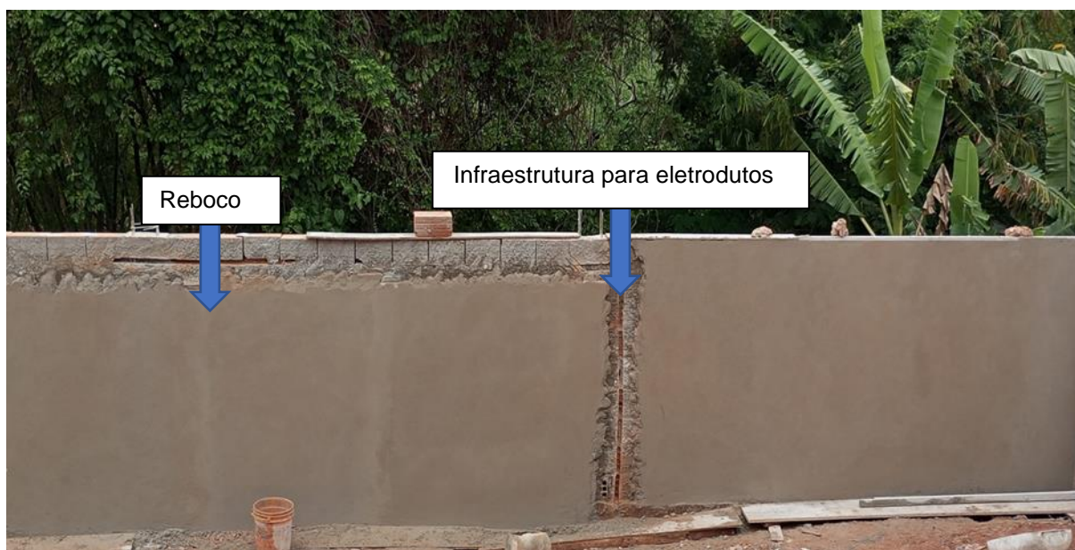
Figura 7 – Execução do Reboco e Infraestrutura para Eletrodutos
