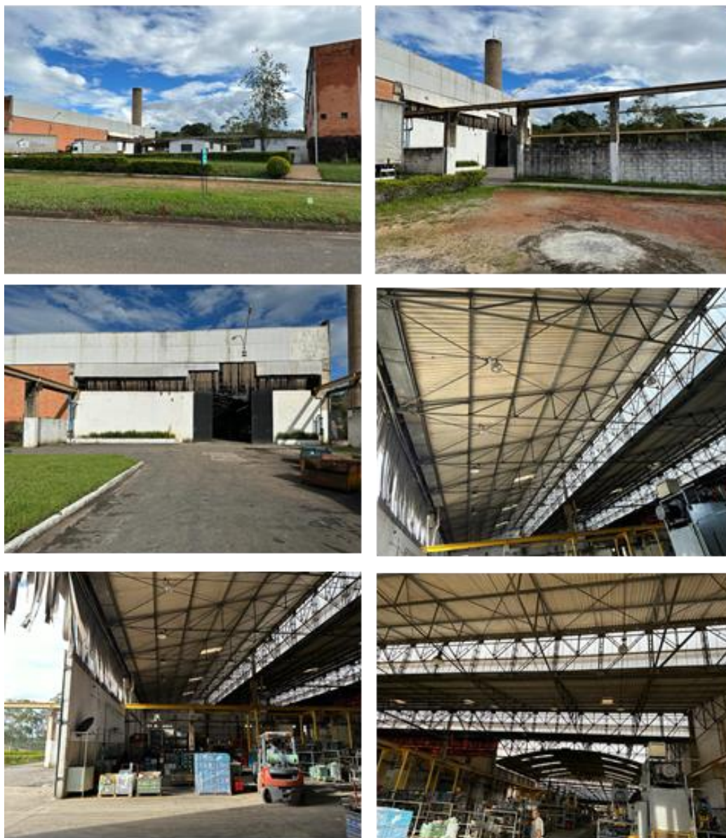
Figura 46 – Visita do local da execução da cobertura tipo Shed
