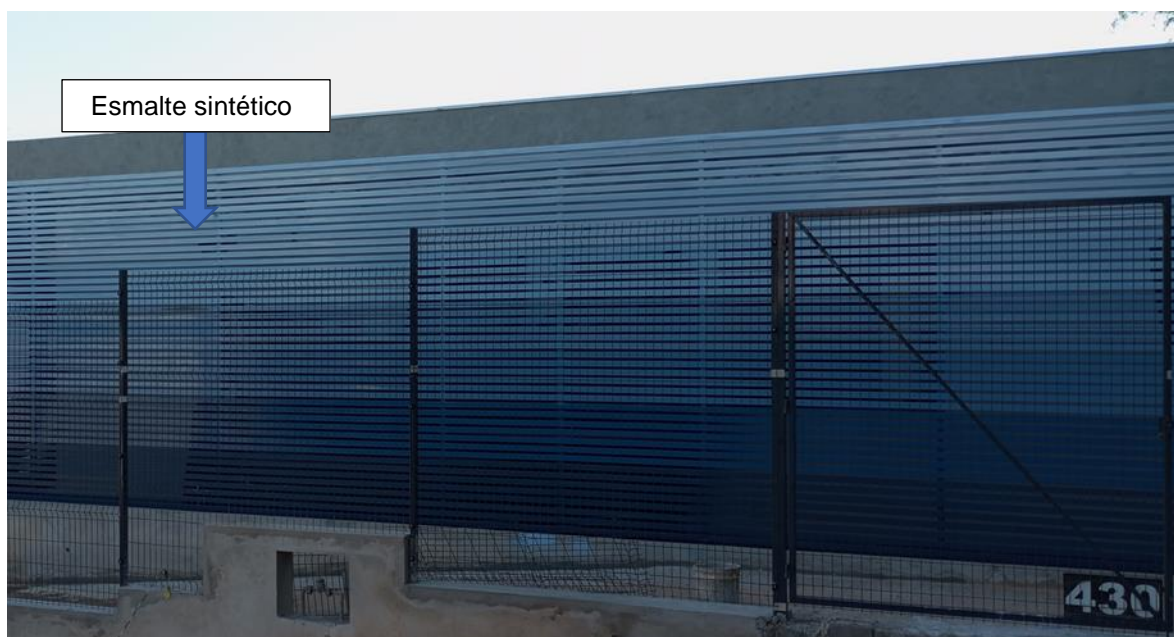
Figura 25 – Aplicação de Esmaltes Sintéticos nas Estruturas do Brise
