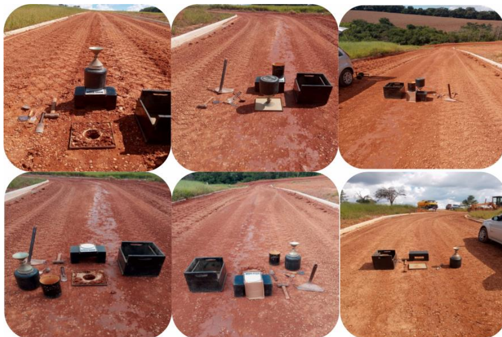
Figura 32 – Controle Tecnológico na Camada de Base
