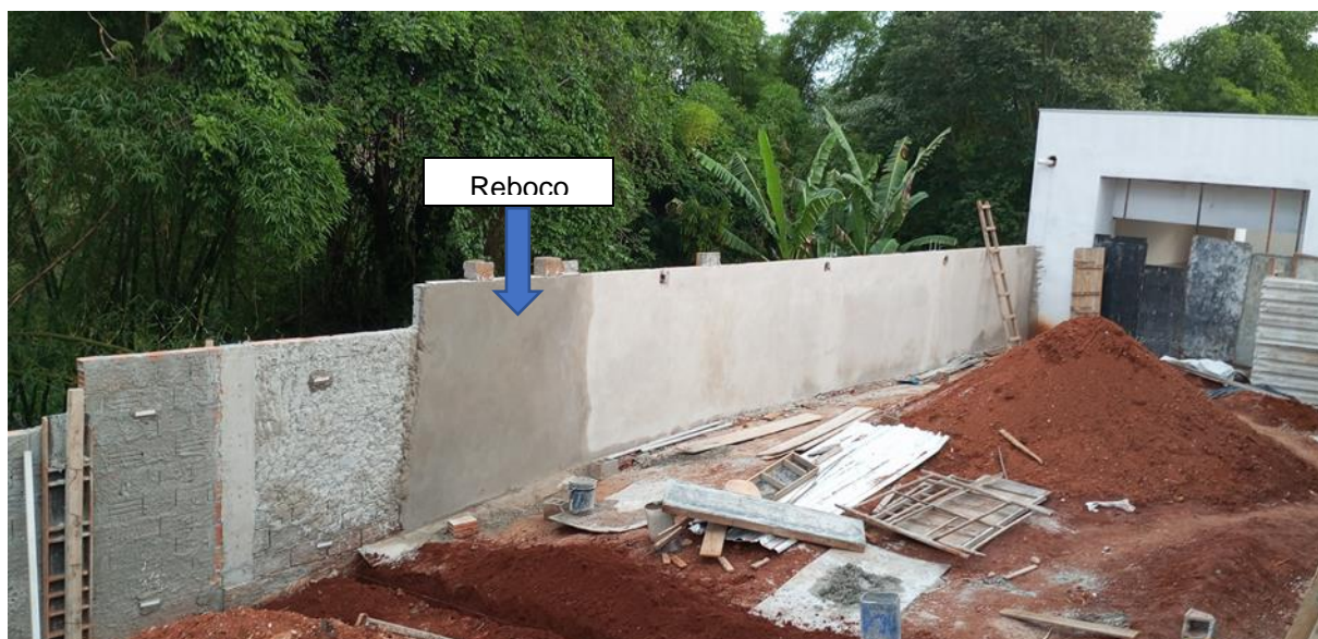
Figura 8 – Execução do Reboco
