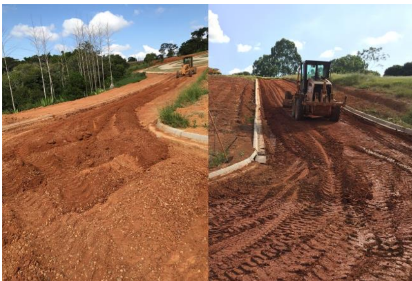
Figura 31 – Lançamento do Composto Argila e Seixo Rolado
