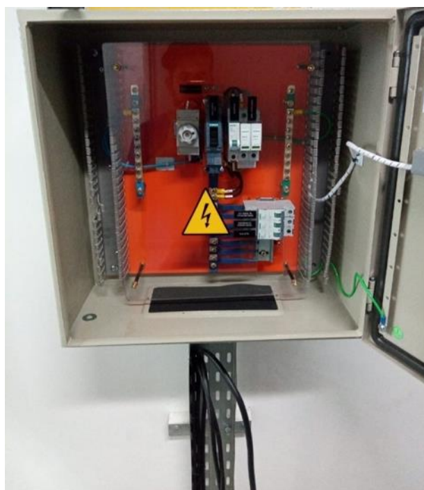
Figura 64 – Montagem dos Quadros Elétricos
