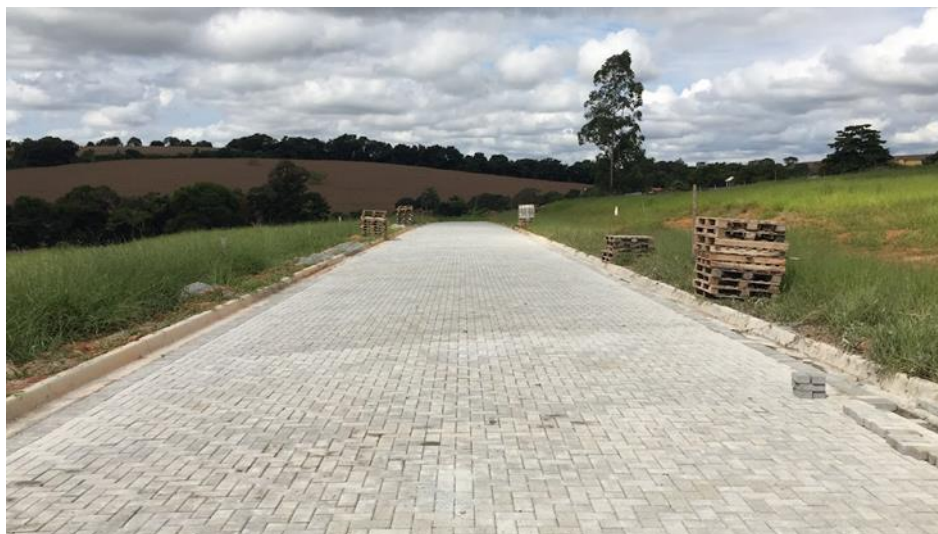
Figura 45 – Assentamento do Pavimento Intertravado
