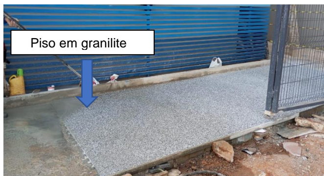
Figura 20 – Execução Piso Granilite
