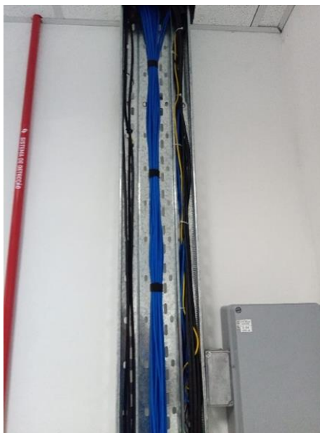
Figura 65 – Lançamento dos cabos de rede
