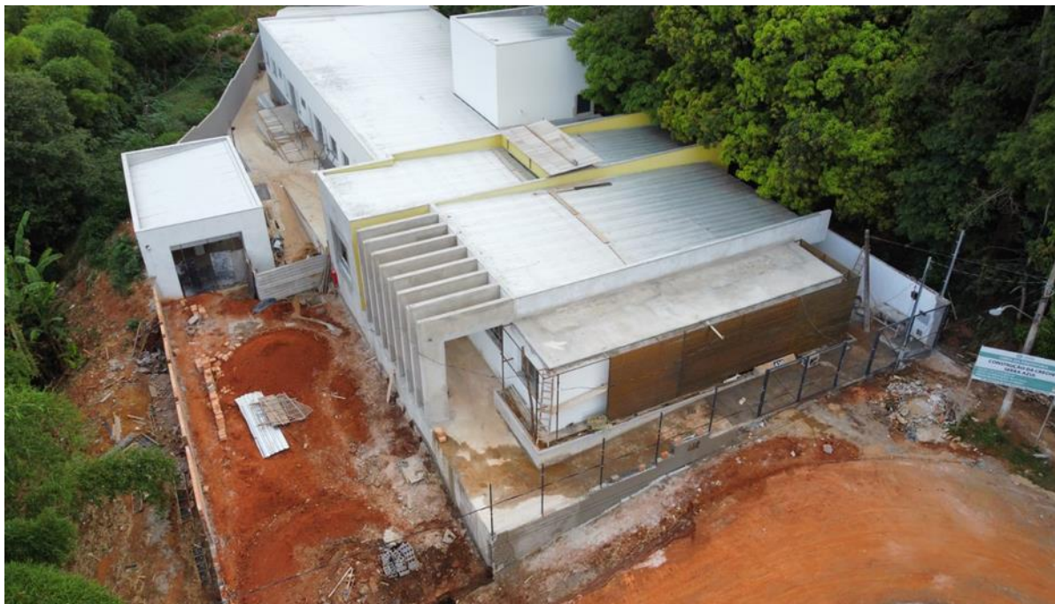
Figura 3 – Imagem Aérea do Canteiro de Obras
