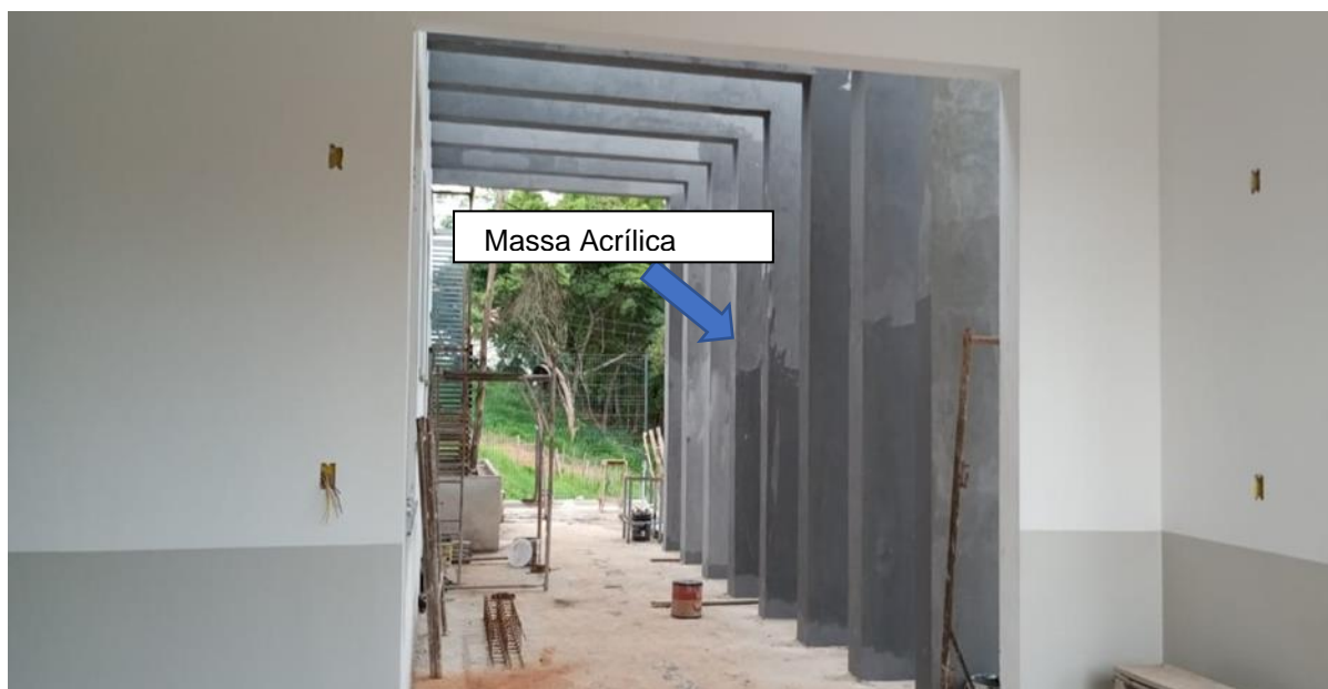
Figura 23 – Aplicação de Massa Acrílica
