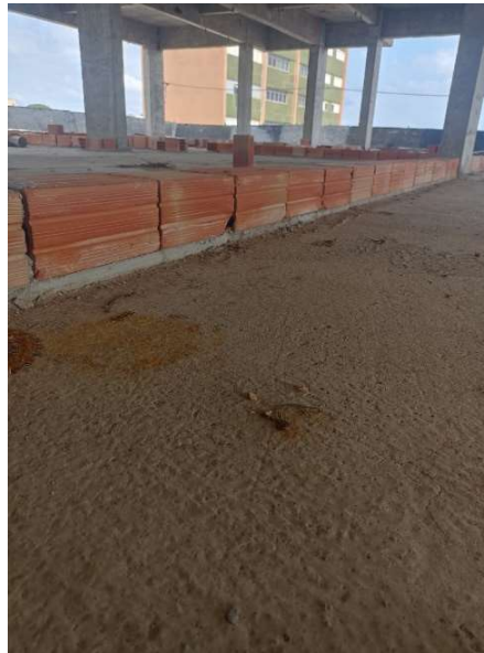
Figura 12 - Primeira fiada executada
