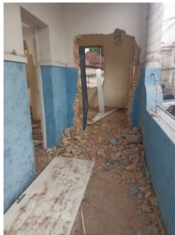
Figura 15 - Processo de retirada dos entulhos
