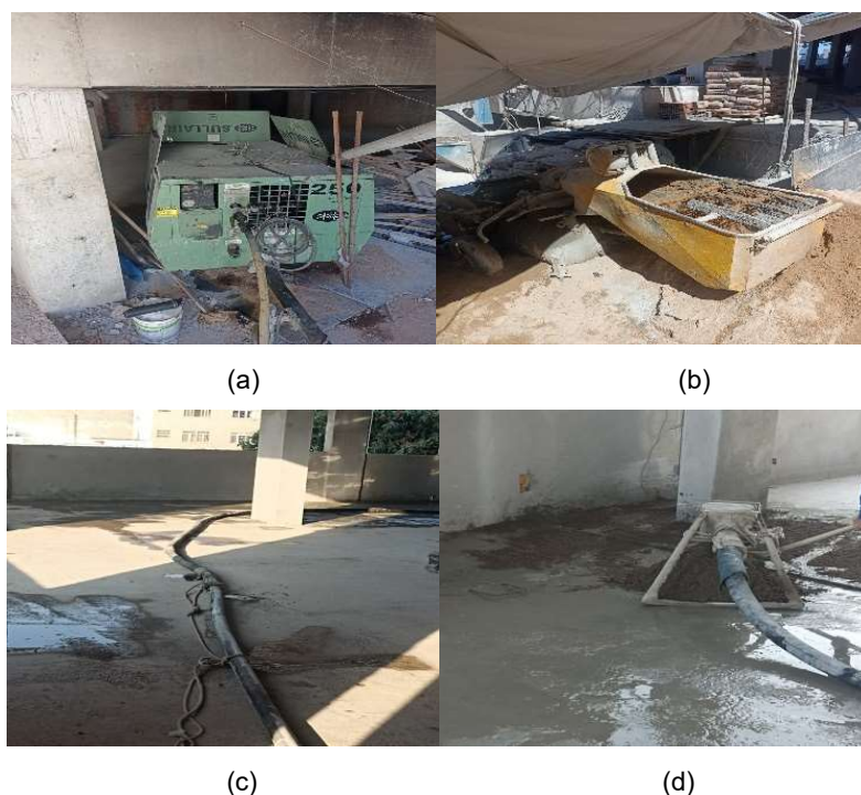
Figura 9 - Execução contrapiso do pilotis
