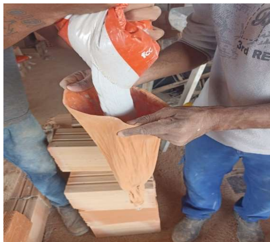
Figura 13 - Abastecimento das bisnagas com a argamassa
