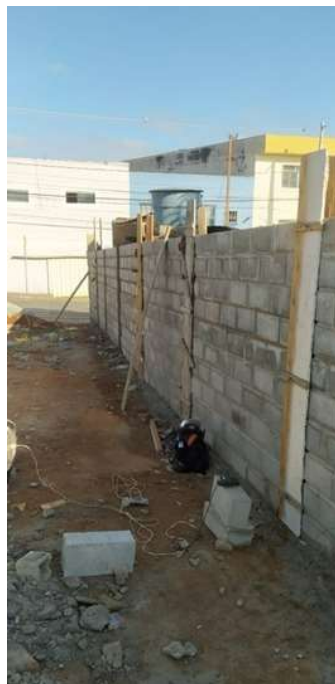
Figura 6 – Alvenaria de bloco cheio
