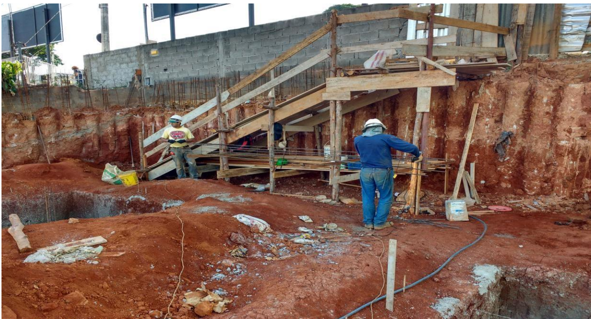
Figura 26 – Montagem dos estribos da armação do pilar.
