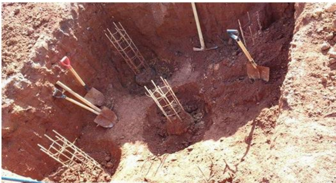
Figura 24 - Bloco da fundação escavado
