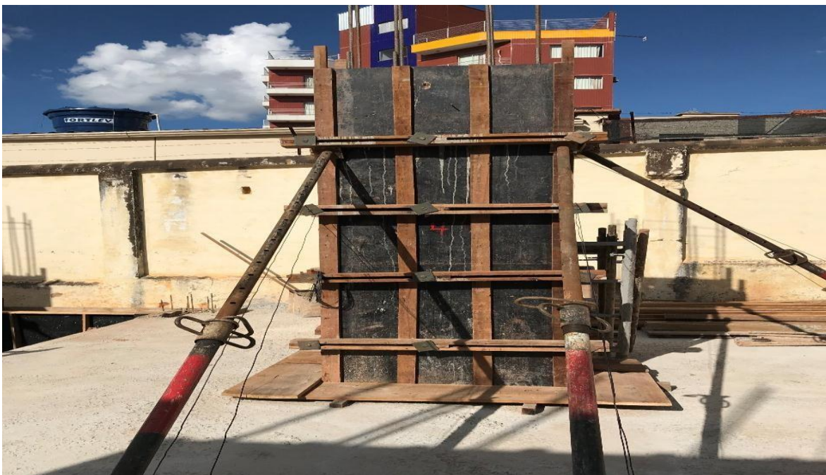
Figura 27 – Montagem da forma do pilar
