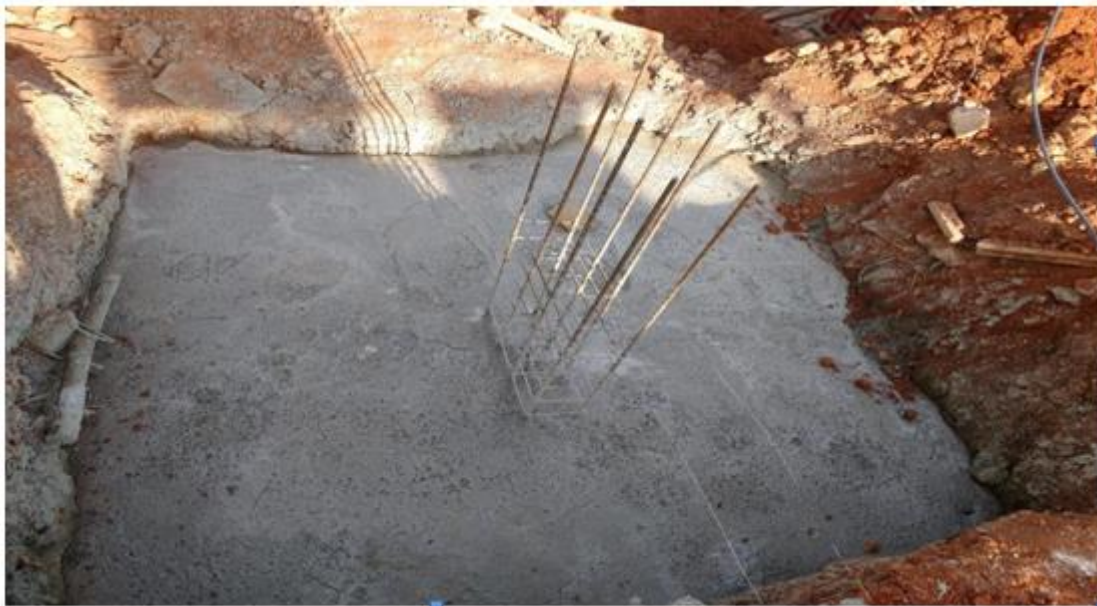
Figura 25 – Concretagem do Bloco de Fundação.
