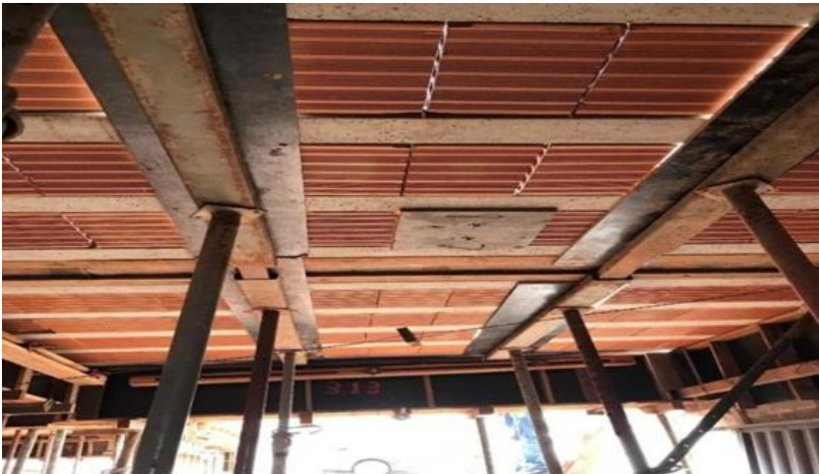
Figura 34 - Linha de escoramento laje pré-fabricada
