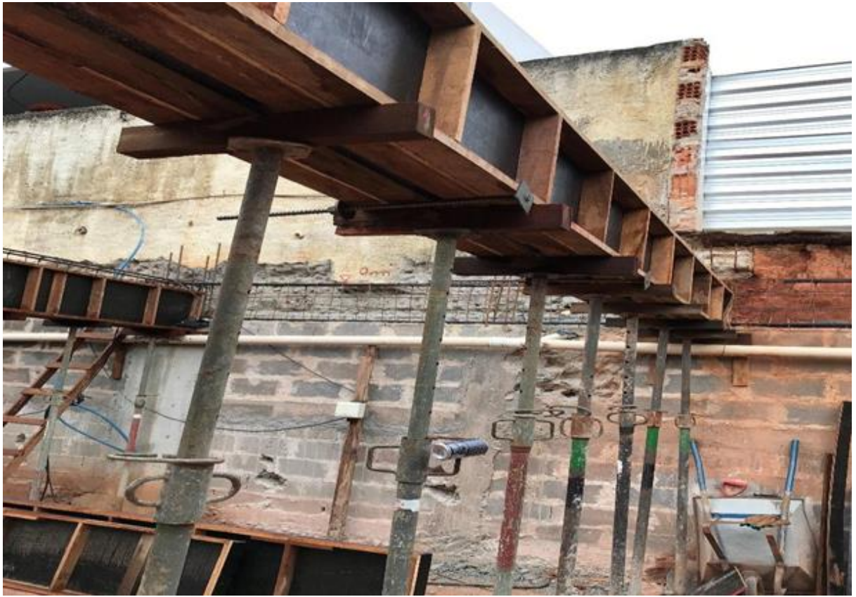
Figura 30 - Placas de apoio para escoramento
