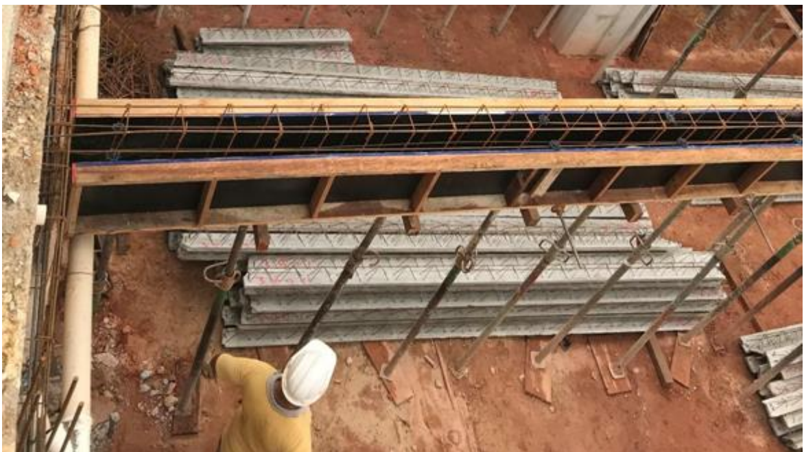
Figura 31 - Placas de apoio para escoramento
