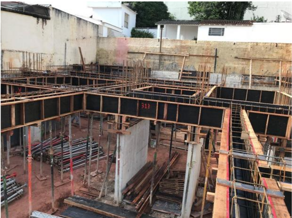
Figura 29 - Escoras metálica
