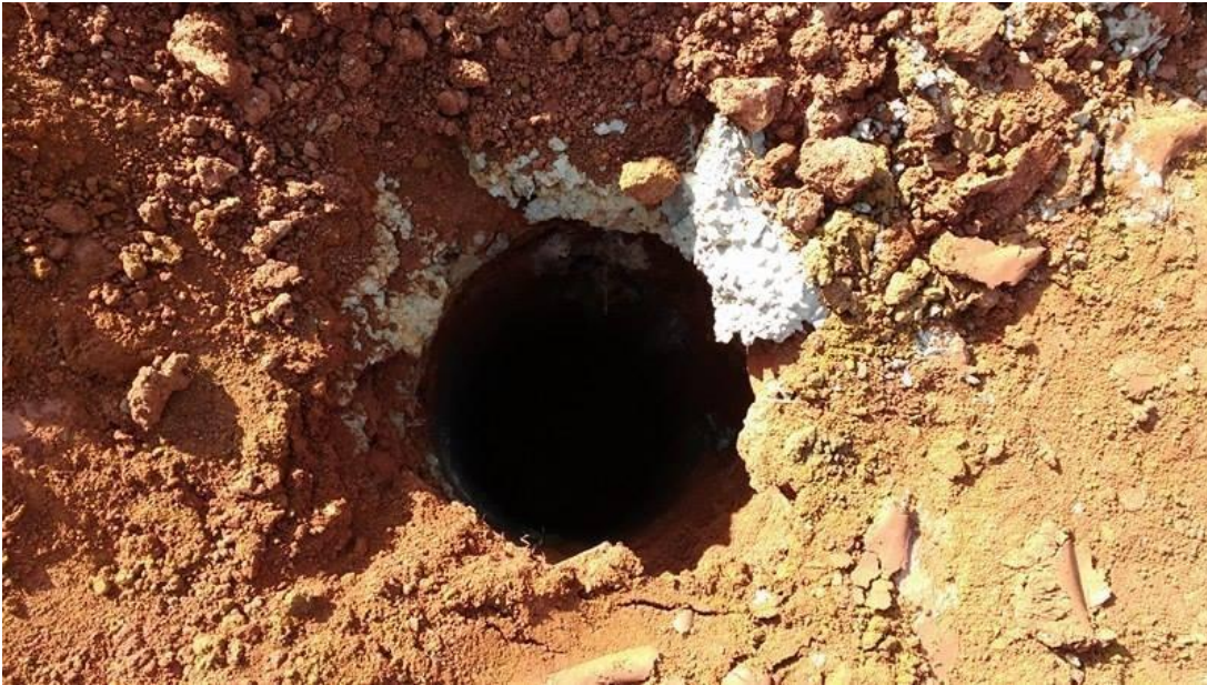
Figura 22 – Perfuração das Estacas com Trado Mecanizado
