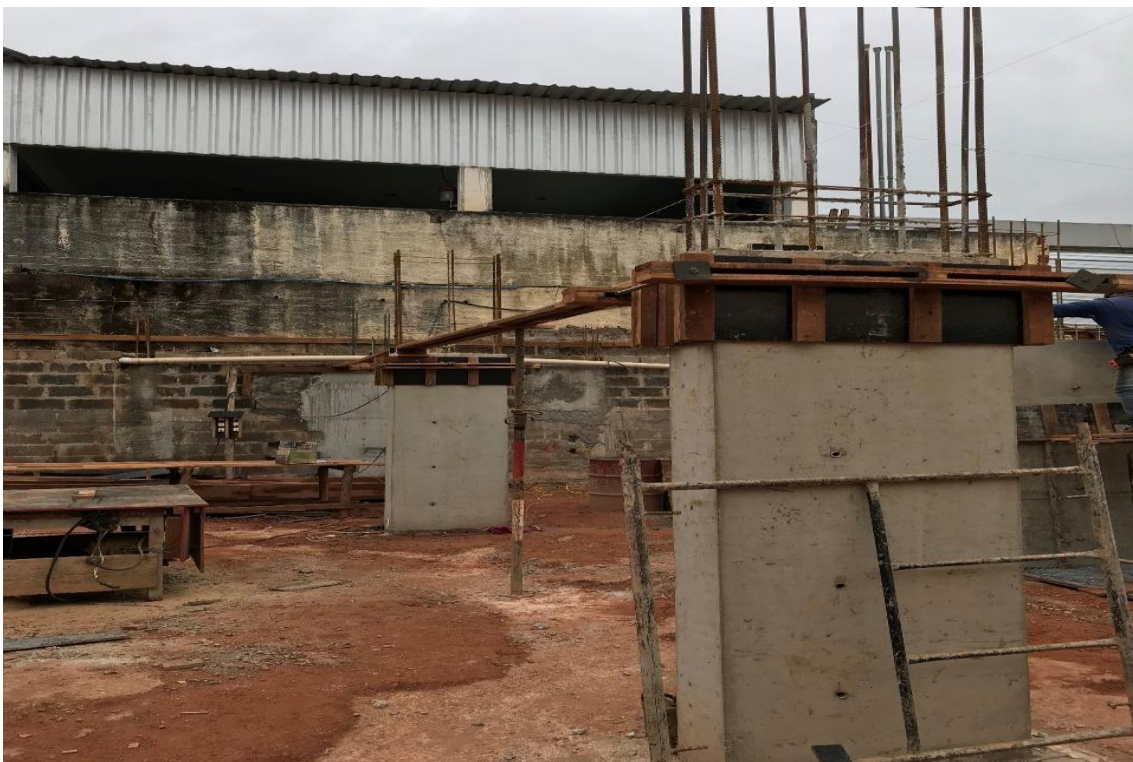
Figura 28 – Pilar concretado
