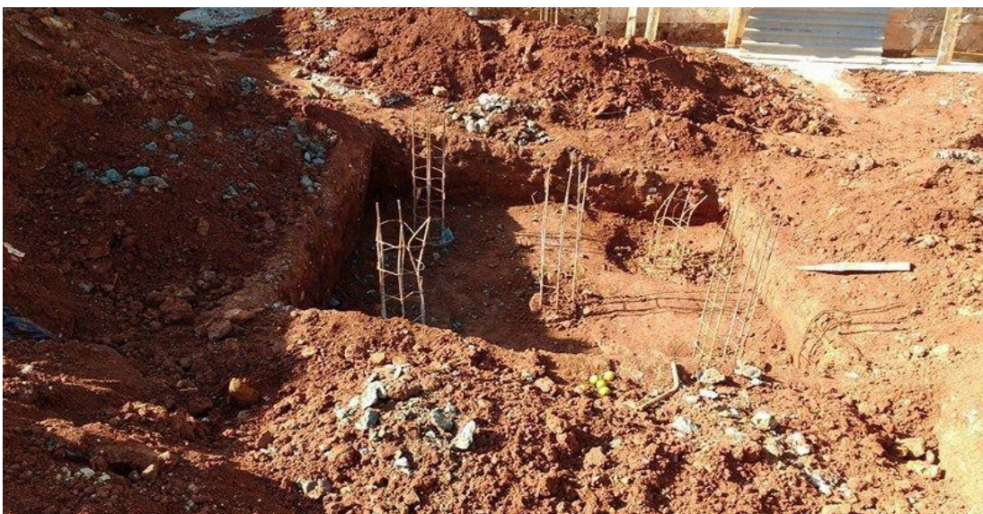
Figura 23 - Bloco da fundação sendo escavado
