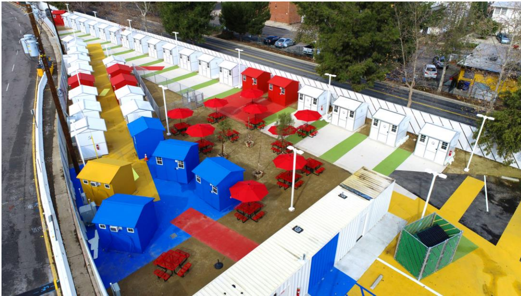
Imagem 2: Vista da Edificação
