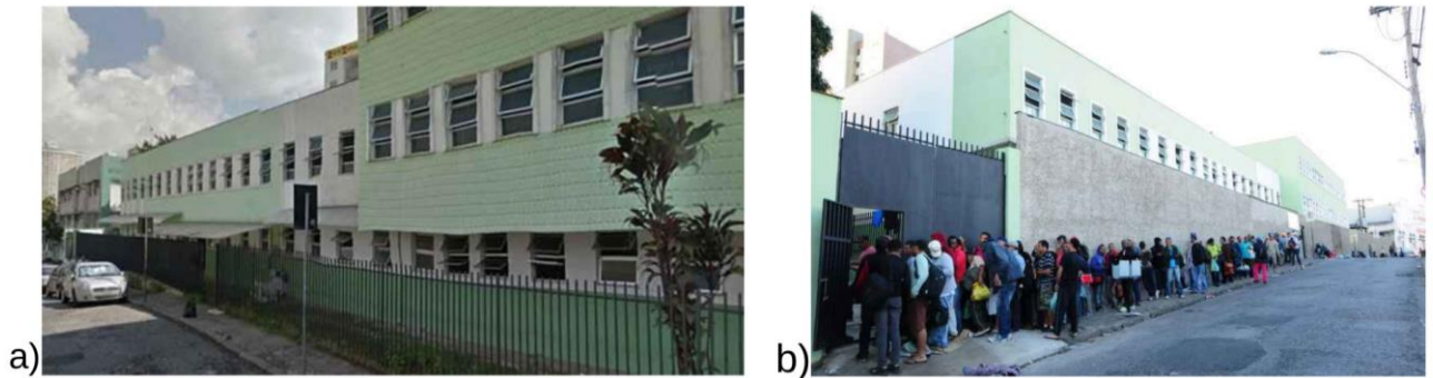
Imagem 11: a) Fachada Frontal Antiga b) Fachada Frontal Atual
