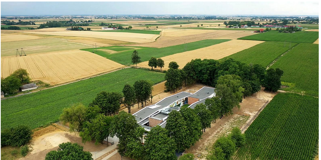
Imagem 7: Vista da Edificação
