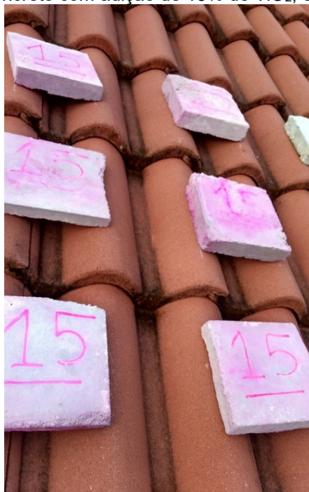
Figura 16 – Placas de concreto com adição de 15% de TiO_2 , expostas ao clima urbano
