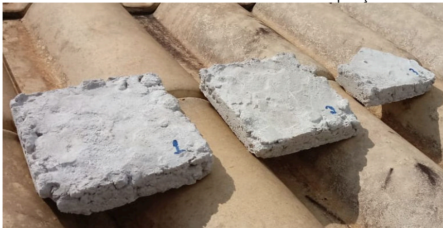
Figura 17 – Placas de concreto manchadas com cinzas em exposição aos raios UV
