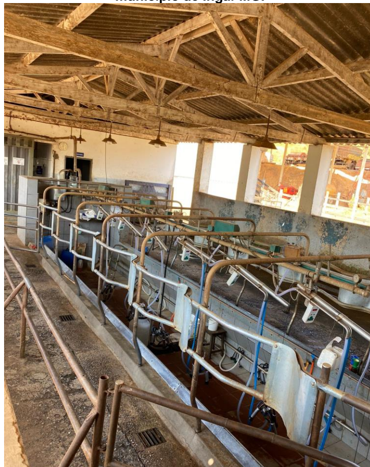
Imagem 3 – Sala de ordenha tipo fosso espinha de peixe localizada em uma fazenda no município de Ingaí-MG.
