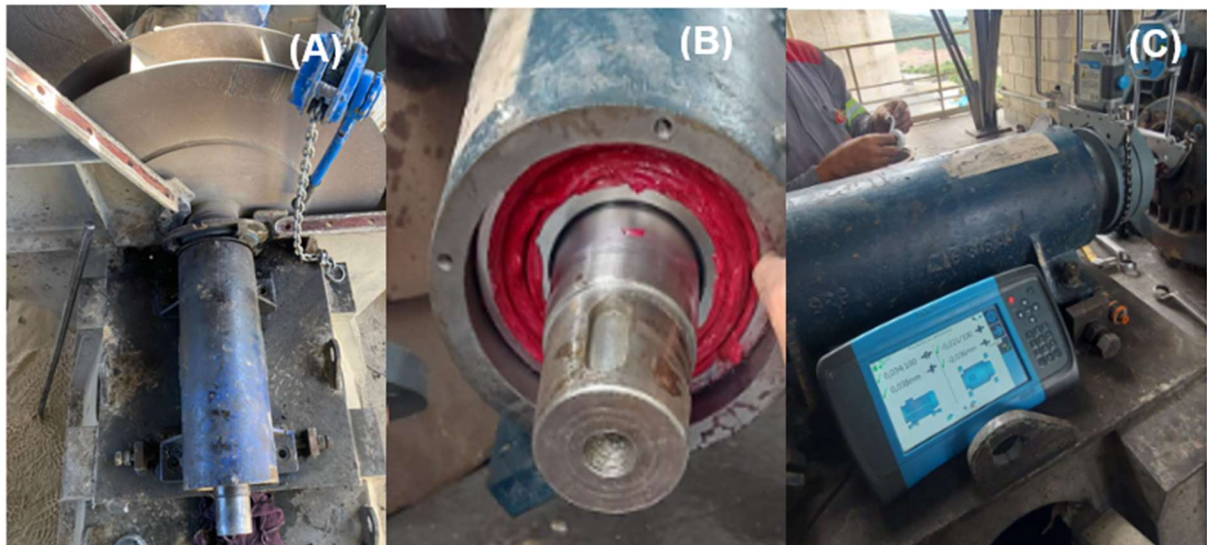
Figura 38 - Substituição dos Rolamentos
