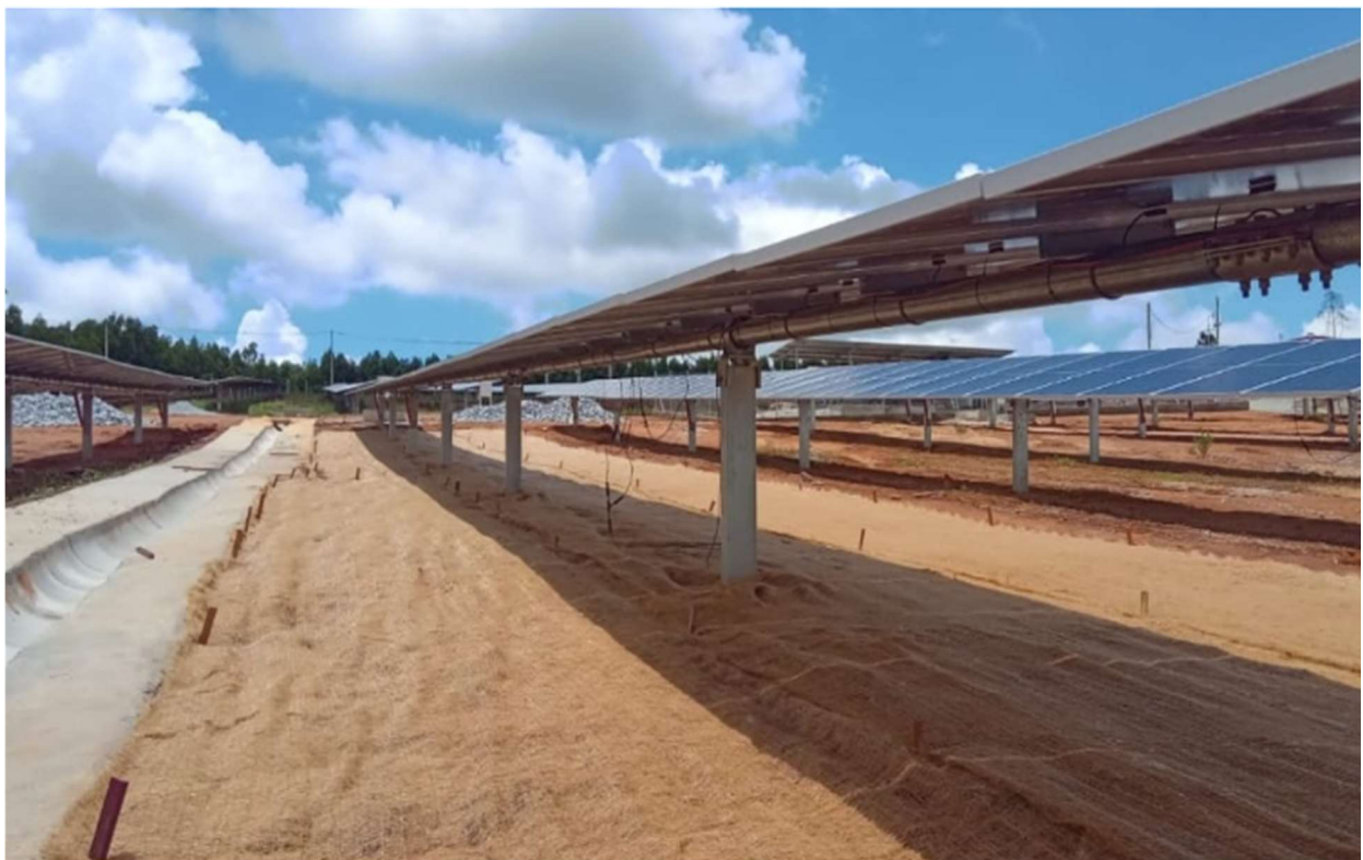
Figura 2- Estrutura fotovoltaica móvel - Tracker
