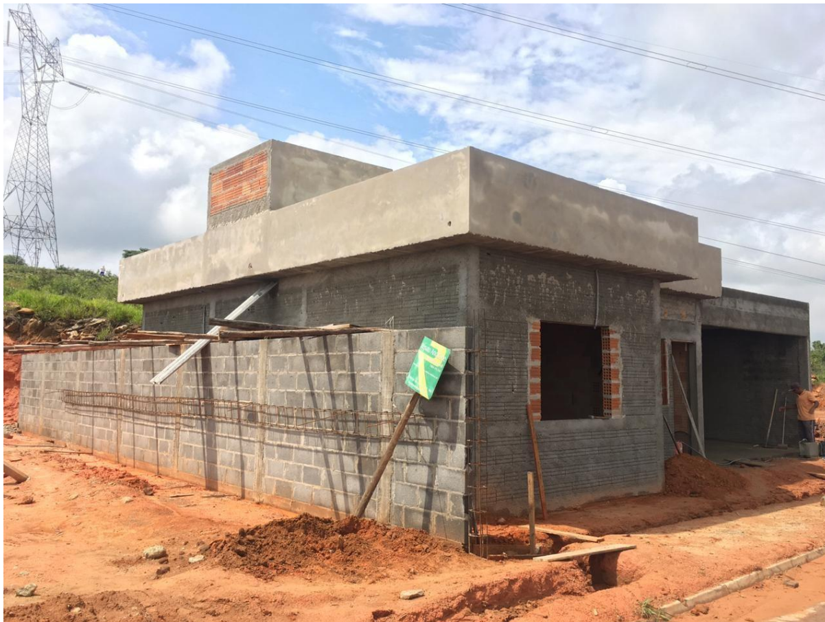
Figura 59 - Área externa recebendo chapisco e reboco
