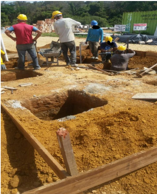
Figura 67 - Escavação das sapatas e locação da obra
