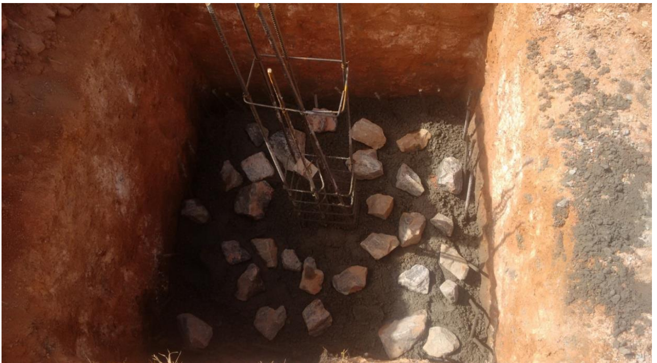
Figura 85 - Blocos concretados
