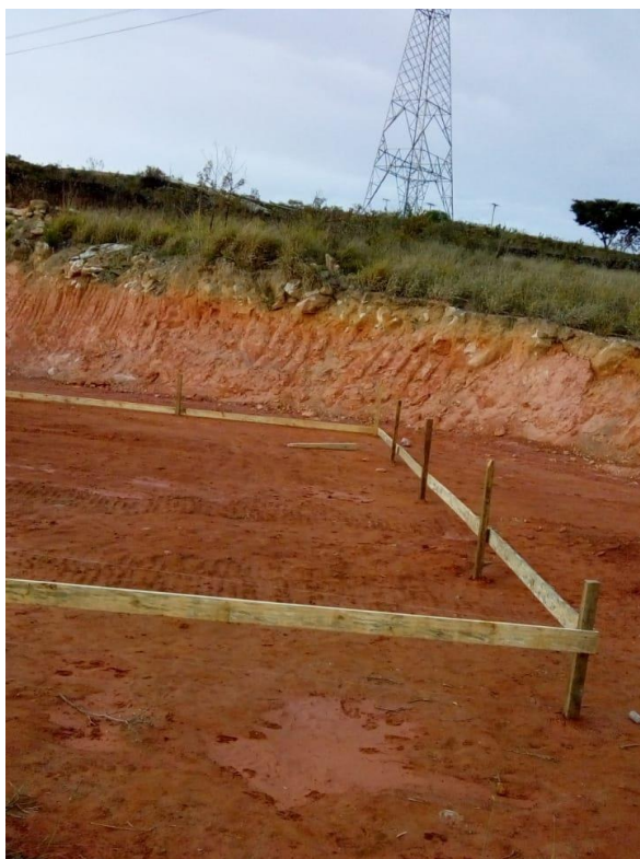
Figura 54 - Montagem de Gabarito
