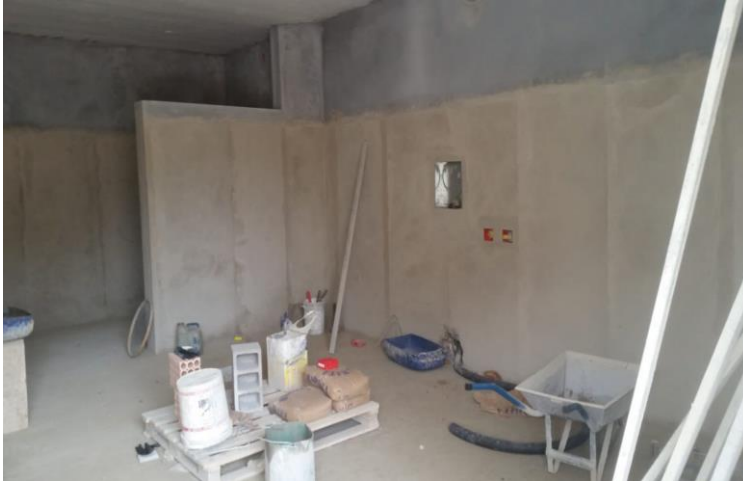
Figura 64 - Reboco com argamassa baritada concluído
