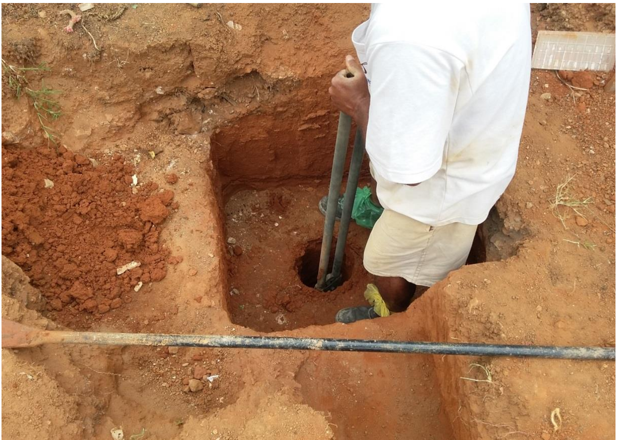
Figura 28 – Cava da Sapata
