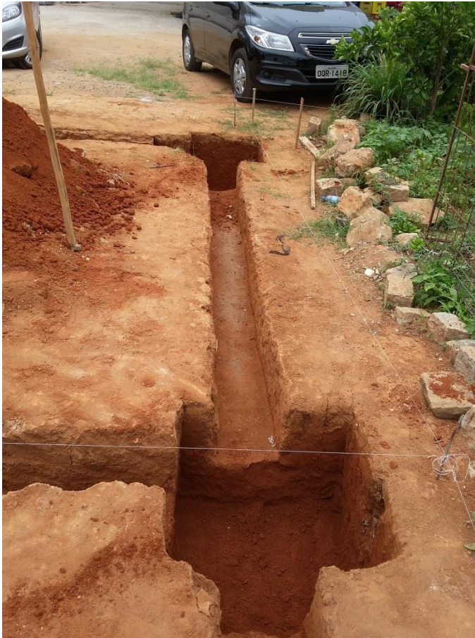
Figura 27 – Vala onde será concretada a sapata
