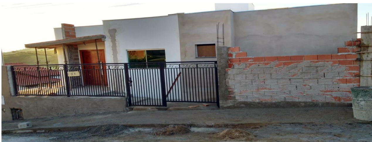
Figura 89 - Alvenaria concluída
