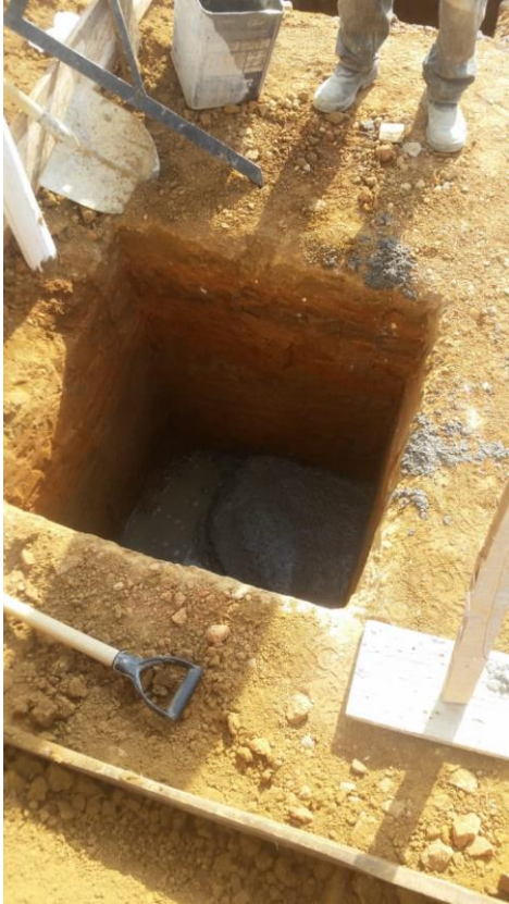
Figura 68 - Disposição do concreto magro
