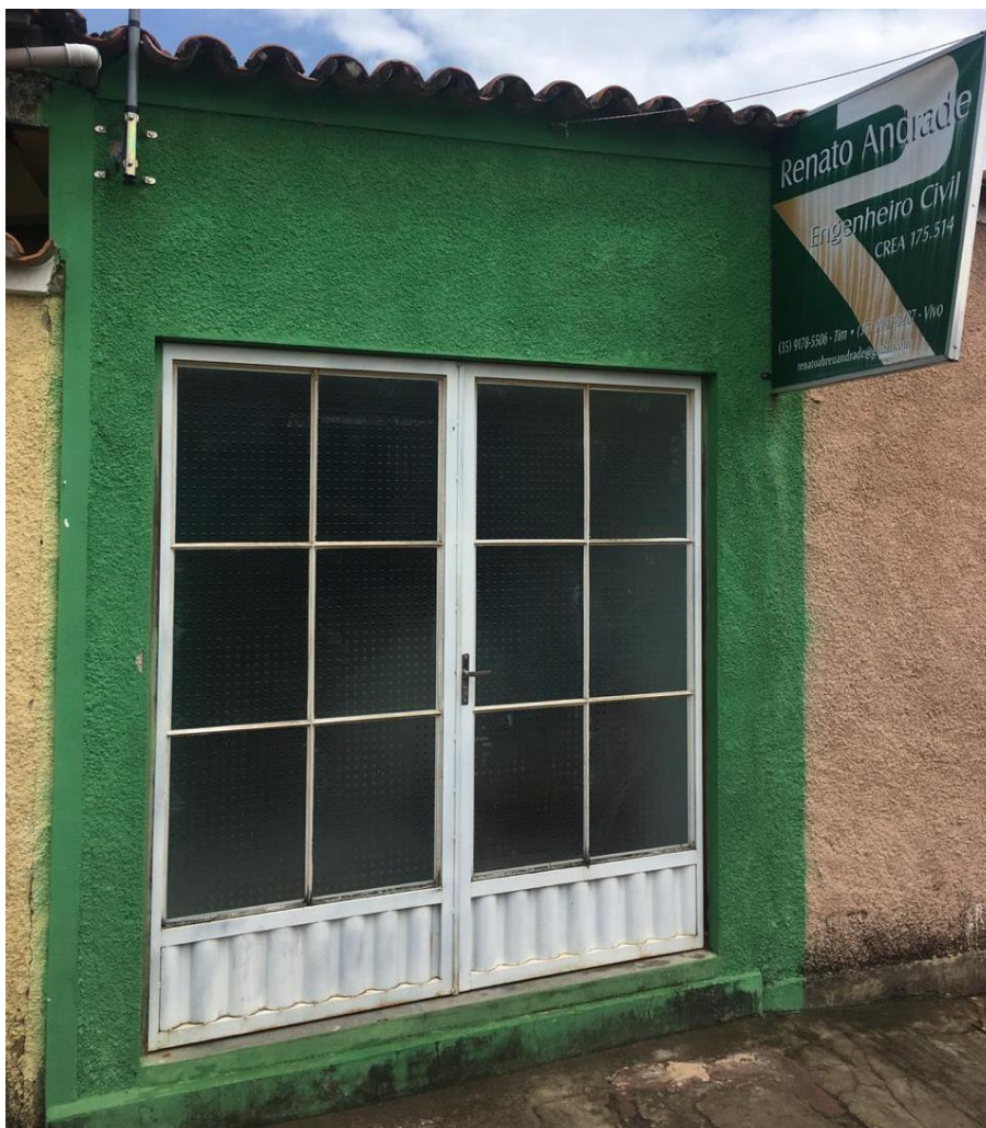
Figura 43 - Fachada do escritório onde foi realizado o estágio
