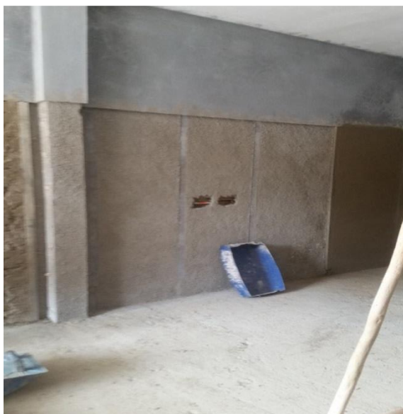
Figura 63 - Parede chapiscada
