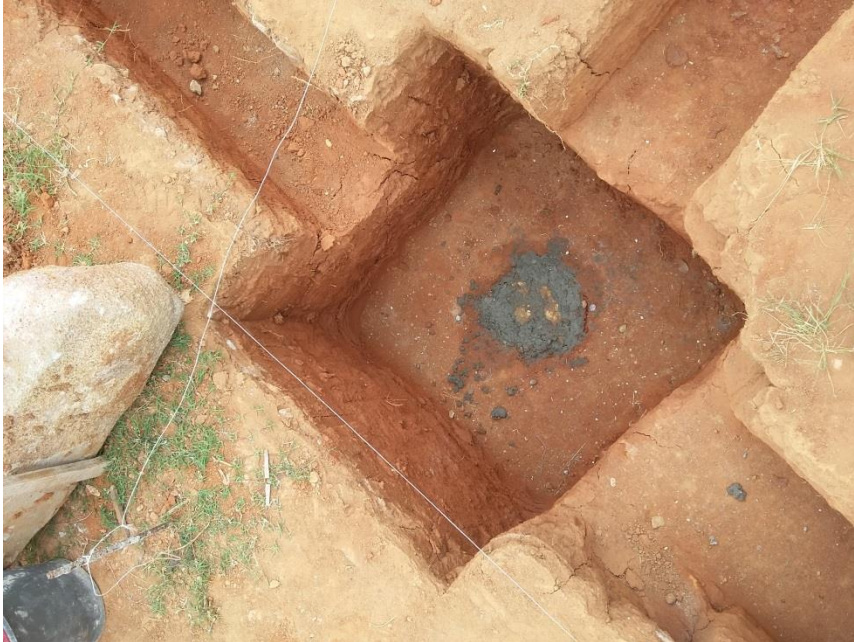
Figura 29 - Concretagem da cava
