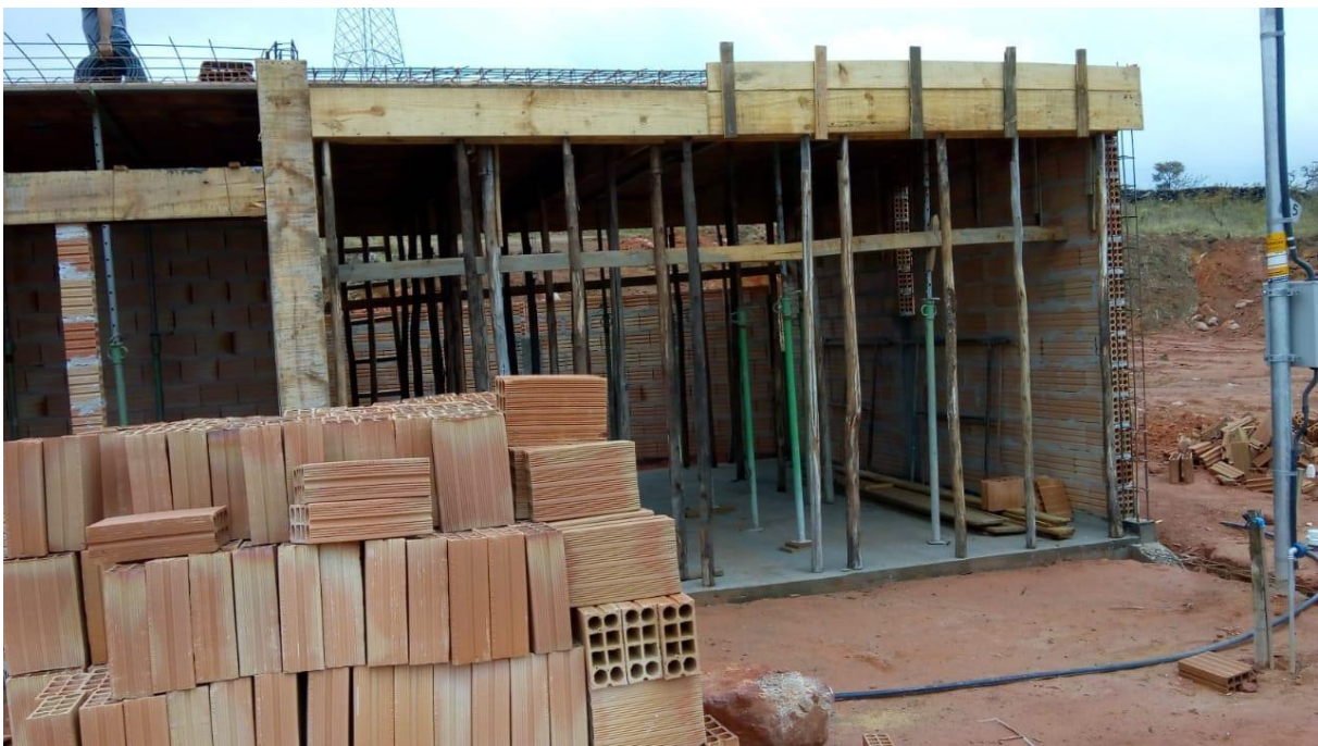
Figura 56 - Escoramento da laje
