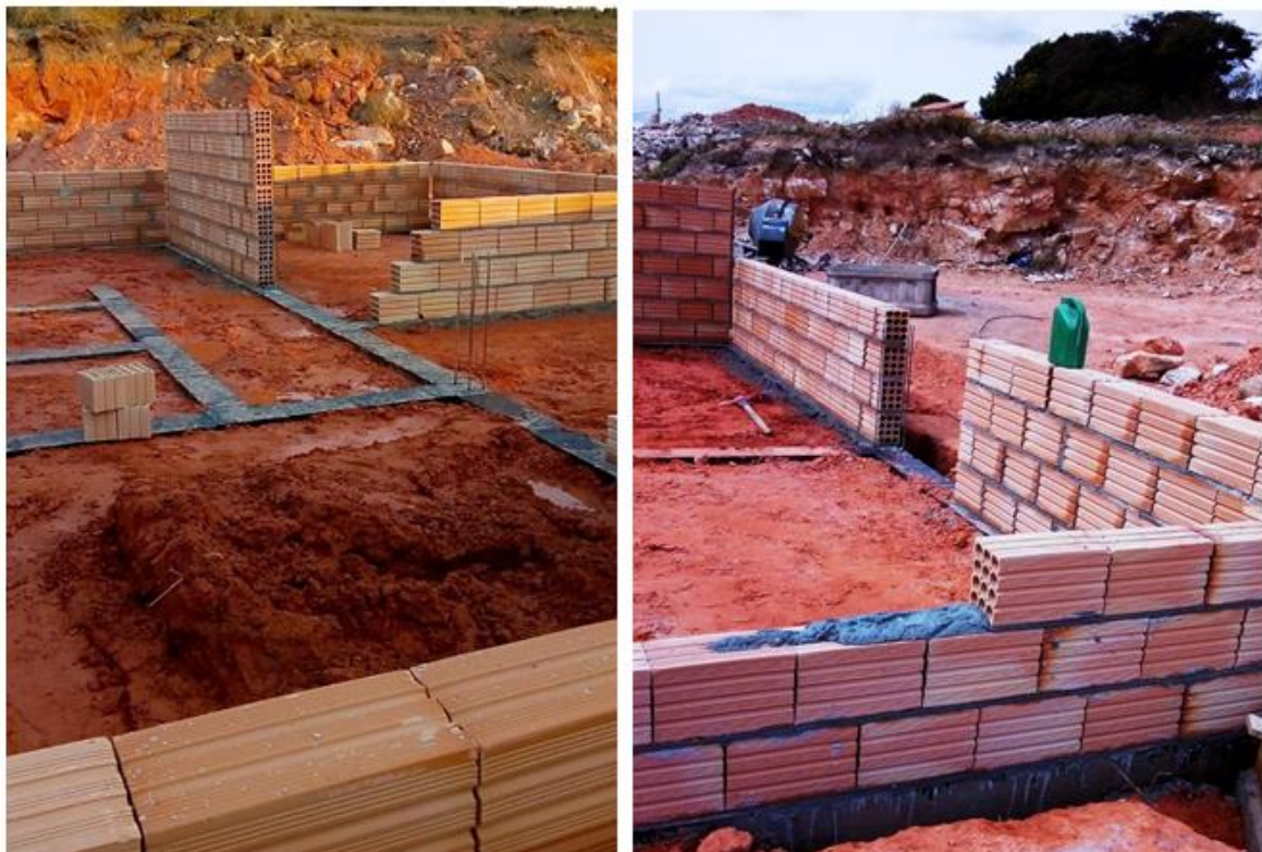
Figura 55 - Levantamento de Parede
