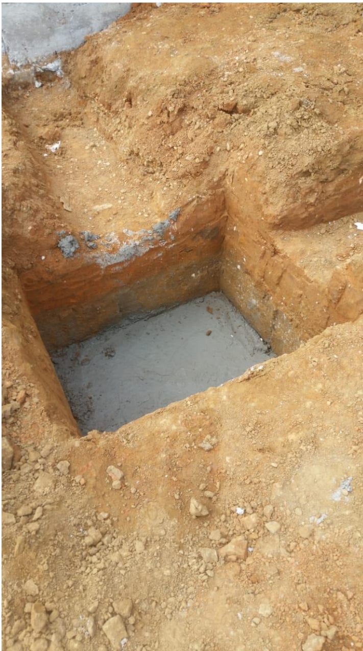
Figura 69 - Concreto magro pronto para receber a armação da sapata
