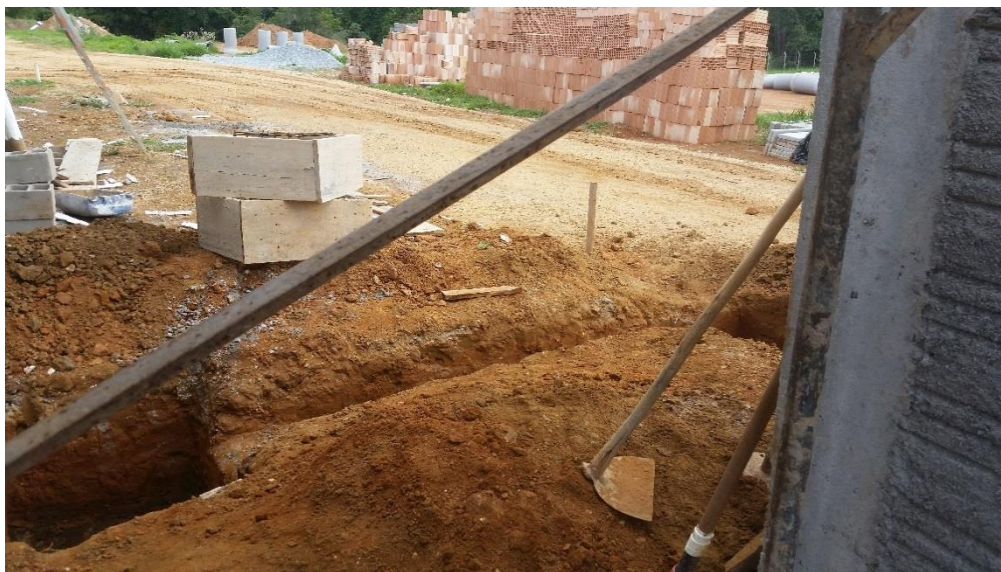
Figura 70 - Fôrmas da sapata
