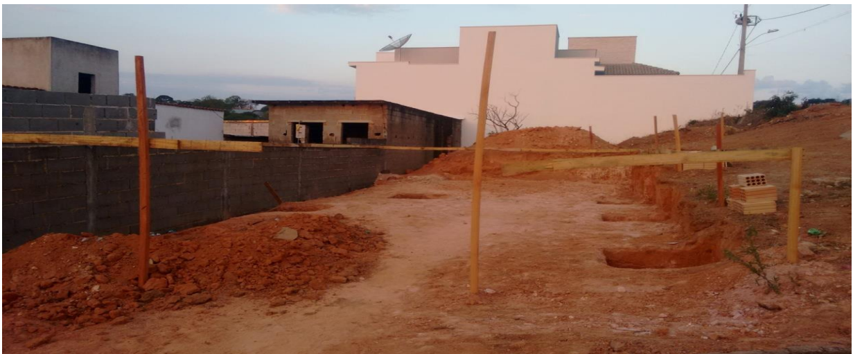
Figura 84 - Blocos de fundação
