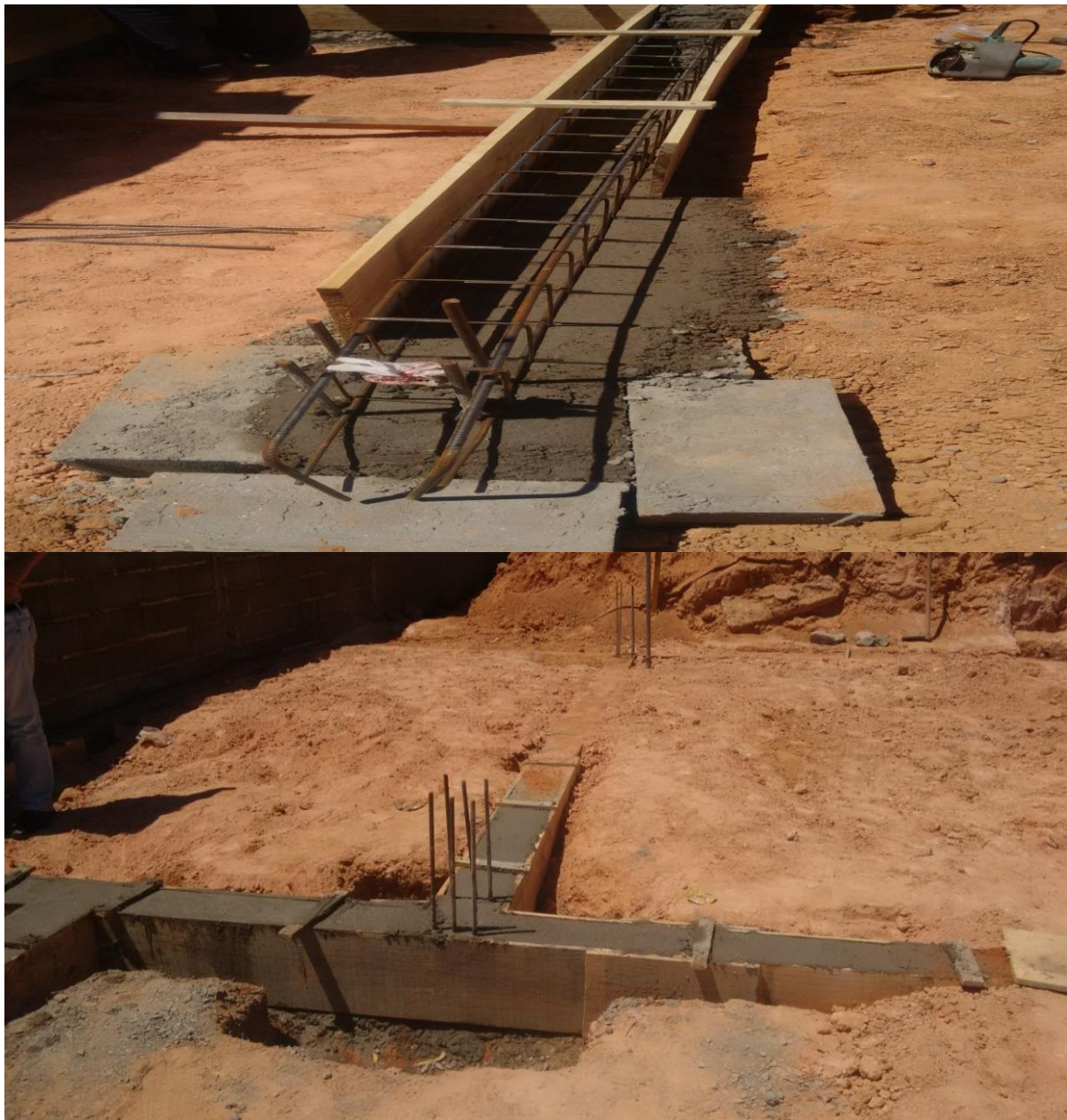
Figura 86 - Construção das Valas e resultado final
