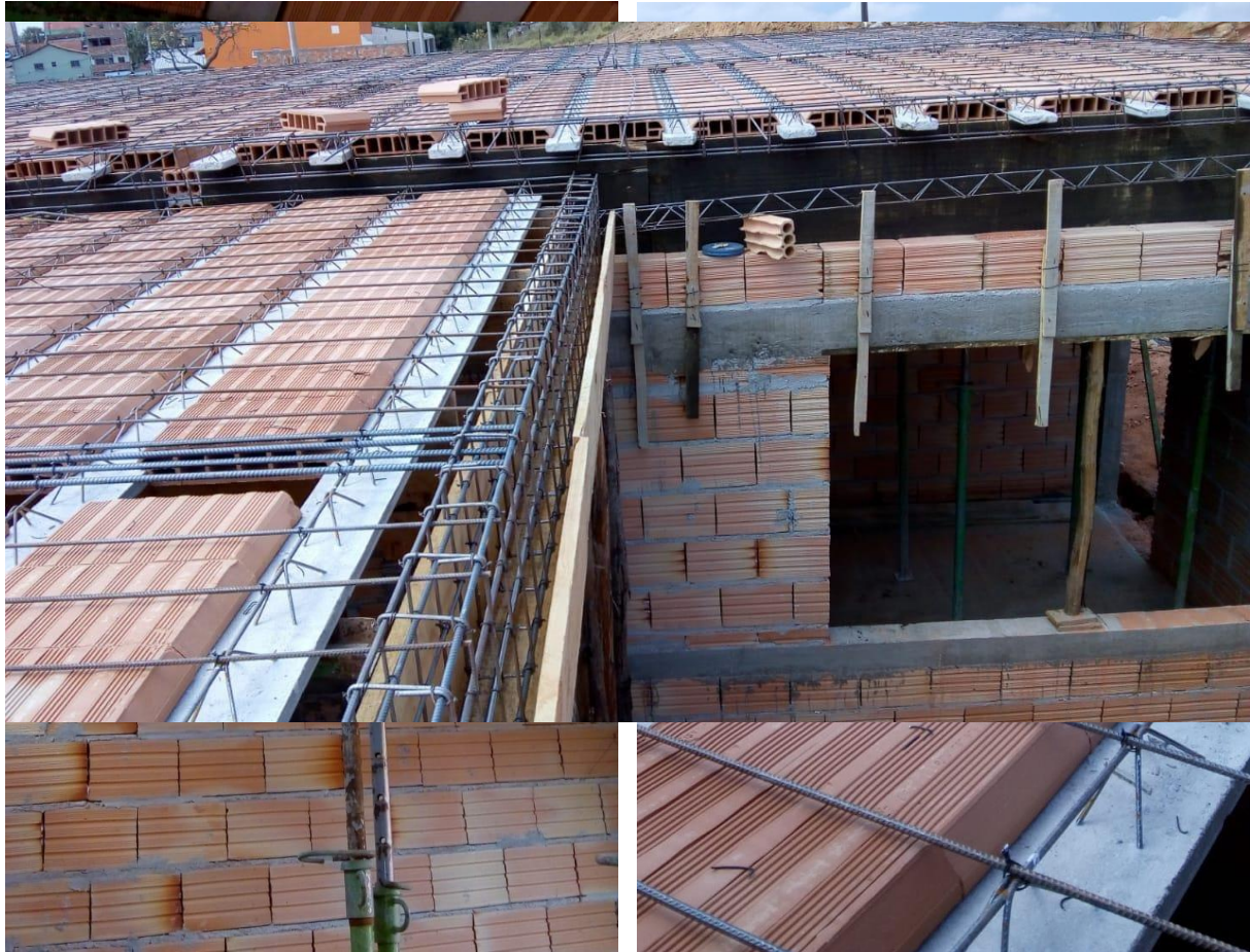
Figura 57 - Laje treliçada com lajotas cerâmicas
