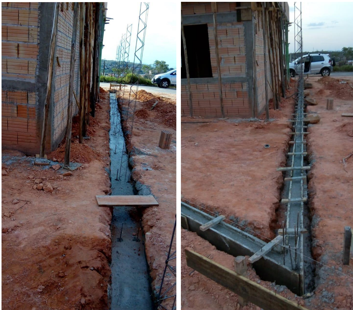
Figura 58 - Construção do muro
