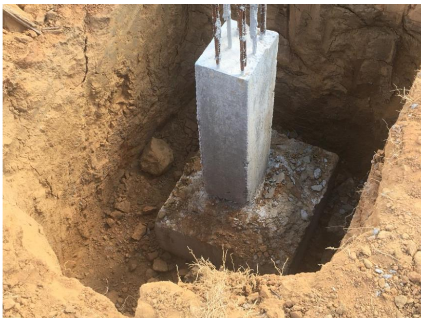
Figura 72 - Sapata concluída
