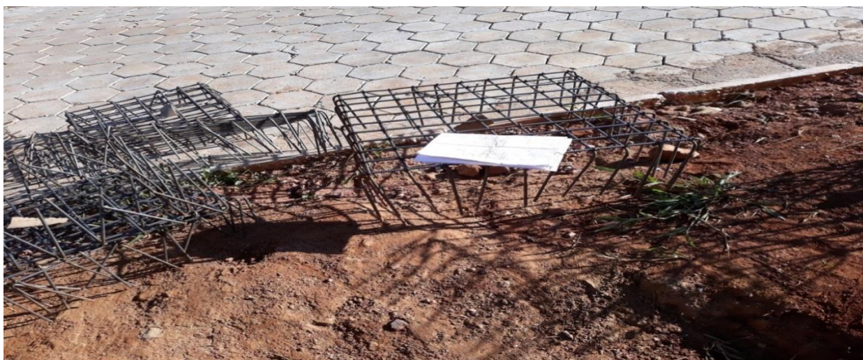
Figura 95 - Sapata Armada
