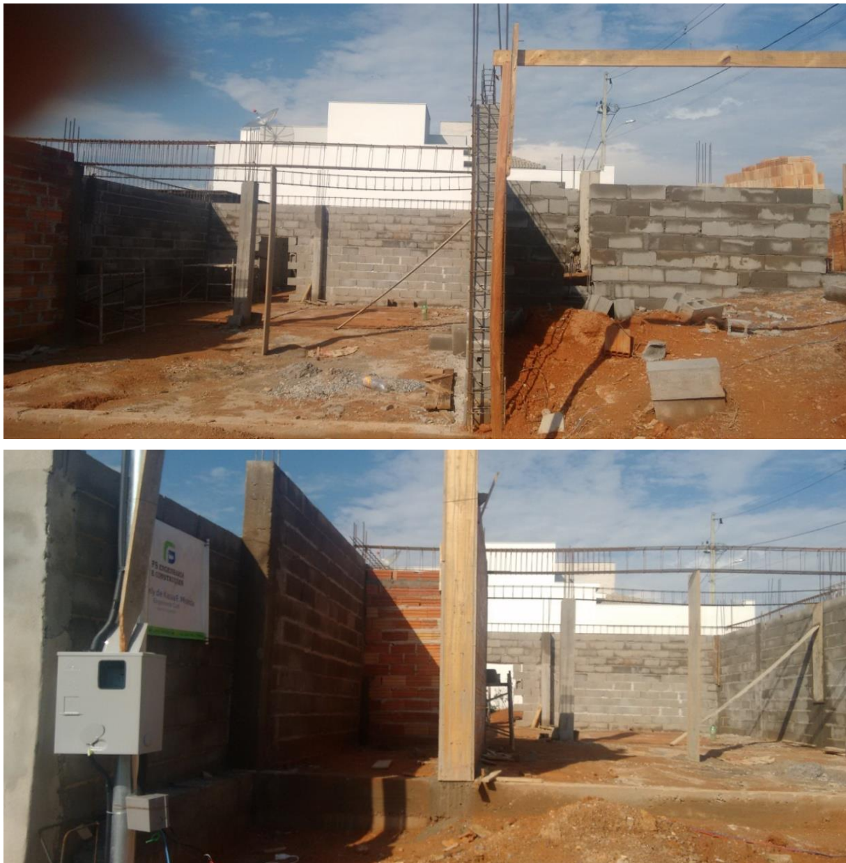
Figura 87 – Alvenarias e vigas
