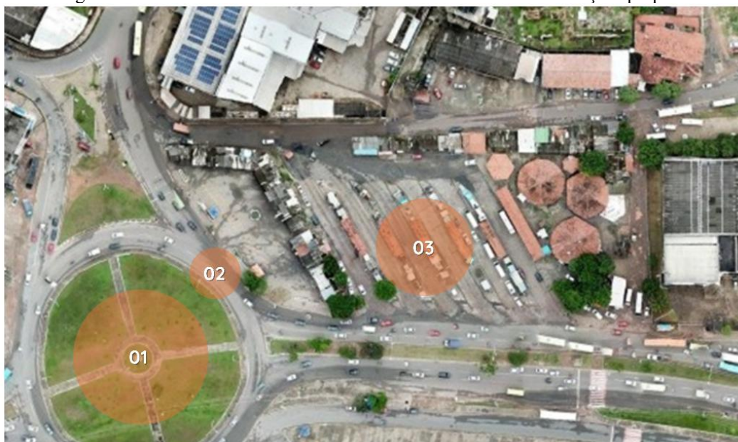
Imagem 11 - Vista aérea do Terminal Rodoviário da antes das intervenções propostas.
