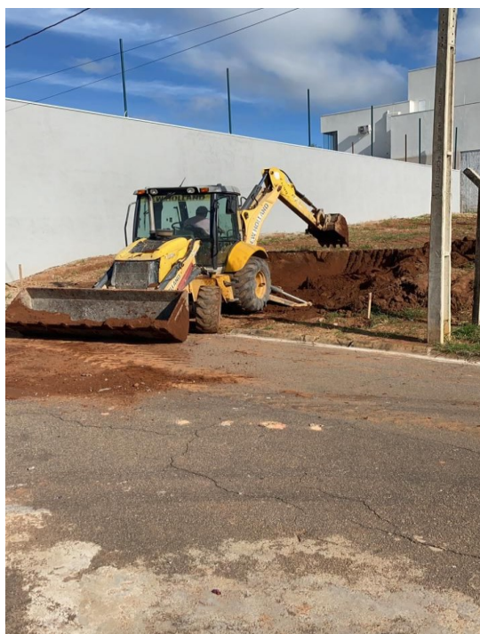
Figura 50 - Retirada de solo do terreno
