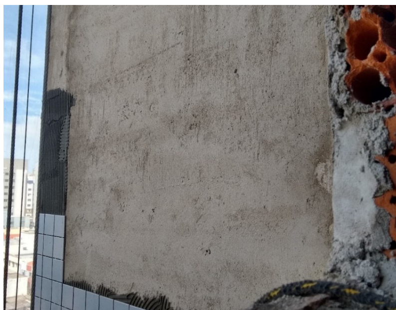
Figura 102 - Assentamento de pastilhas
