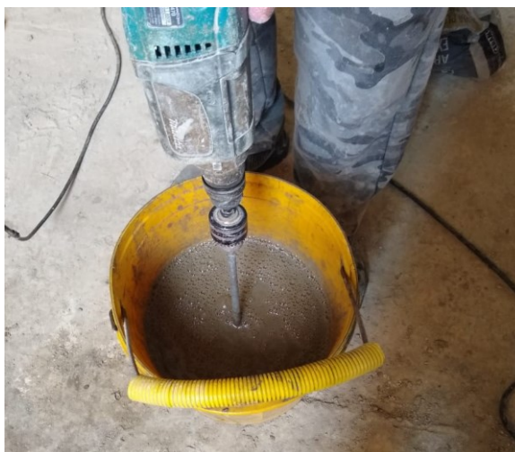
Figura 99 - Argamassa sendo preparada
