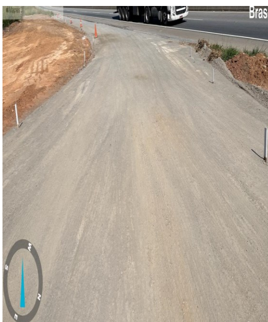
Figura 80 - Estaqueamento de orientação de campo base projetada
