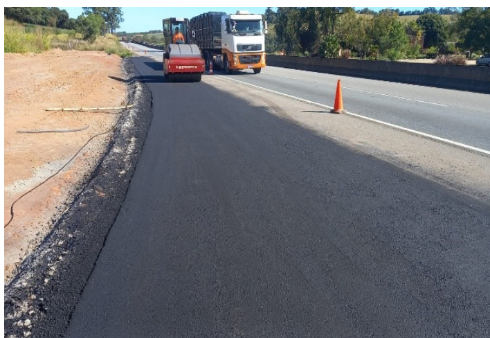
Figura 82 - Acompanhamento da pavimentação
