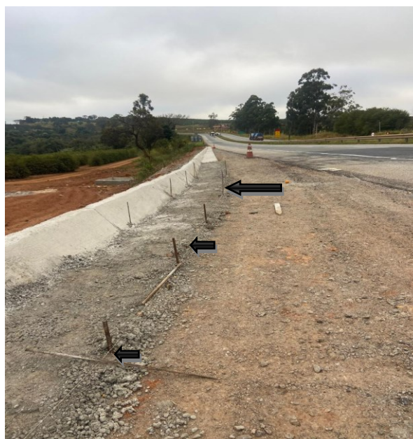
Figura 10 - Demarcação da sarjeta
