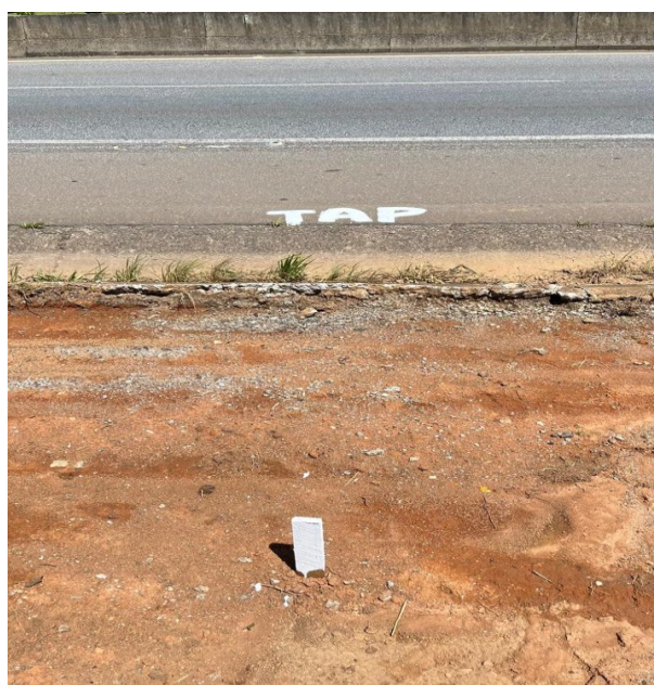
Figura 79 - Estaqueamento de orientação de campo
