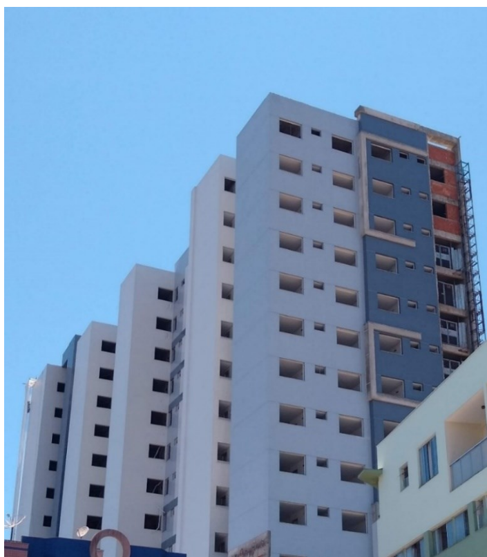
Figura 91 - Fachada lateral direita
