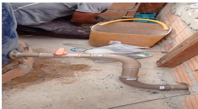
Figura 59 - Local de instalação da caixa d'água
