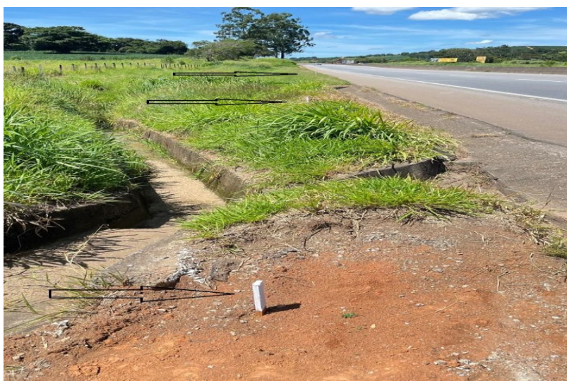
Figura 78 - Estaqueamento de orientação de campo
