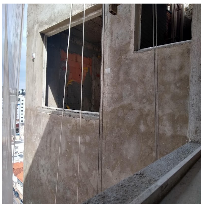
Figura 97 - Emboço finalizado
