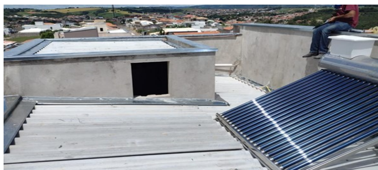
Figura 57 - Local de instalação da caixa d'água
