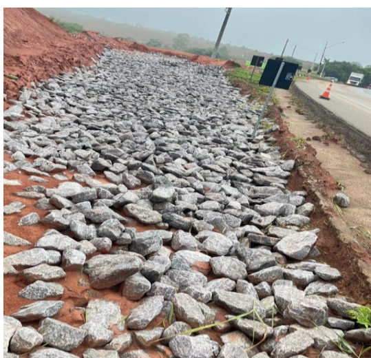
Figura 11 - Reforço do sub leito
