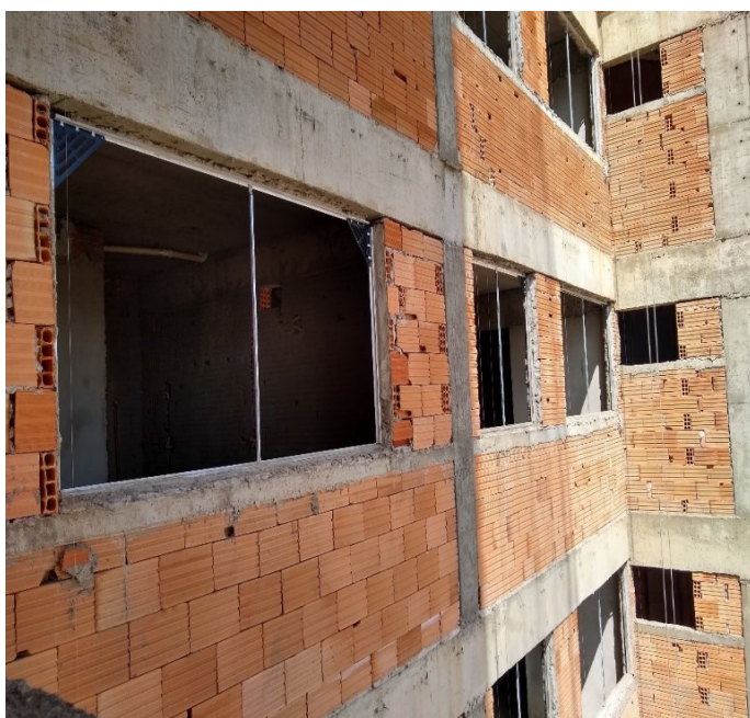
Figura 92 - Base de alvenaria e estrutura
