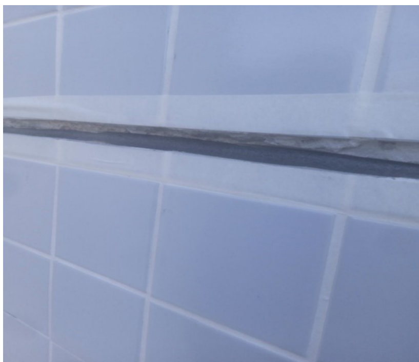
Figura 106 - Tarucel colocado na junta de dilatação
