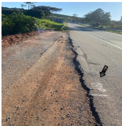
Figura 9 - Acompanhamento de obra
