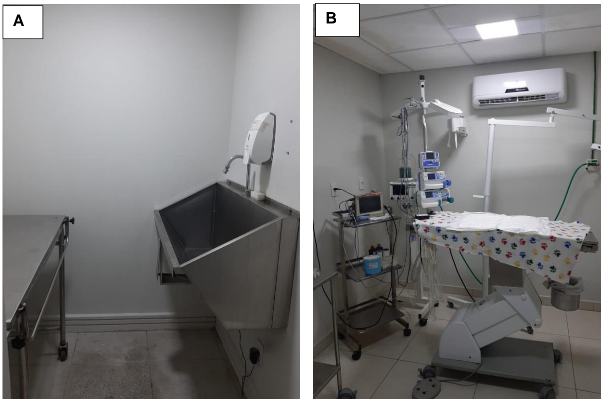
Figura 8: Vista parcial do centro cirúrgico da clínica veterinária. A: sala de paramentação cirúrgica. B: uma das três salas de procedimento cirúrgico. Vitória-ES.
