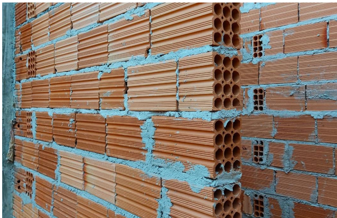
Figura 8: Alvenaria na forma de assentamento de cutelo
