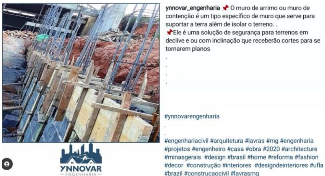
Figura 2: Postagem orgânica sobre muro de arrimo
