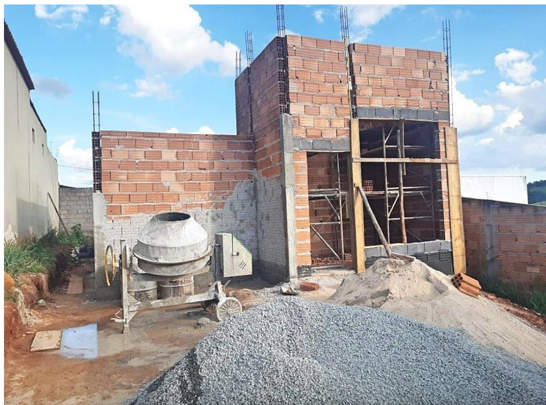
Figura 4: Andamento de uma obra no bairro Água Limpa
