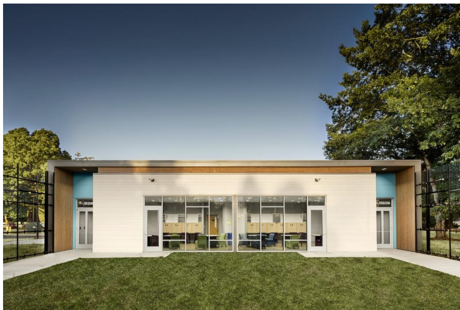
Imagem 14 – Fachada da Casa da Fazenda para Adolescentes
