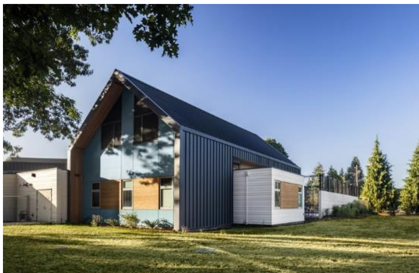
Imagem 13 – Fachada da Casa da Fazenda para Adolescentes
