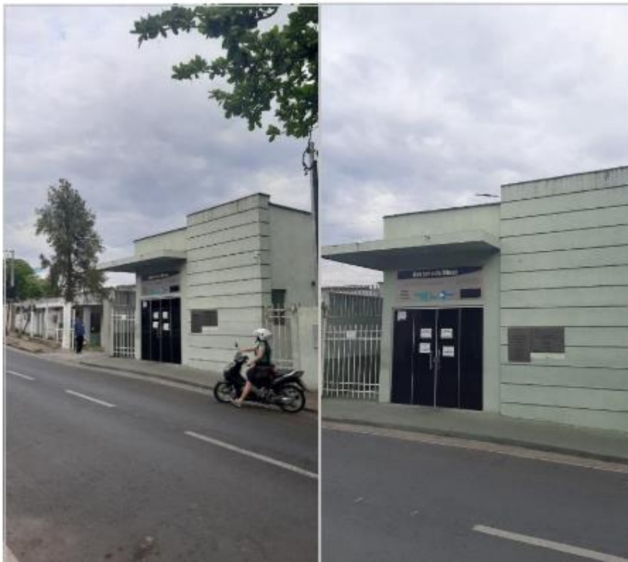
Figura 18 - Fachada da Farmácia de Minas do município de Campo Belo-MG
