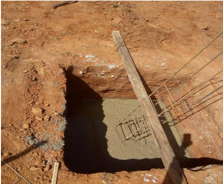
Figura 57 - Concretagem das sapatas do pavimento térreo
