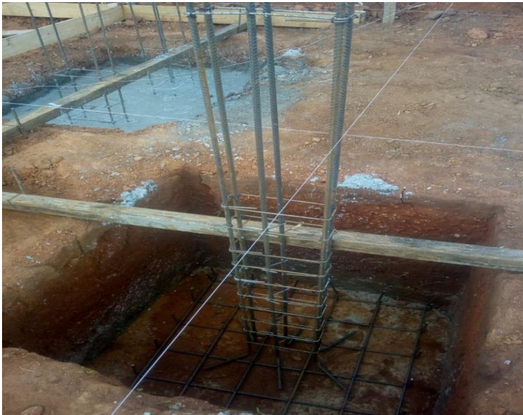
Figura 55 - Locação do eixo dos pilares
