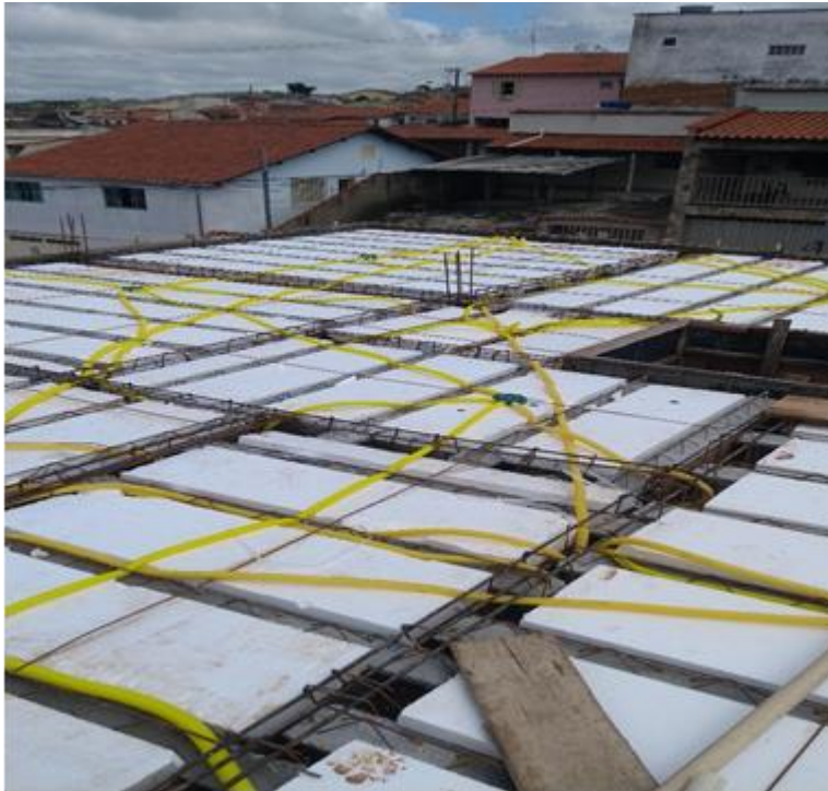
Figura 6- Passagem dos eletrodutos corrugados
