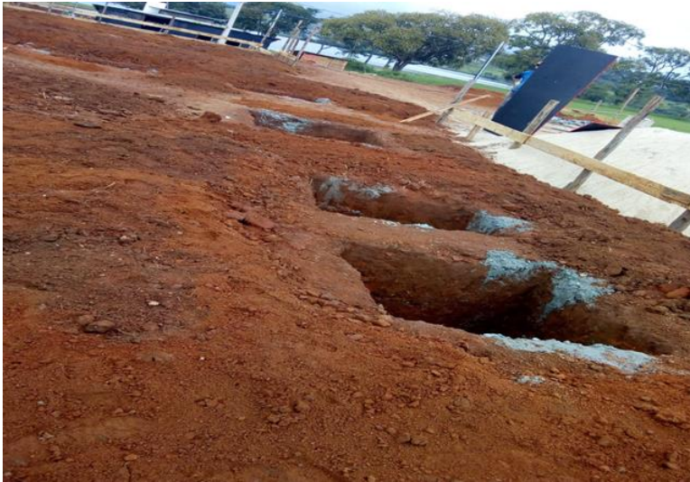
Figura 51 - Execução das sapatas do pavimento térreo
