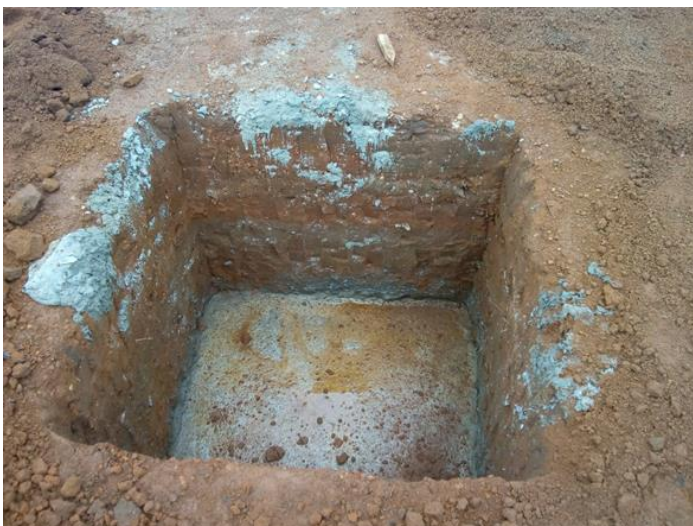
Figura 54 - Camada de concreto magro
