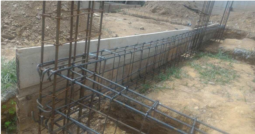
Figura 34- Armações das vigas baldrames
