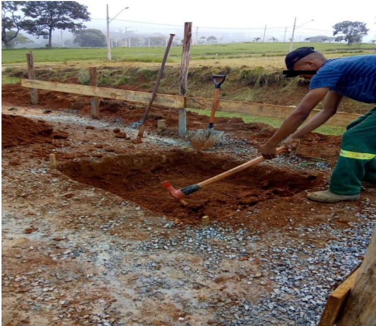
Figura 50 – Escavação das sapatas isoladas
