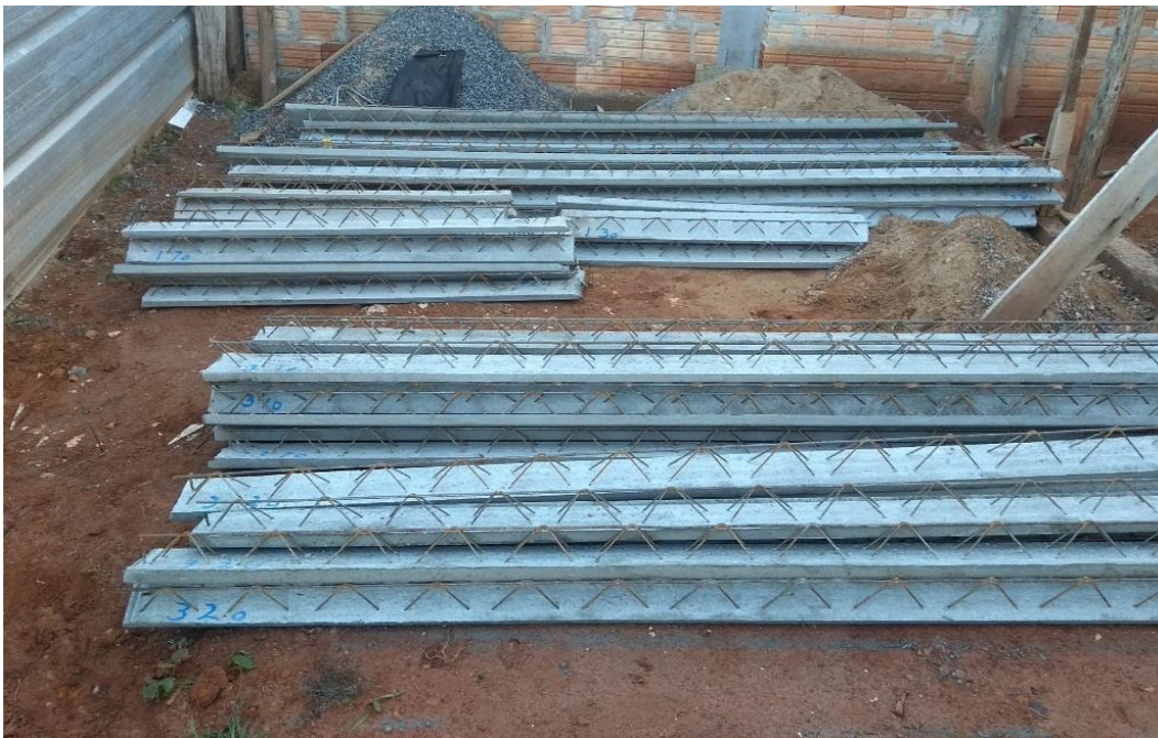
Figura 3- Vigota treliçada utilizadas na montagem da laje
