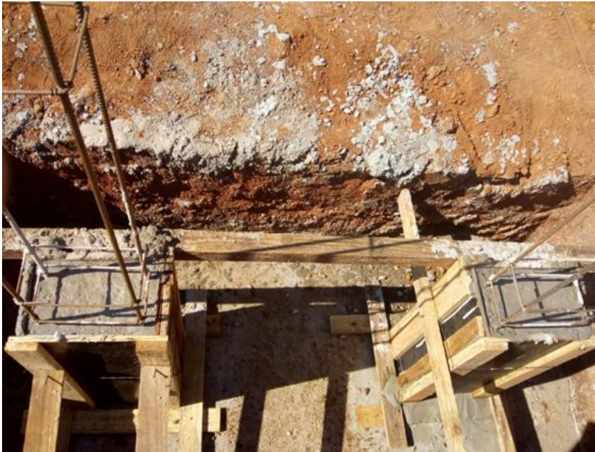
Figura 60 - Concretagem dos arranques dos pilares
