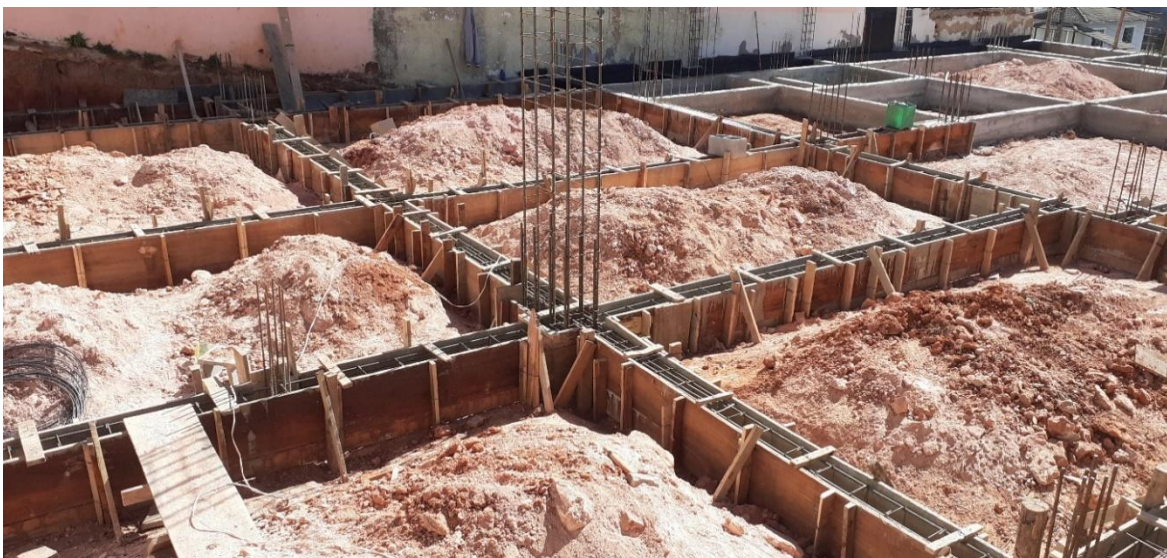
Figura 66: Colocação das formas nas vigas baldrame
