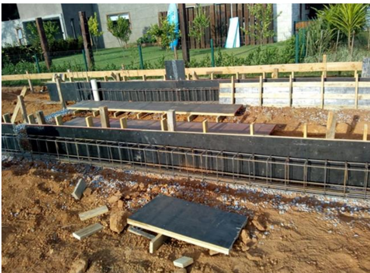
Figura 58 – Confecção das formas das vigas baldrame
