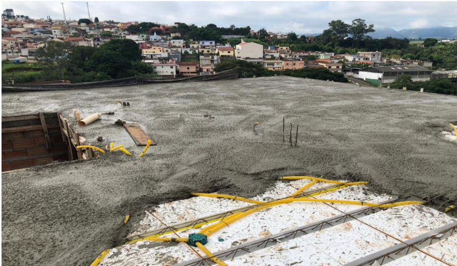
Figura 7- Laje sendo concretada
