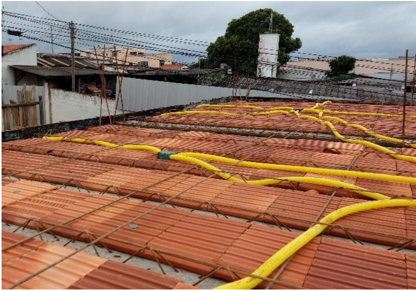
Figura 42 – Passagem dos eletrodutos
