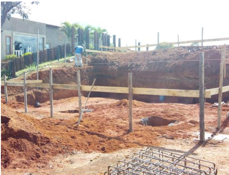
Figura 52 - Execução das sapatas do escritório
