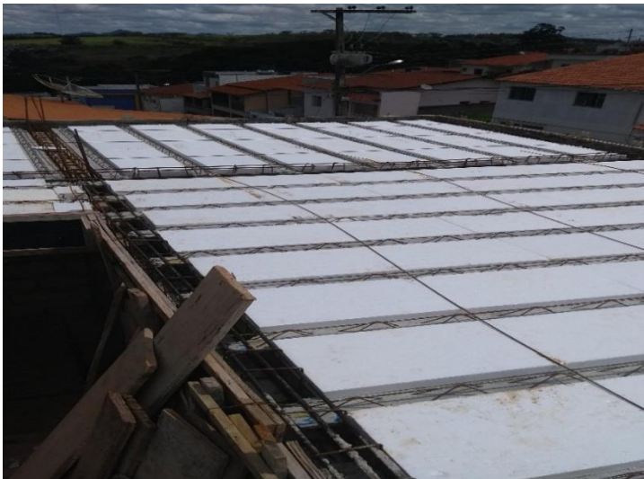
Figura 5- Vigotas e poliestireno expandido (EPS)
