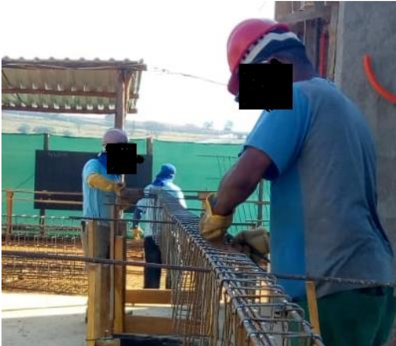
Figura 56 - Execução das armações
