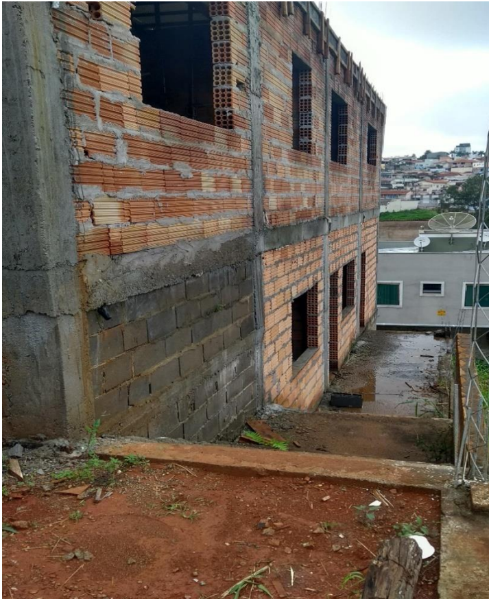
Figura 2- Obra residencial sendo executada
