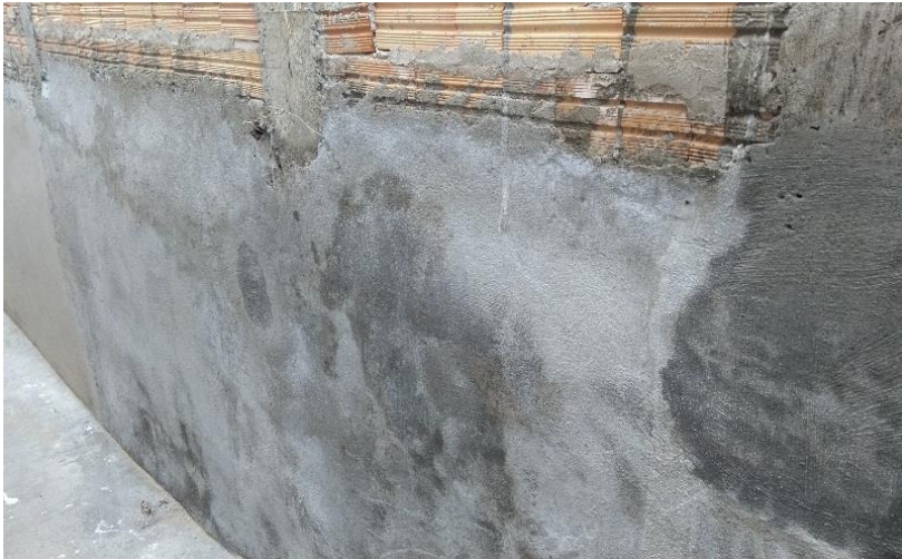
Figura 19- Parede regularizada
