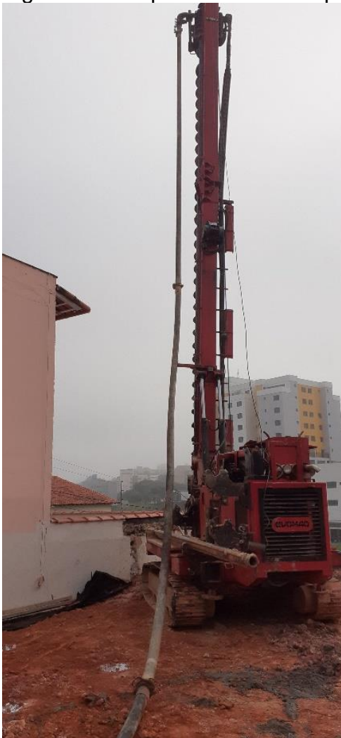
Figura 62- Máquina utilizada na perfuração
