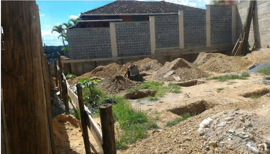
Figura 31- Gabarito e nivelamento do terreno
