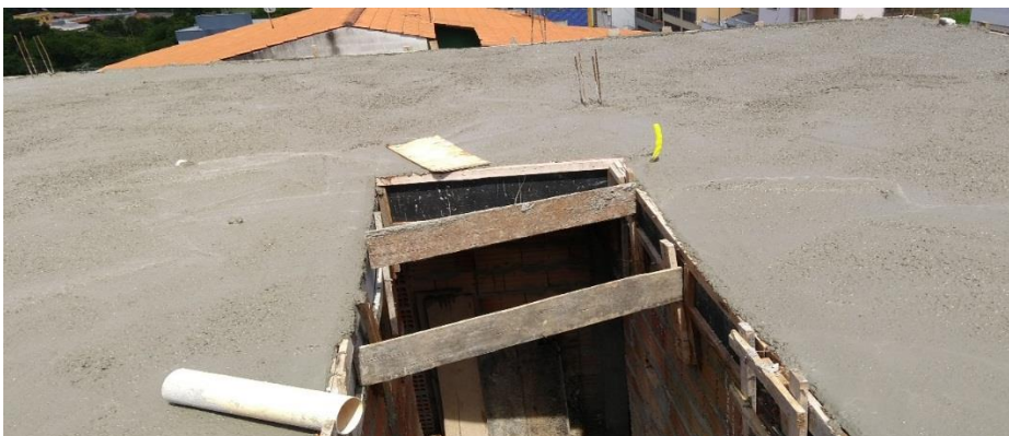
Figura 8 – Realização da cura do concreto
