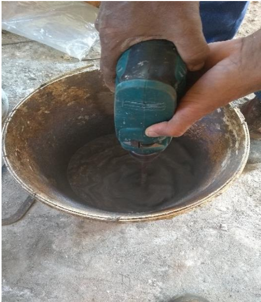
Figura 21- Preparação do tecplus top
