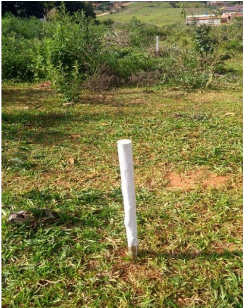
Figura 15- Colocação das estacas
