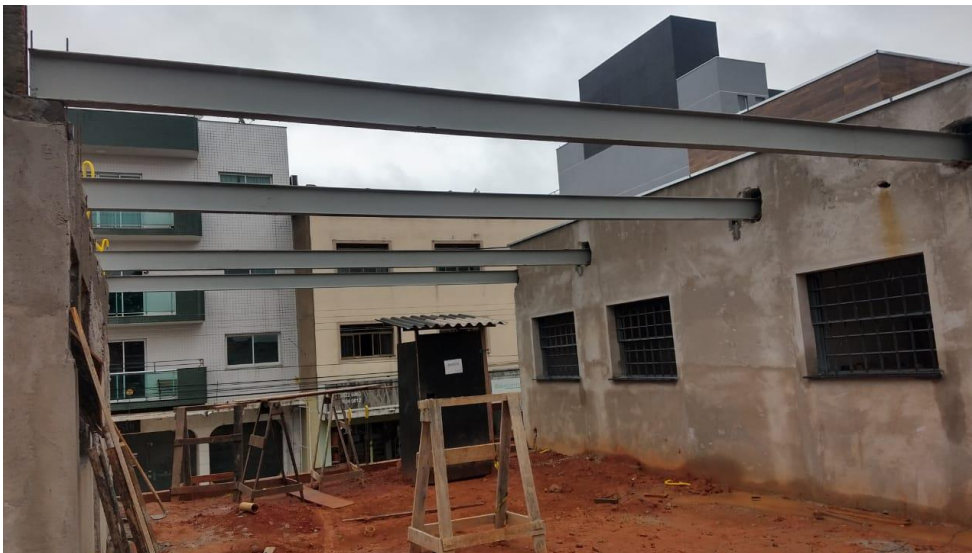
Figura 38 – Vigas metálicas
