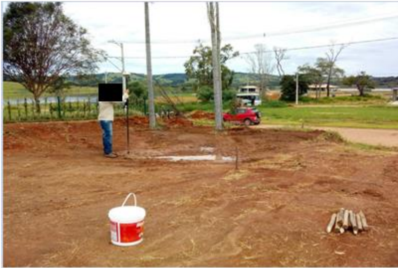
Figura 47 – Execução da locação topográfica
