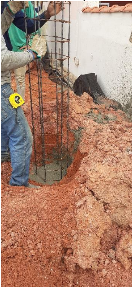
Figura 64 – Colocação das armações
