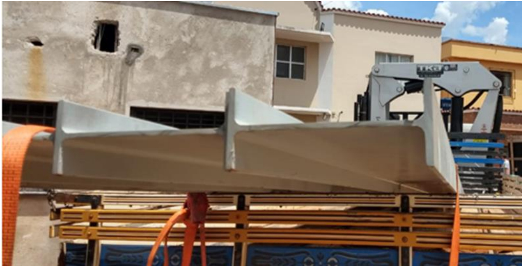
Figura 39 – Perfil das vigas metálicas
