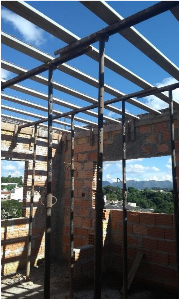
Figura 4 - Escoramentos, vigotas, vigas e formas
