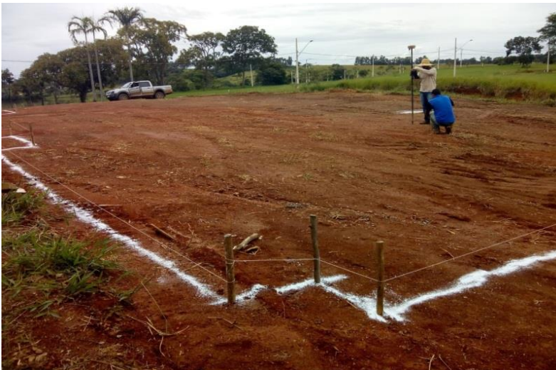
Figura 48: Resultado da locação topográfica
