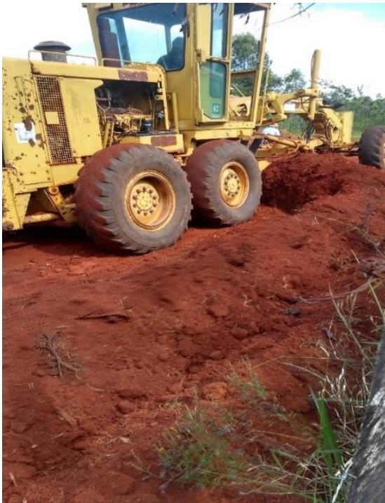
Figura 17- Movimentação do solo com motoniveladora
