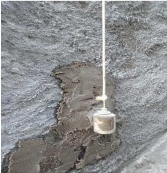
Figura 25- Execução do prumo e talisca
