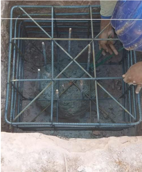
Figura 65: Bloco de coroamento
