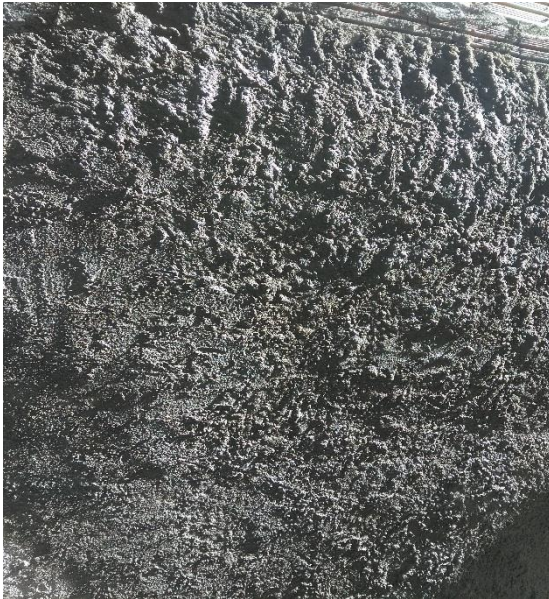
Figura 24- Chapisco na superfície
