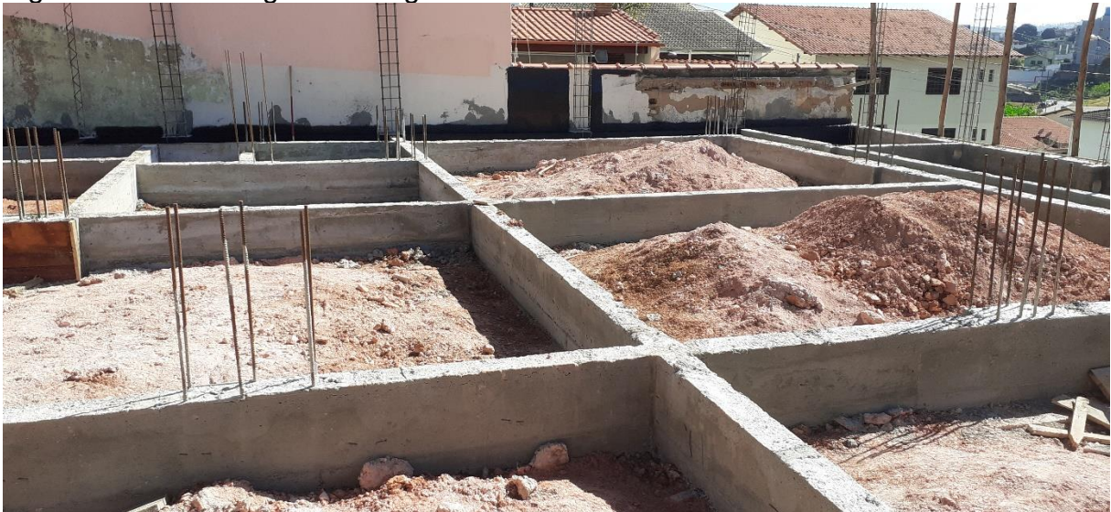
Figura 67: Concretagem das vigas baldrame e dos blocos
