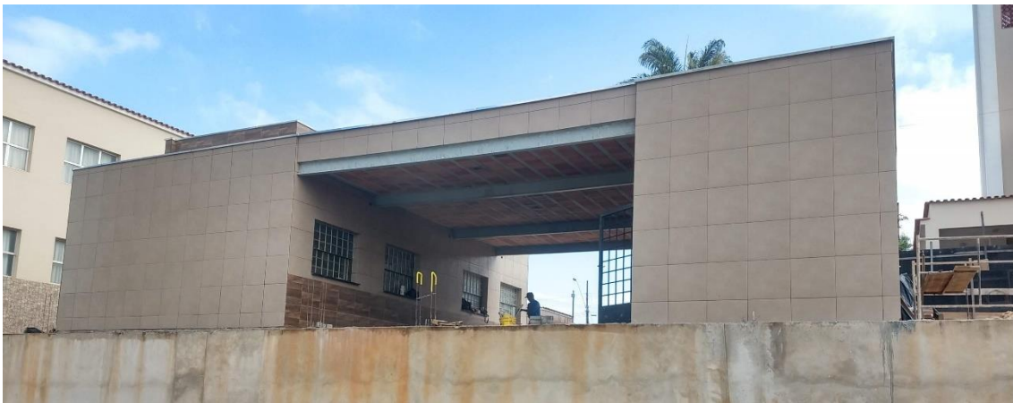
Figura 44 – Laje pronta para acabamento
