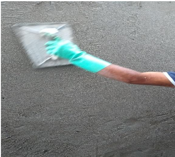
Figura 28- Acabamento do reboco
