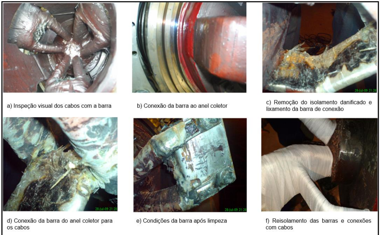
Figura 9 - Retirada da isolamento contaminada pelo pó de escovas
