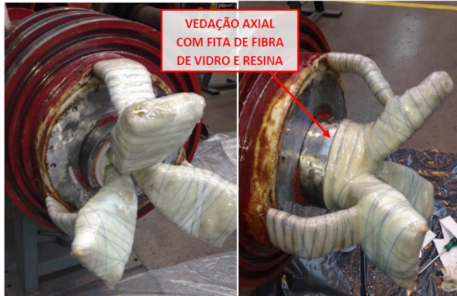
Figura 15 - Aplicação do cadarço de fibra de vidro impregnada com resina
