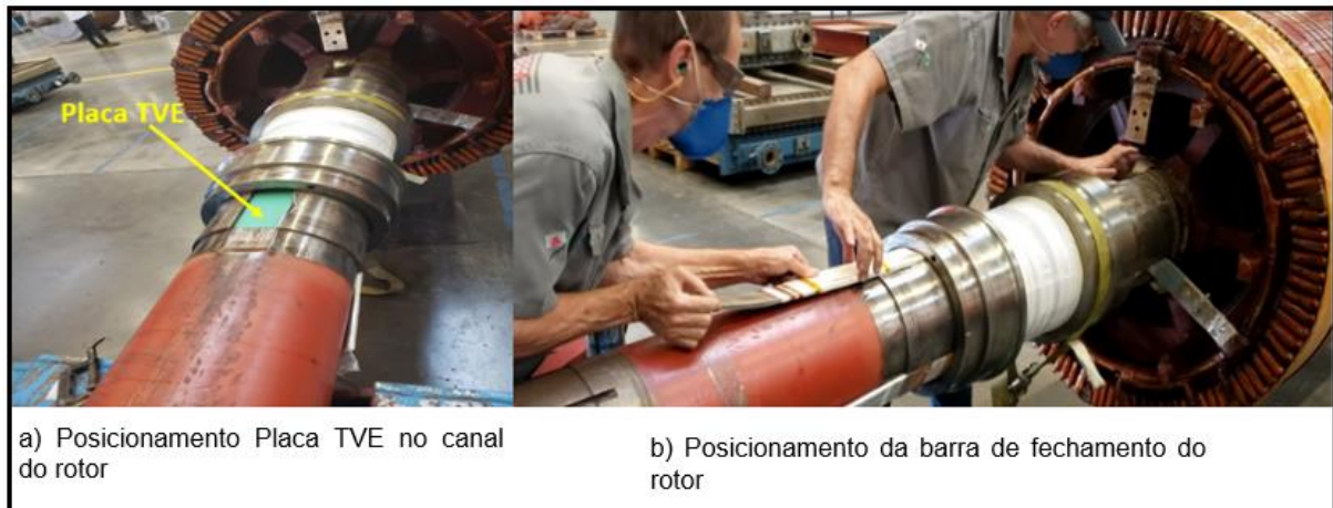
Figura 14 - Aplicação de barra isolante de TVE
