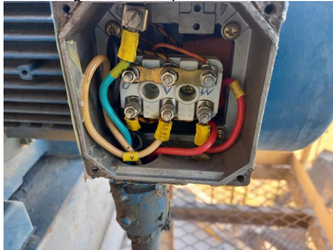
Figura 24 - Reaperto conexões
