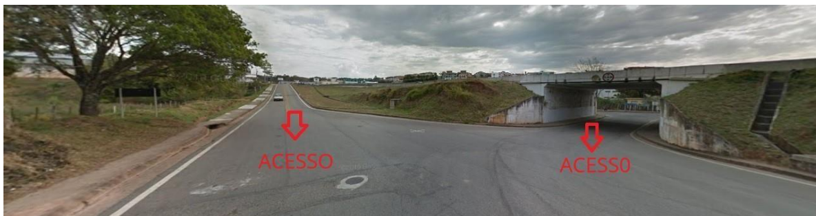
Imagem 26 – Acesso ao terreno de implantação Perdões-MG
