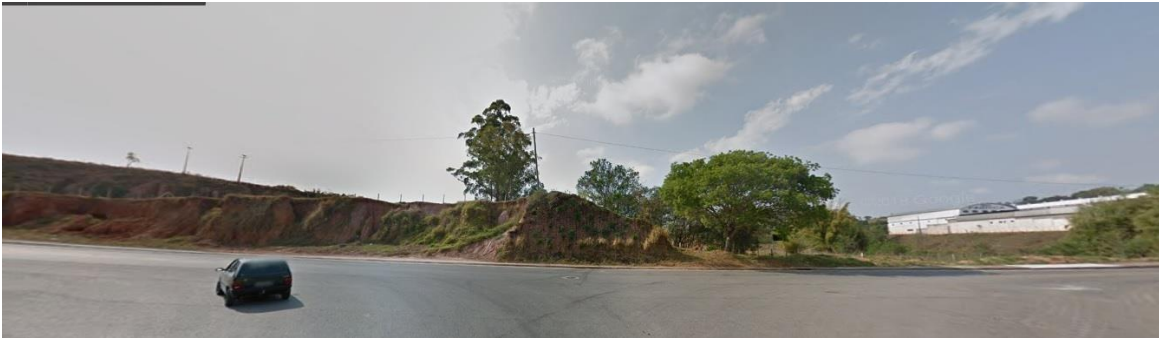
Imagem 28 – Visada do túnel olhando para o lote
