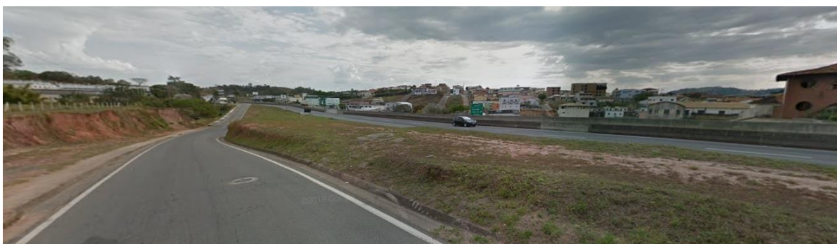
Imagem 27 – Visada pegando parte do lote e o outro lado da BR- 381
