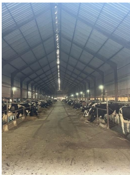
Figura 2: Free-stall em sistema de Cross ventilation
