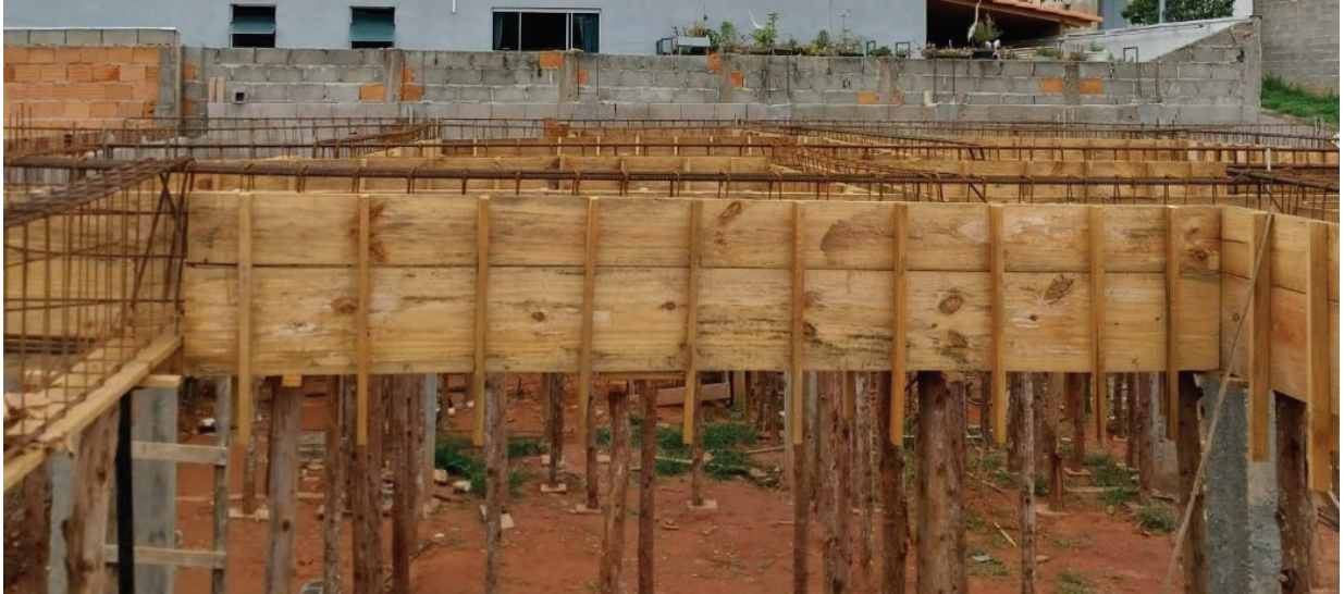
Figura 101 - Fechamento com painel lateral
