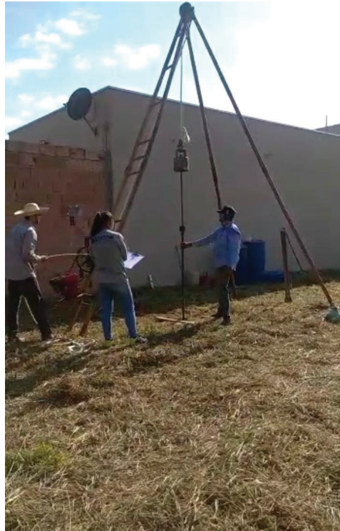
Figura 77 - Execução da sondagem
