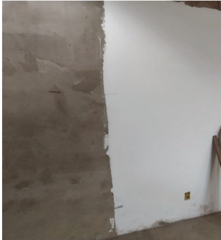
Figura 23 - Gesso aplicado na alvenaria argamassada
