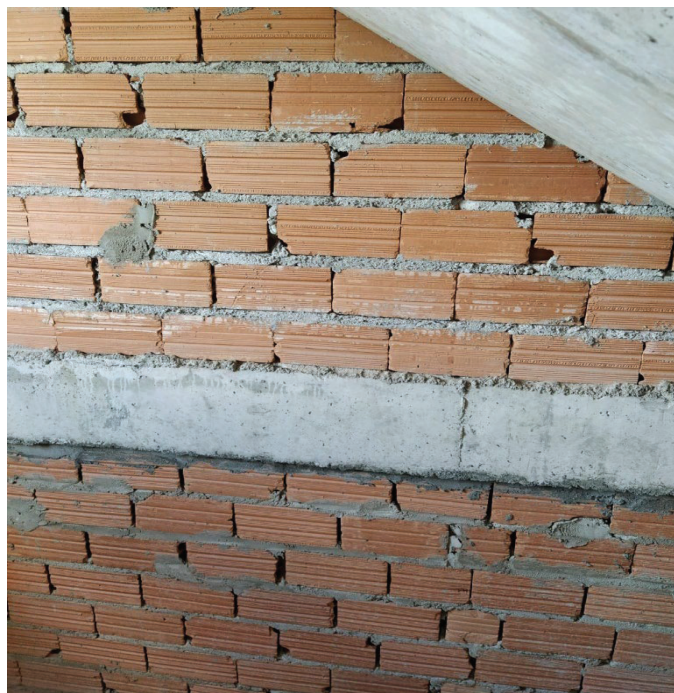
Figura 19 - Alvenaria de vedação
