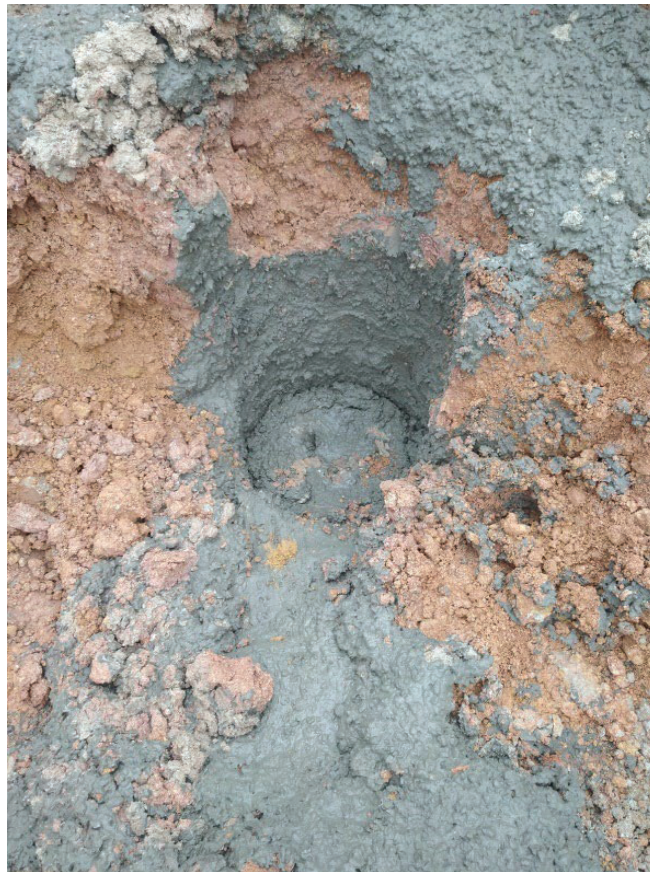
Figura 83 - Estaca moldada
