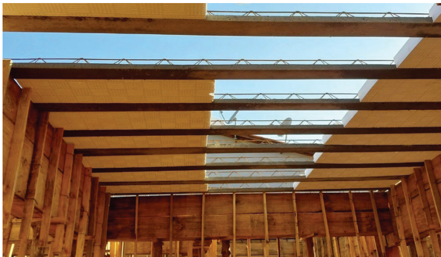
Figura 103 - Posicionamento de vigotas
