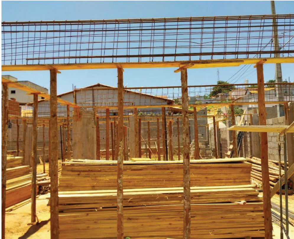
Figura 100 - Posicionamento da armadura
