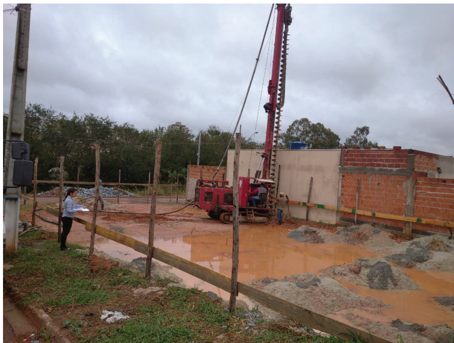
Figura 81 - Perfuratriz da hélice contínua
