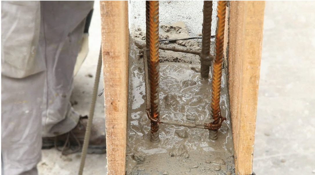
Figura 95 - Concretagem de pilar
