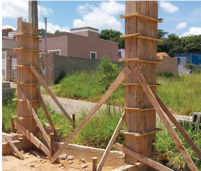
Figura 94 - Escoramento de formas
