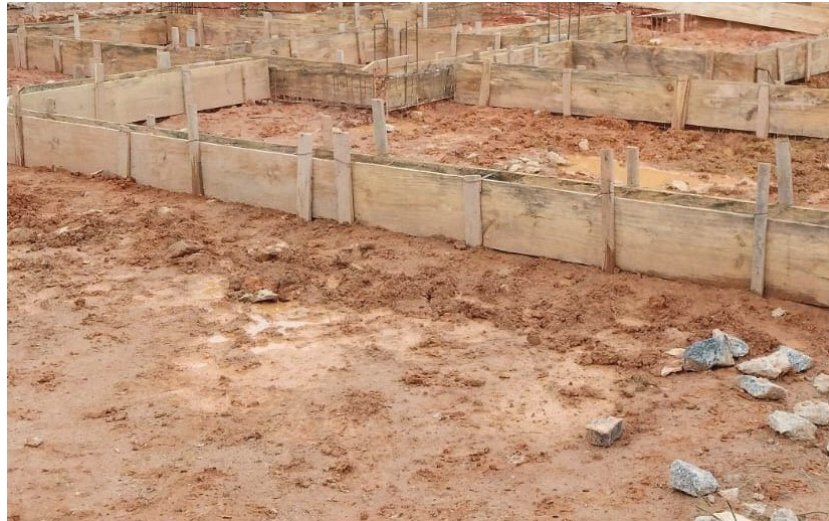
Figura 90 - Execução de formas da viga baldrame
