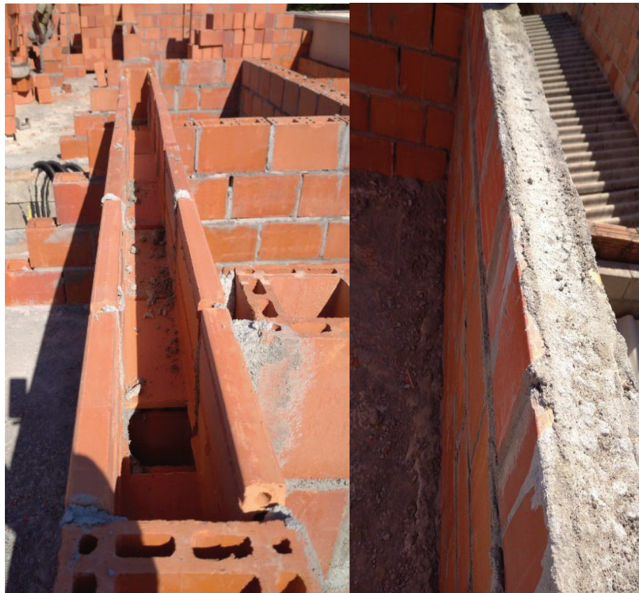
Figura 115 - Grauteamento da contraverga
