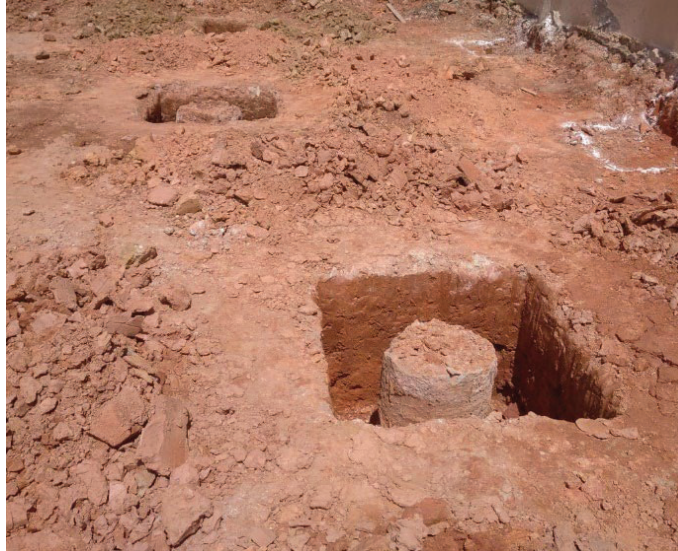
Figura 84 - Escavação das caixas do bloco
