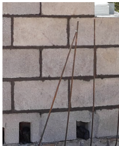
Figura 111 - Janela de visita
