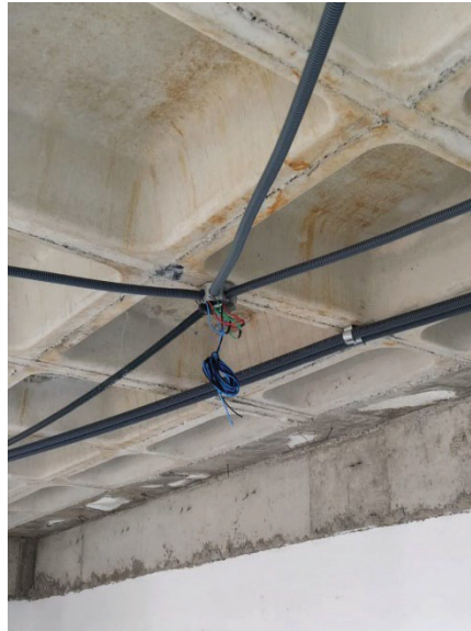
Figura 6 - Fixação caixas e eletrodutos
