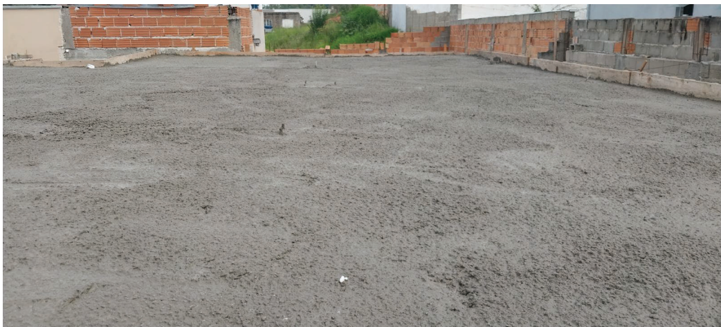
Figura 105 - Pós lançamento do concreto
