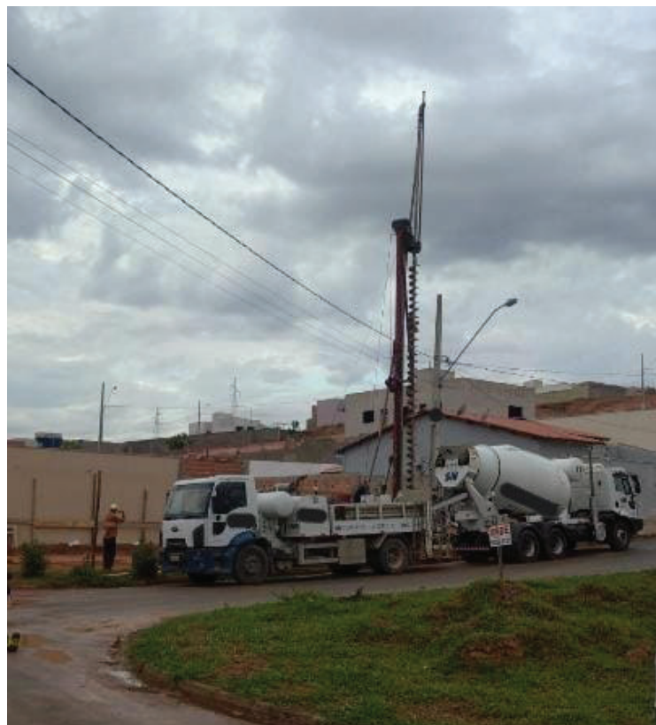
Figura 79 - Concretagem das estacas
