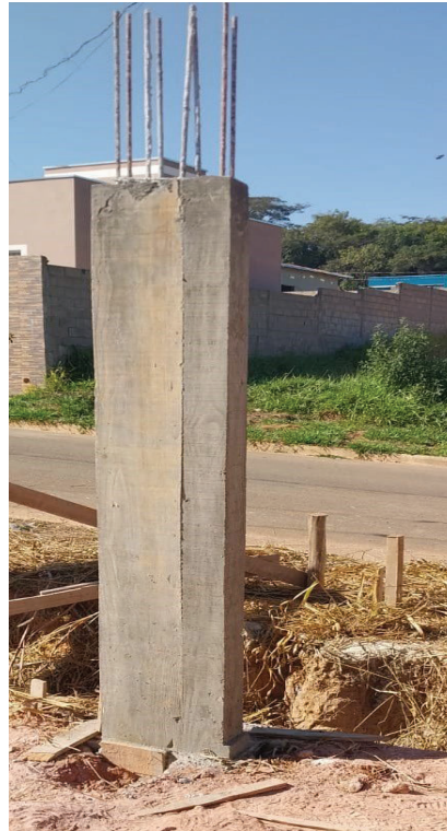
Figura 97 - Desforma de pilar
