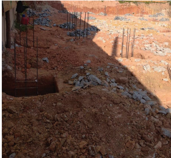
Figura 88 - Alinhamento da armadura
