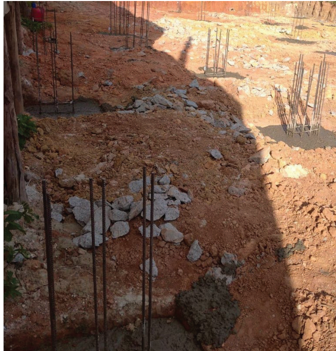
Figura 89 - Concretagem dos blocos
