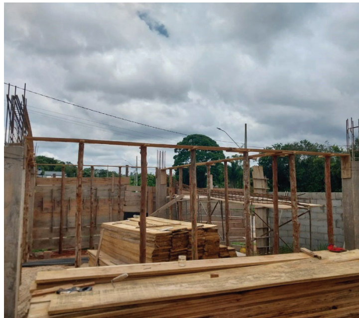
Figura 99 - Pré-escoramento parte inferior da viga
