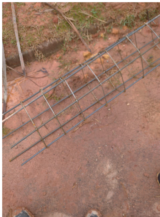
Figura 80 - Armadura das estacas
