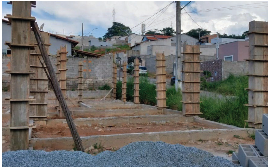
Figura 93 - Montagem de formas
