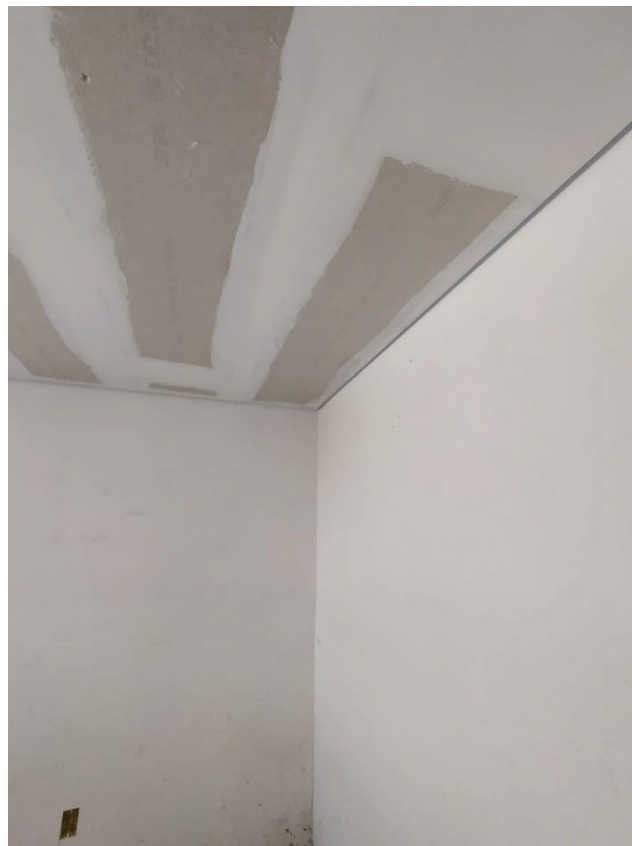
Figura 24 - Forro de gesso
