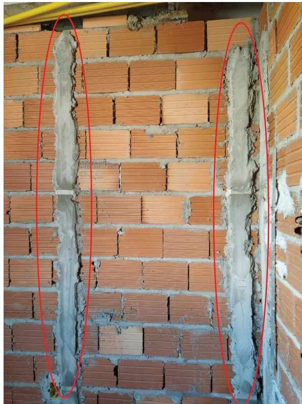
Figura 25 - Mestras na alvenaria
