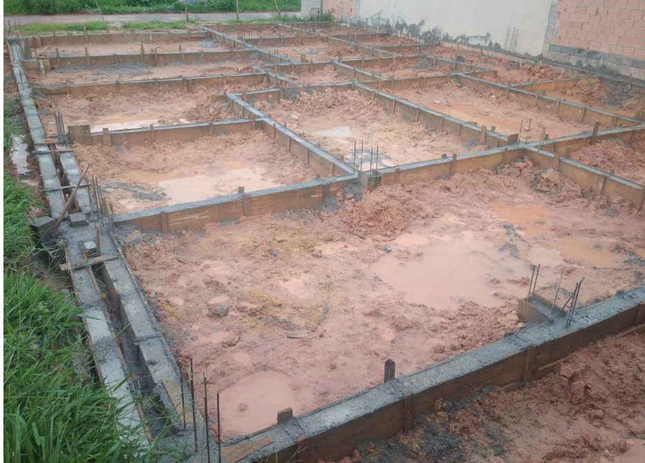
Figura 91 - Viga baldrame em processo de cura
