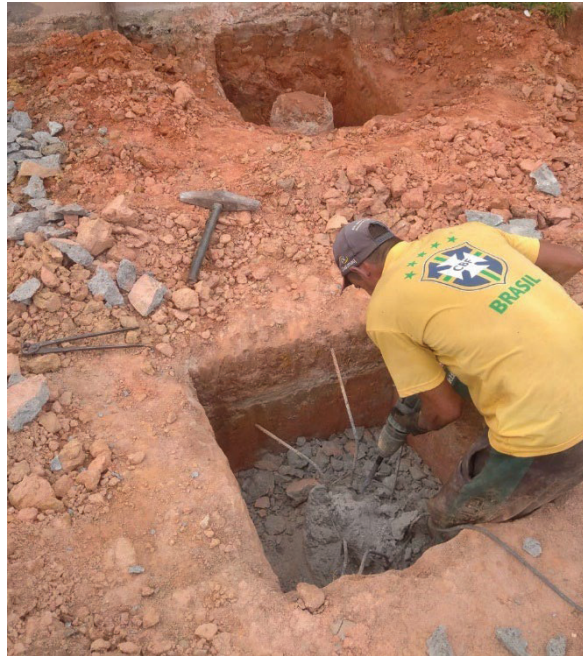
Figura 86 - Arrasamento de estaca
