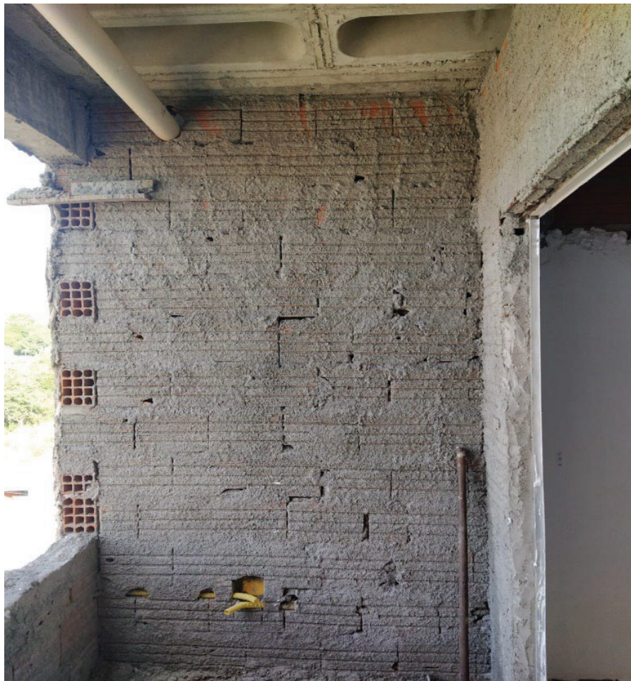
Figura 20 - Alvenaria chapiscada
