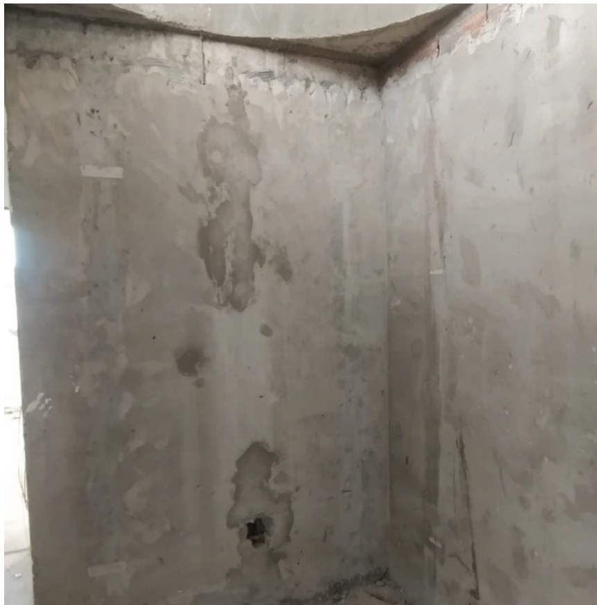
Figura 21 - Alvenaria emboçada
