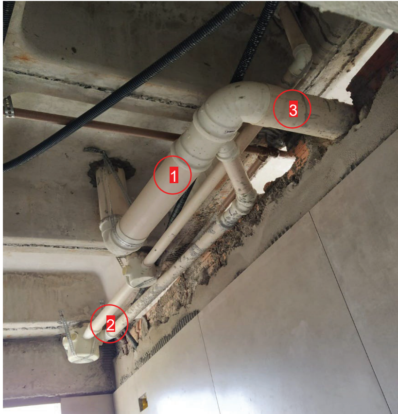
Figura 17 - Sistema de esgoto de banheiro
