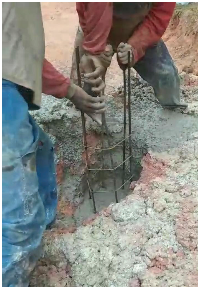
Figura 82 - Introdução da armadura na estaca
