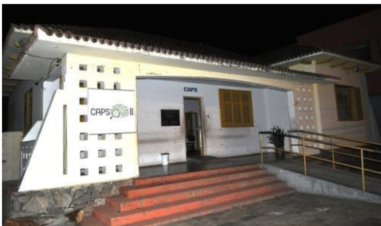
Imagem 21 – Entrada principal do CAPS II
