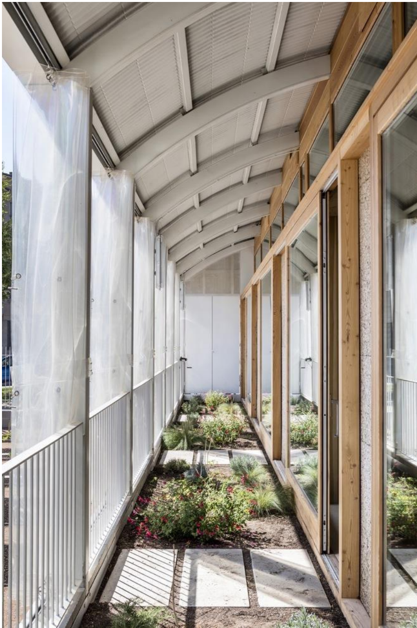
Imagem 14 – Varanda na fachada sudeste
