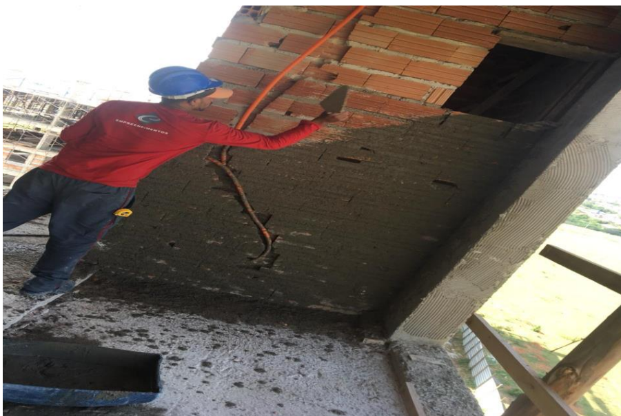
Figura 66: Aplicação do chapisco
