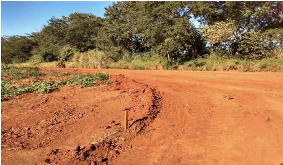
Figura 7 – Estacas de delimitação das ruas
