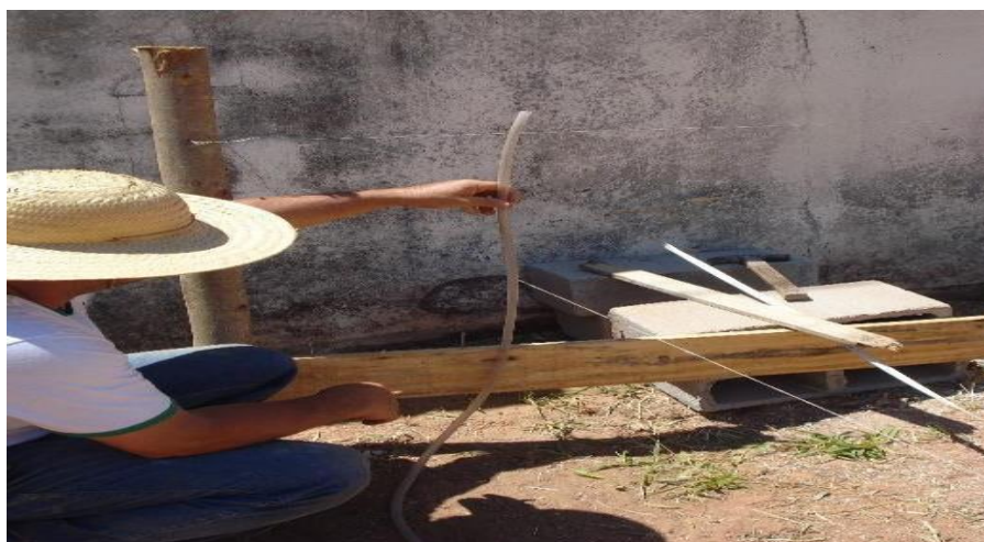
Figura 34 – Verificação de nível
