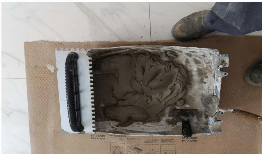
Figura 70: Argamassa mecânica ACI homogeneizada
