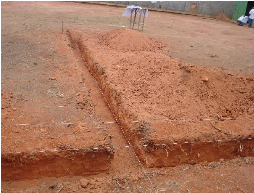
Figura 36 – Viga baldrame perfurada
