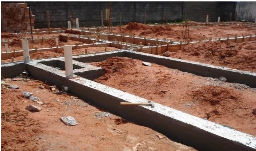
Figura 44 – Concretagem: concreto usinado – viga desenformada
