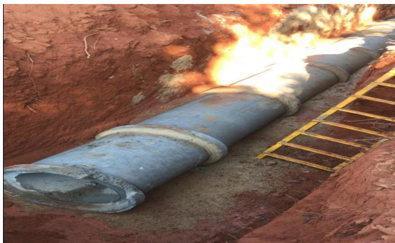
Figura 14 – Assentamento da tubulação (a)
