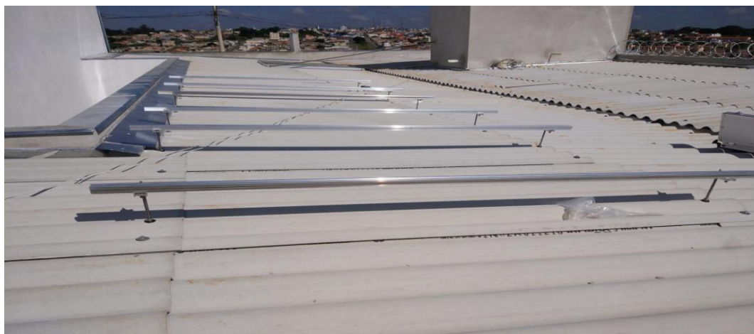
Figura 55: Fixação dos suportes e trilhos
