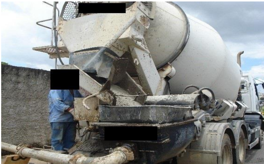
Figura 42 – Concretagem: concreto usinado
