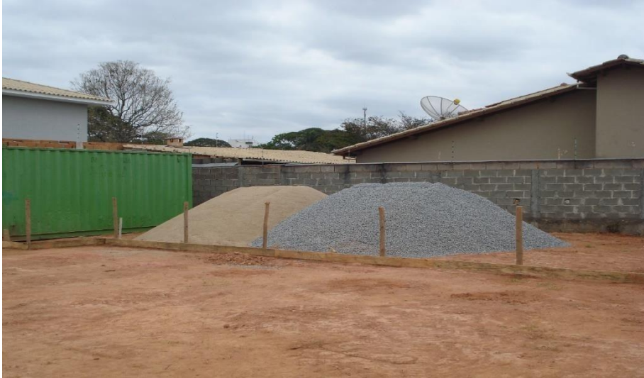
Figura 30 – Canteiro de obras
