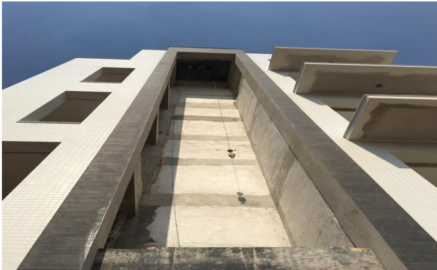
Figura 79: Fachada finalizada com os revestimentos
