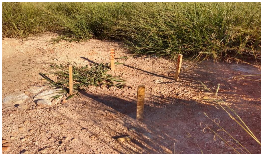
Figura 3 – Estacas de amarração
