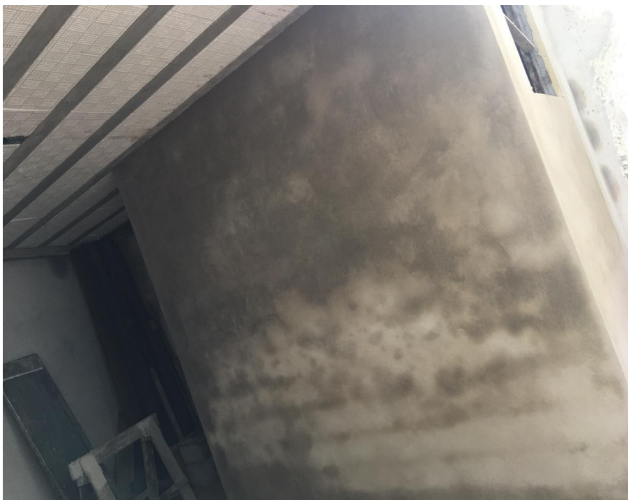
Figura 68: Revestimento Argamassado em processo de cura
