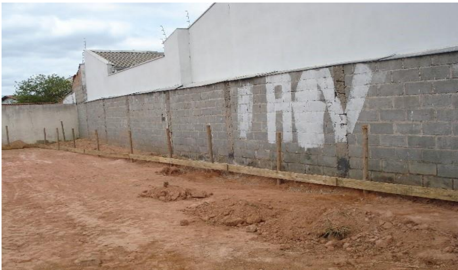
Figura 31 – Marcação e execução do gabarito
