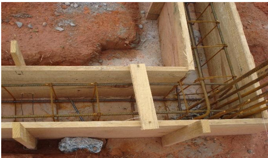
Figura 41 – Formas amarradas às vigas baldrame
