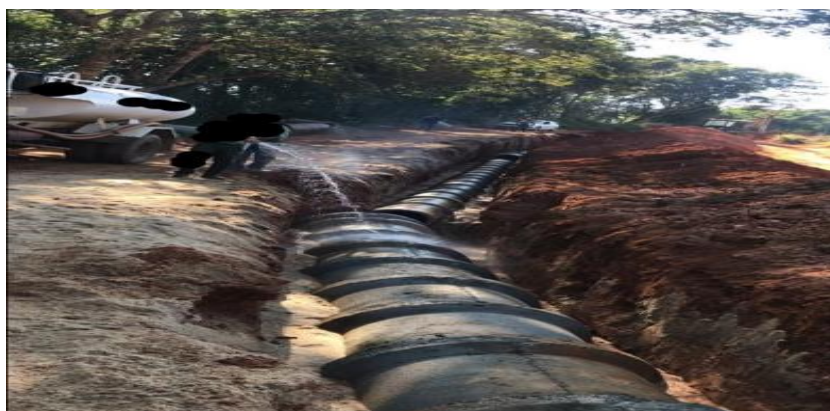
Figura 15 – Adensamento hidráulico
