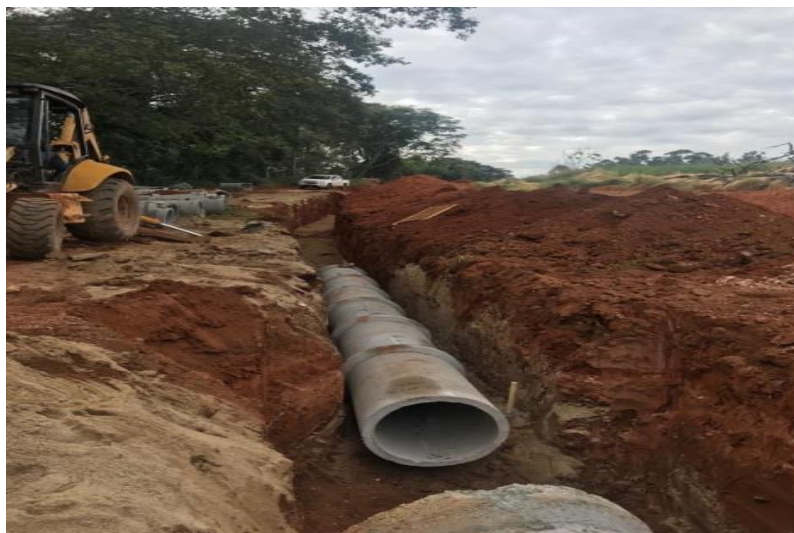
Figura 13 – Assentamento da tubulação
