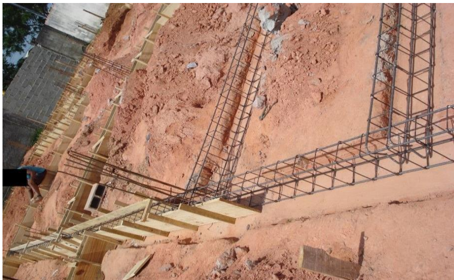
Figura 39 – Vigas baldrame no solo compactado
