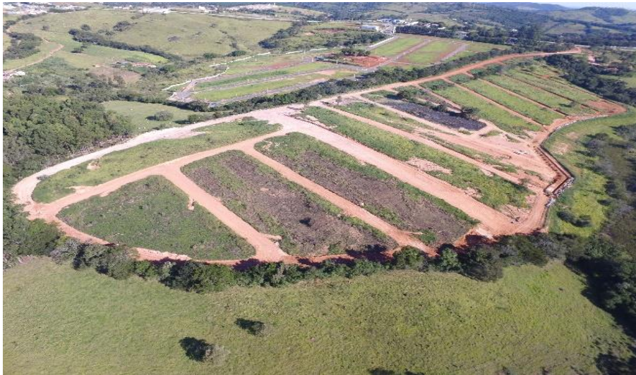
Figura 9 – Abertura de ruas concluída
