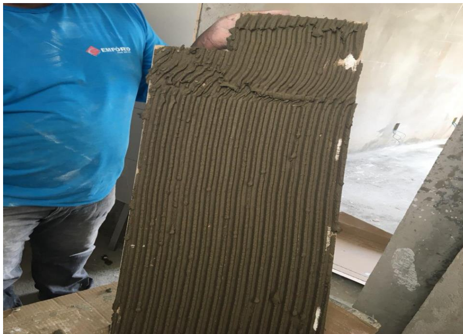
Figura 71: Aplicação da Argamassa ACI
