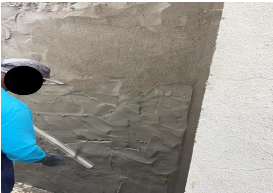
Figura 67: Aplicação da argamassa
