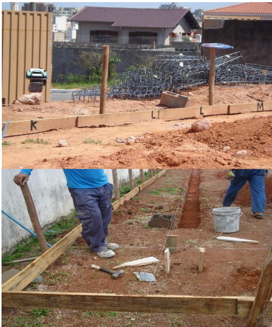
Figura 32 – Marcação dos eixos no gabarito.
