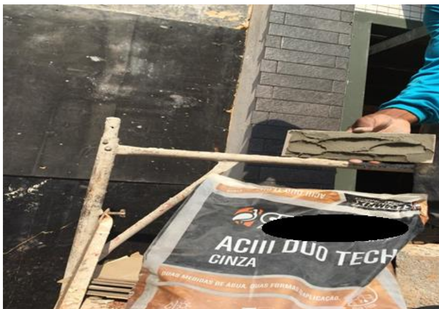
Figura 78: Instalação com argamassa ACIII duo tech
