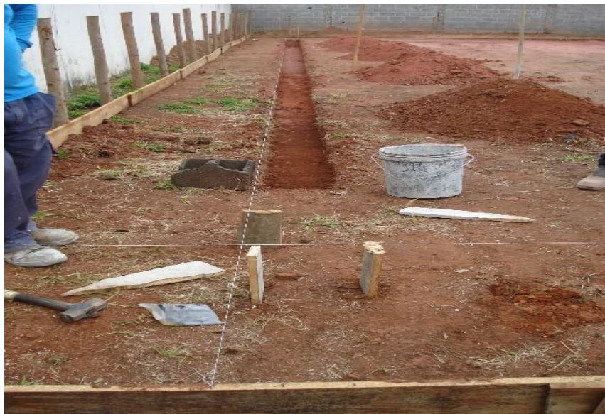
Figura 35 – Viga baldrame perfurada
