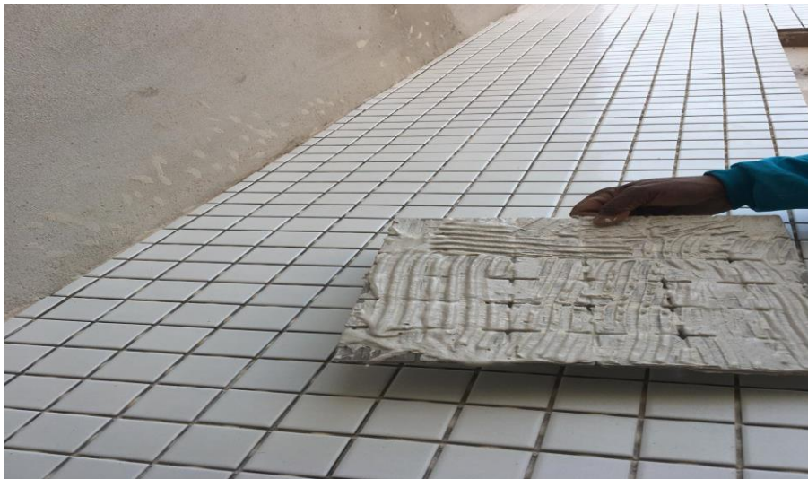
Figura 77: Instalação com argamassa Autofugante
