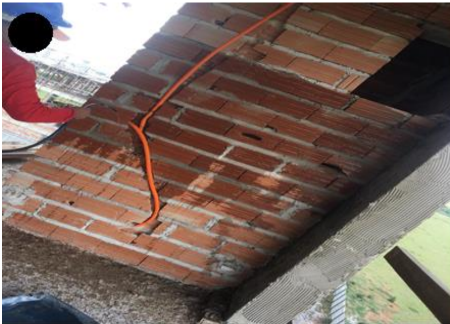
Figura 65: Preparo da superfície de alvenaria
