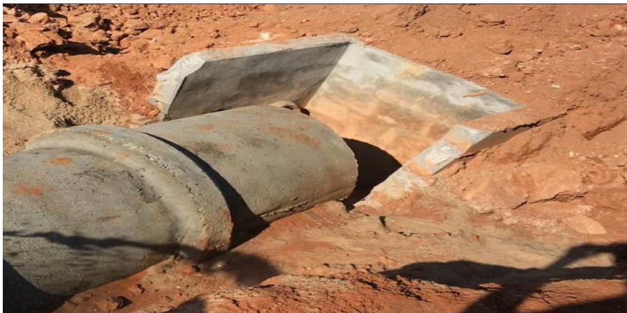
Figura 16 – Poço de visita
