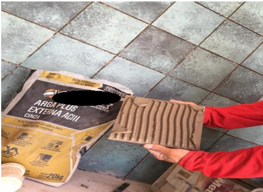
Figura 74: Instalação com Argamassa ACIII
