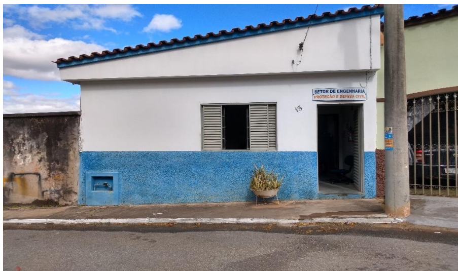
Figura 18 – Secretaria de obras
