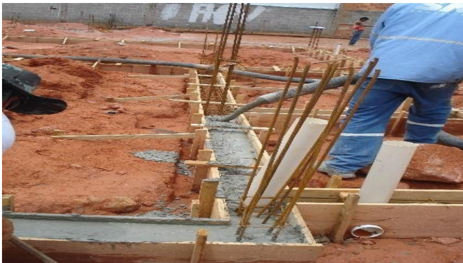
Figura 43 – Concretagem: concreto usinado – enchimento
