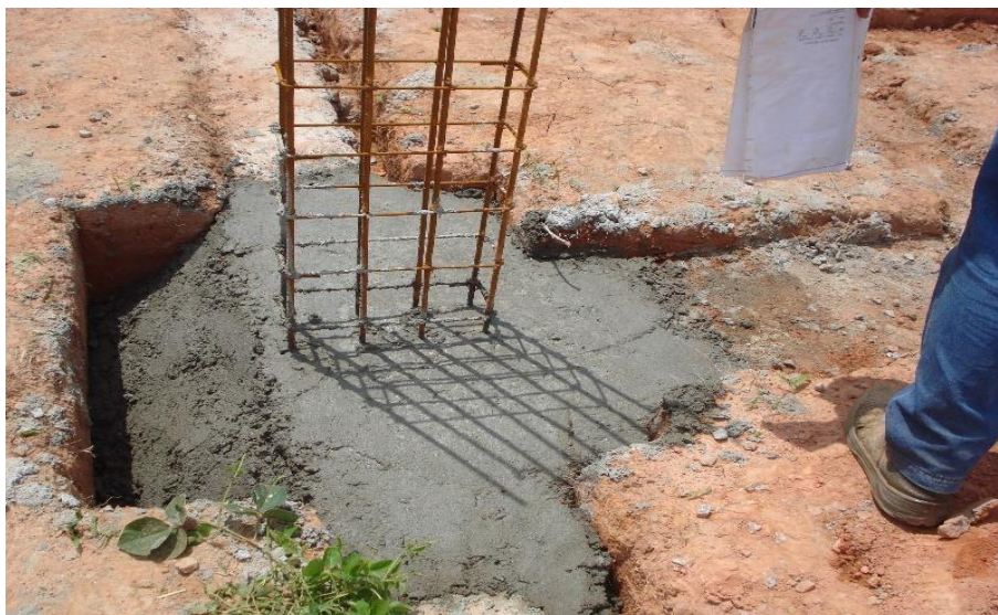
Figura 40: Sapata isolada
