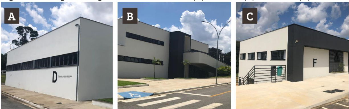
Figura 8 – Imagens fotográficas da fachada do (A) bloco D, (B) bloco E e (C) bloco F.
