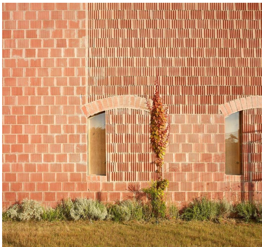
Figura 30: Uso de tijolos e argila na estrutura, sem revestimentos.
