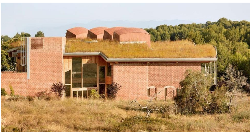
Imagem 31: Telhado verde da Imagine Escola Montessori
