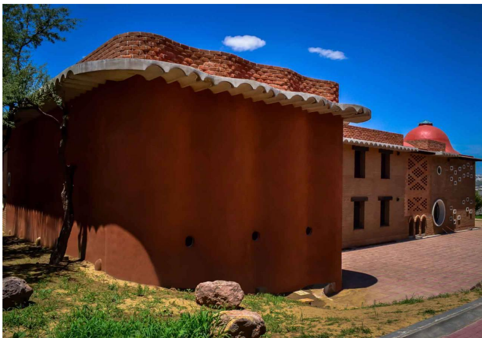
Figura 22 - Paredes de adobe, construídas no projeto.
