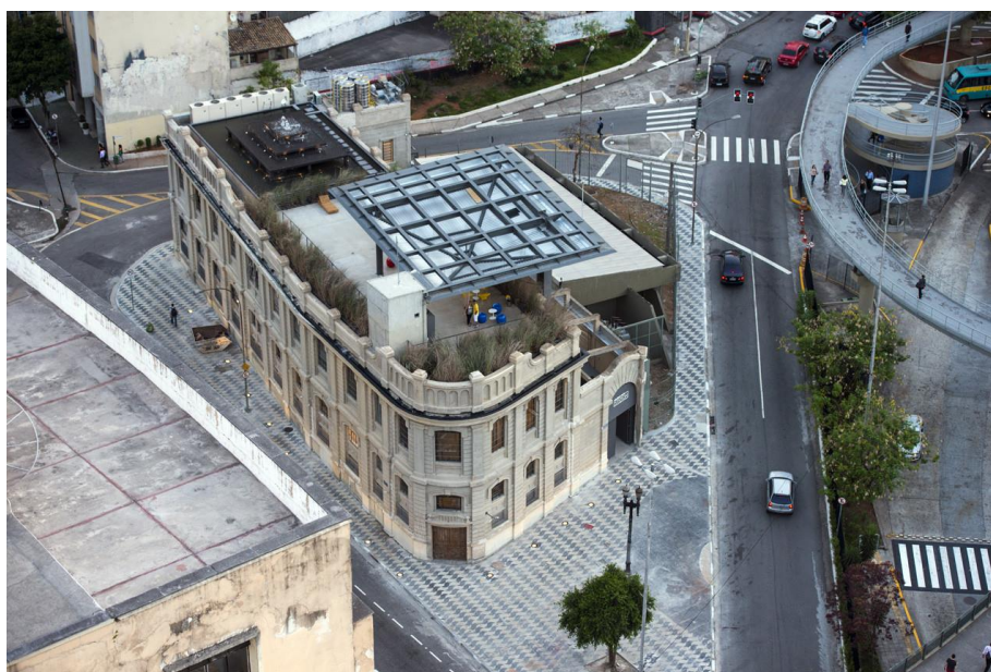
Figura 41 - Vista aérea da cobertura com recolhimento de águas pluviais.
