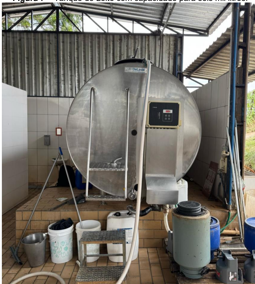
Figura 7 – Tanque de Leite com capacidade para seis mil litros.
