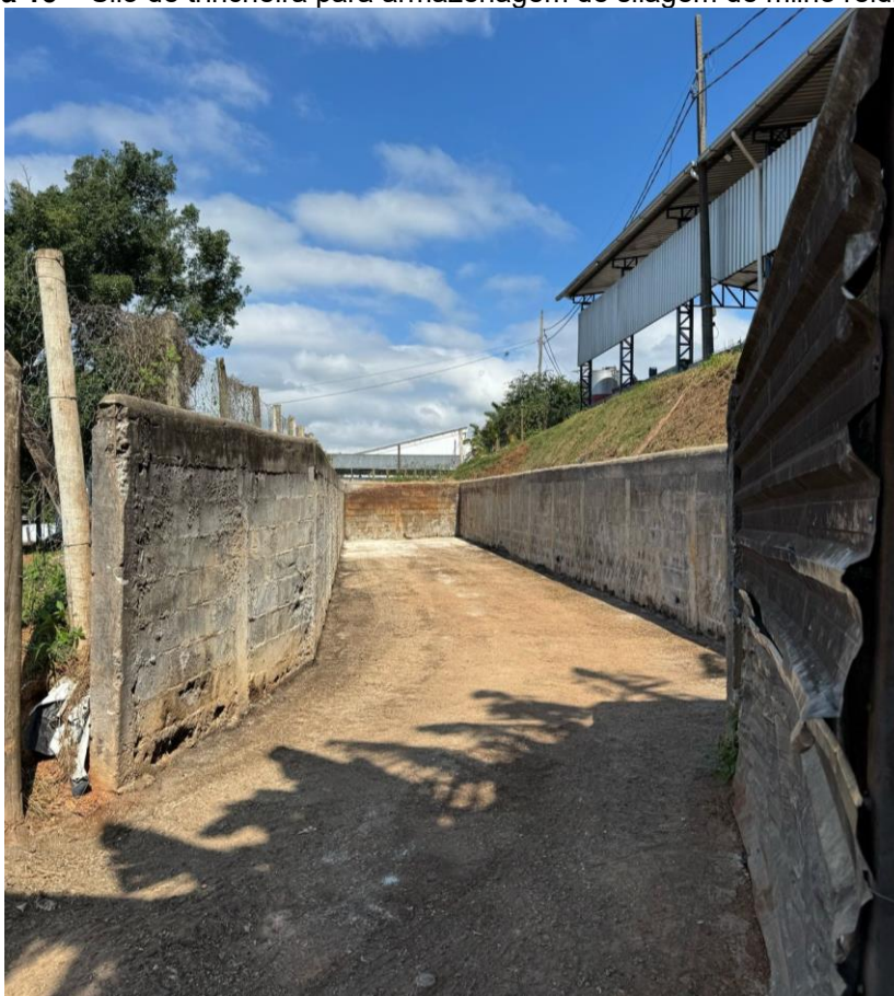
Figura 15 – Silo de trincheira para armazenagem de silagem de milho reidratado.
