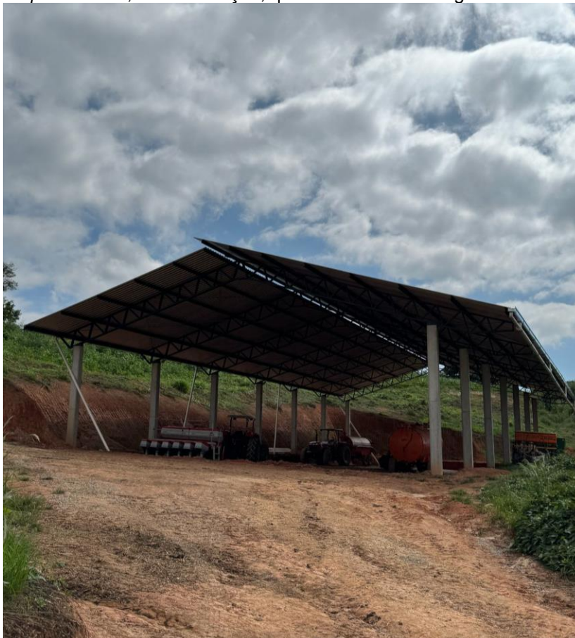
Figura 3 – Compost Barn 3 , em construção, quando finalizado abrigará toda recria da fazenda.
