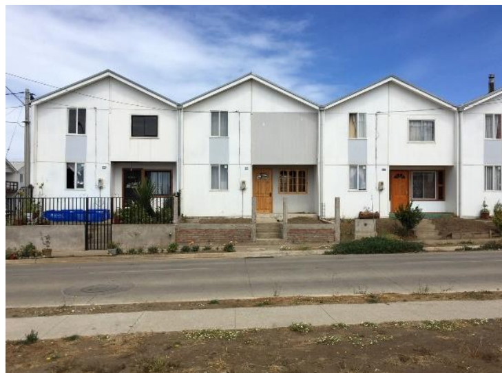
Imagem 8: Construção das duas partes da habitação
