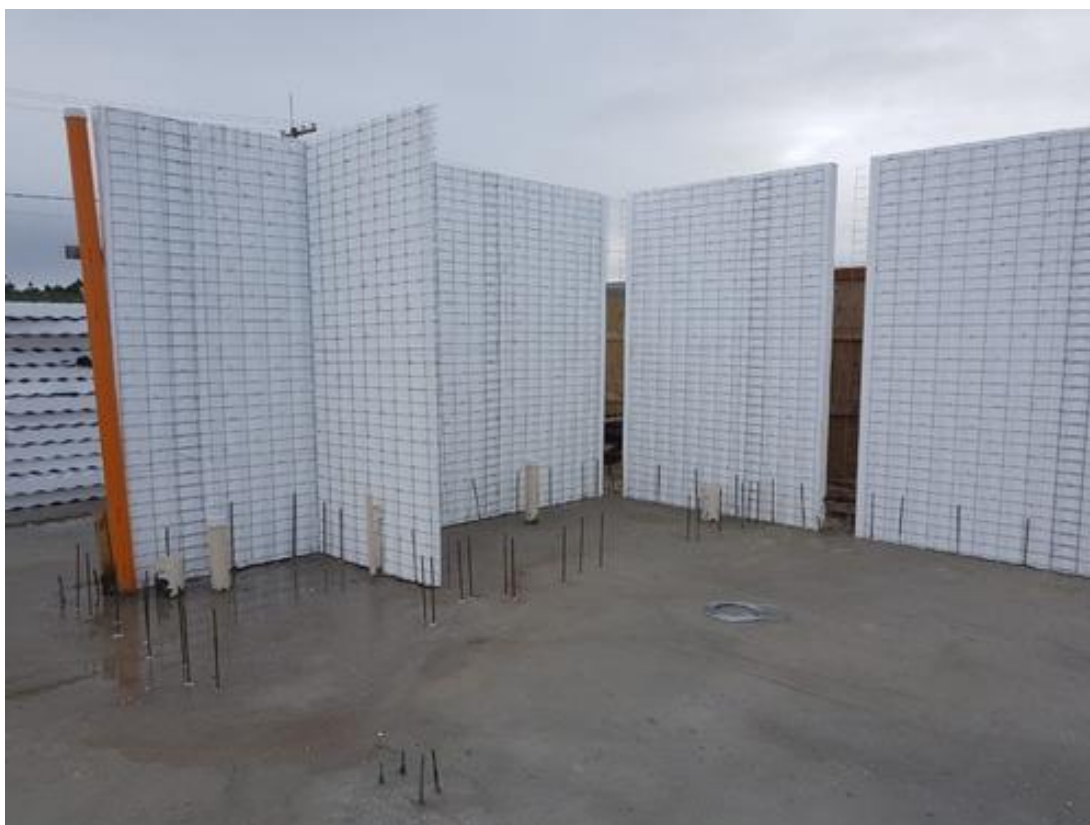
Imagem 2: Fixação após concretagem
