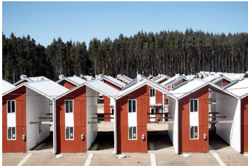
Imagem 7: Construção da primeira parte da habitação
