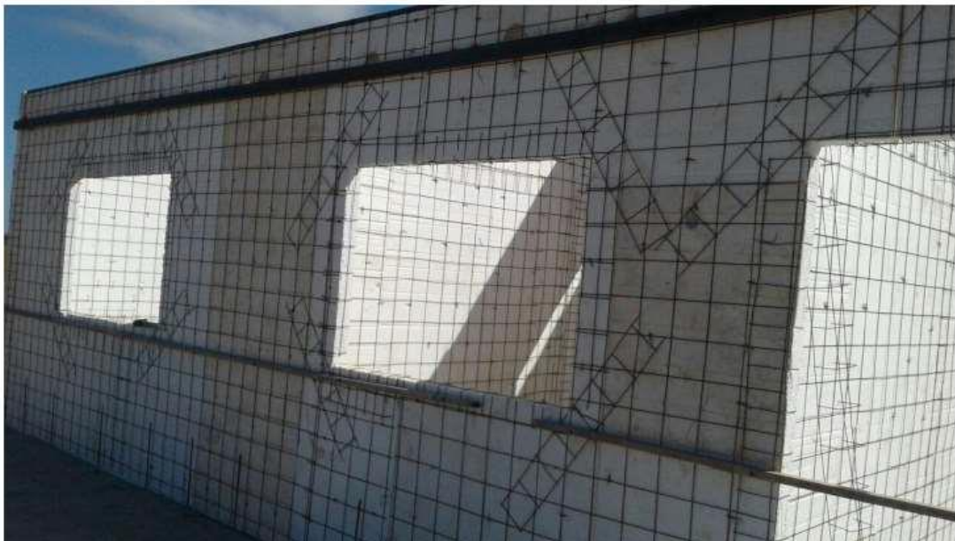
Imagem 4: Reforço em telas tipo liso e U.
