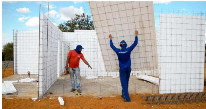
Imagem 3: Fixação dos painéis nas ancoragens
