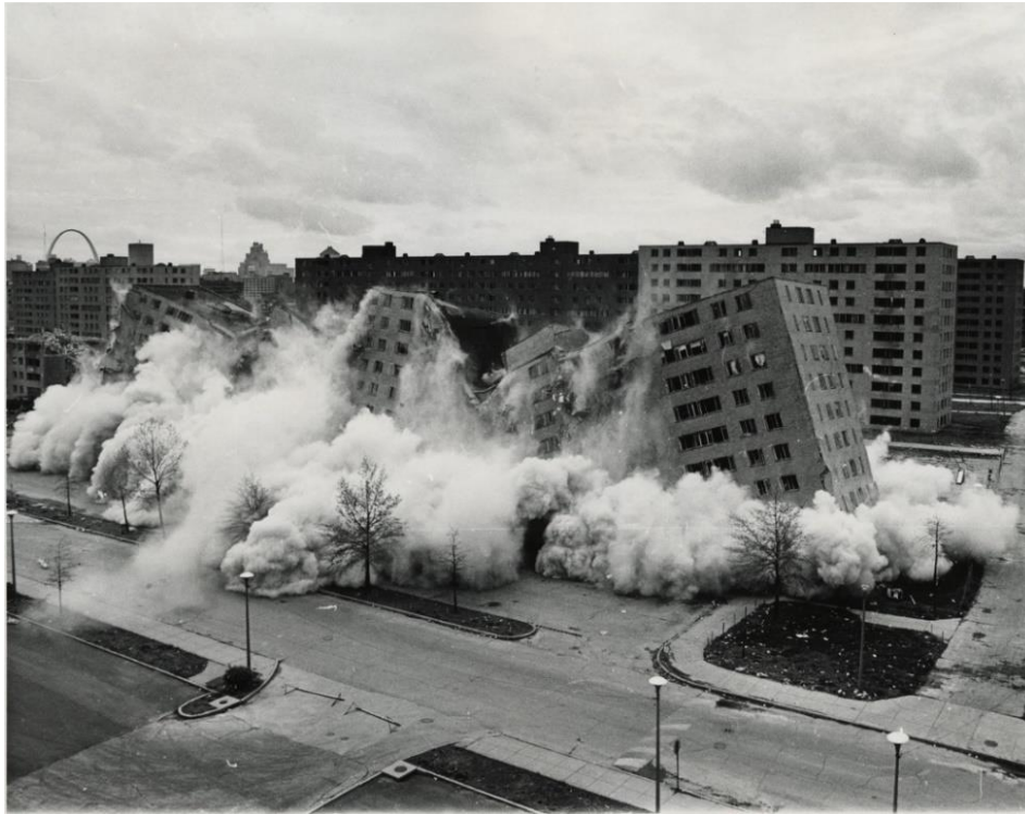
Imagem 15: Imagem da demolição
