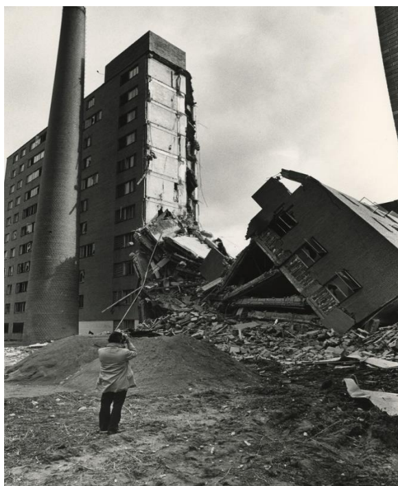
Imagem 15: Imagem da demolição
