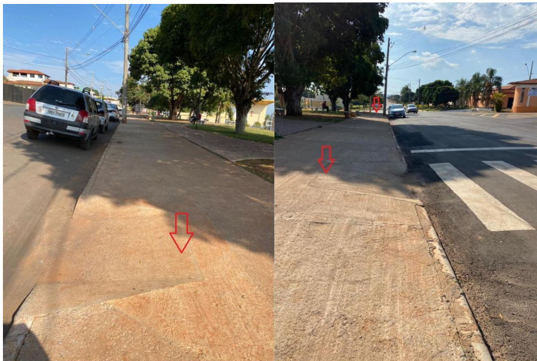
Imagem 30: Rampas de acessibilidade
