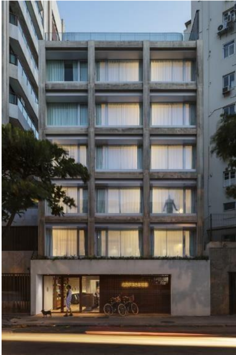
Imagem 20: Fachada Hotel Arpoador
