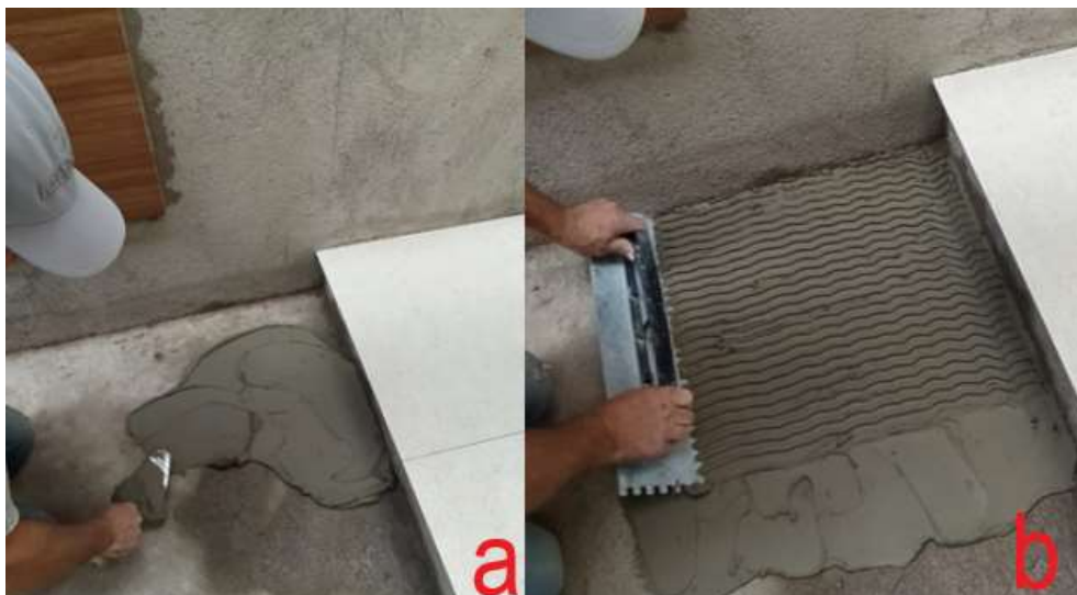
Figura 96 - Colocação da argamassa no chão
