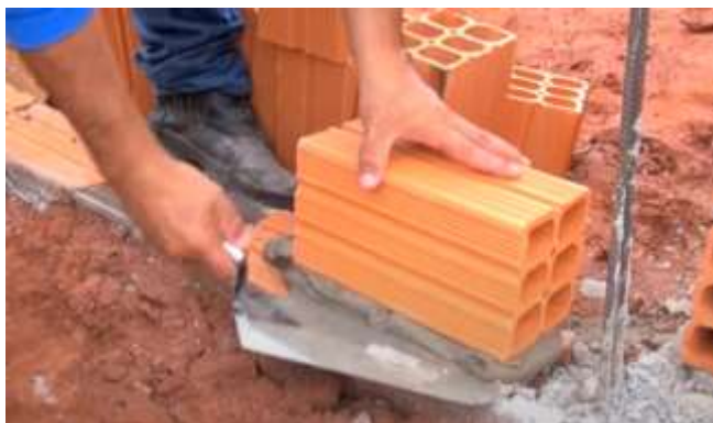
Figura 77 - Levantamento de parede: passo 1
