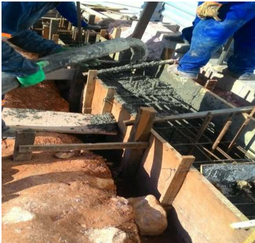
Figura 62 - Concretagem da viga de coroamento
