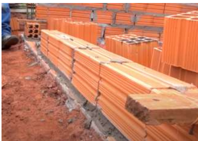
Figura 79 - Levantamento de parede: passo 3
