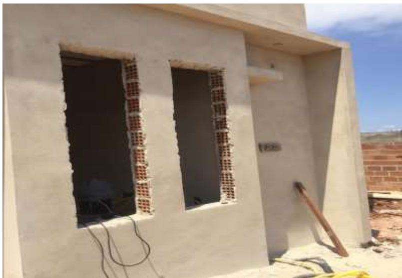
Figura 48 - Reboco externo
