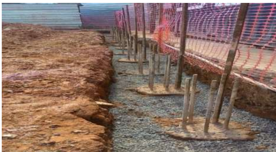
Figura 57 - Preparo para a viga de coroamento
