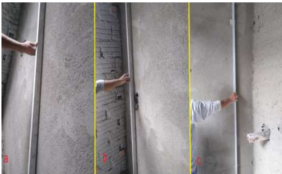
Figura 91 - Sarrafeamento da parede
