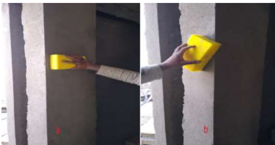
Figura 92 - Acabamento da parede com esponja
