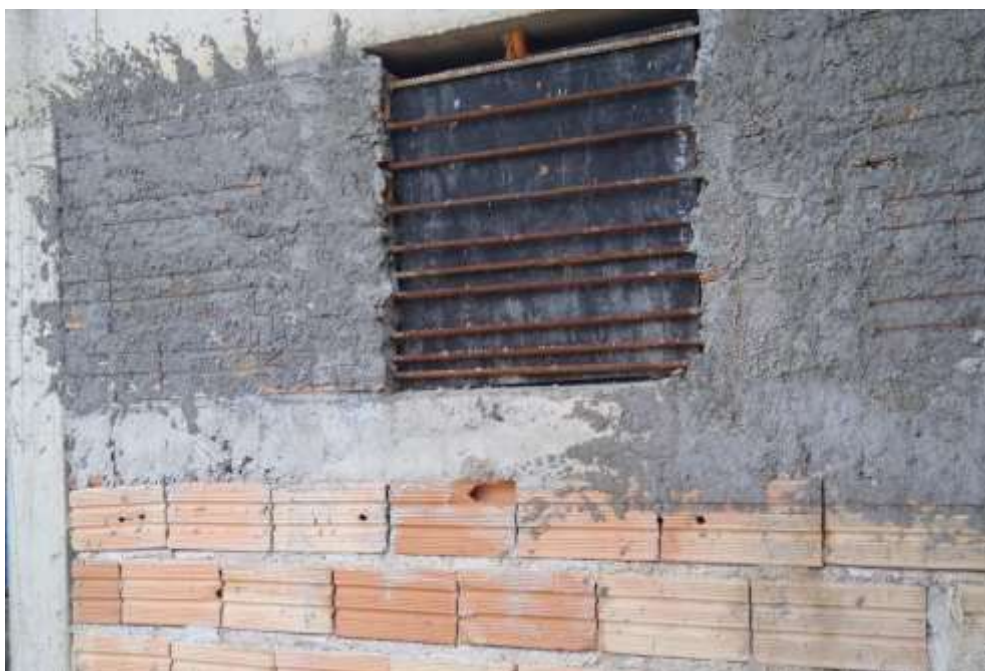
Figura 6 - Limpeza, travamento e contraverga
