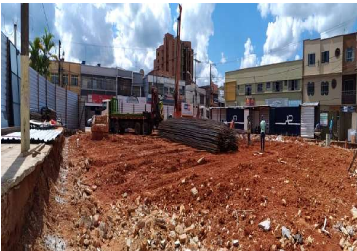
Figura 52 - Preparo do terreno para a perfuração
