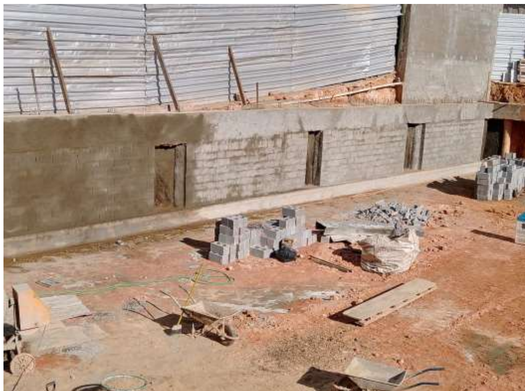
Figura 71 - Alvenaria concluída
