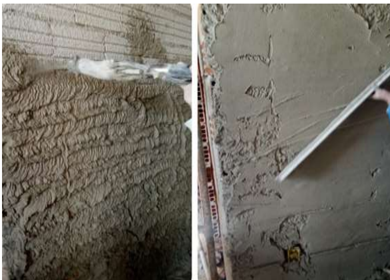
Figura 14 - Superfície sendo projetada
