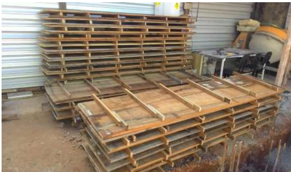
Figura 60 - Formas da viga de coroamento
