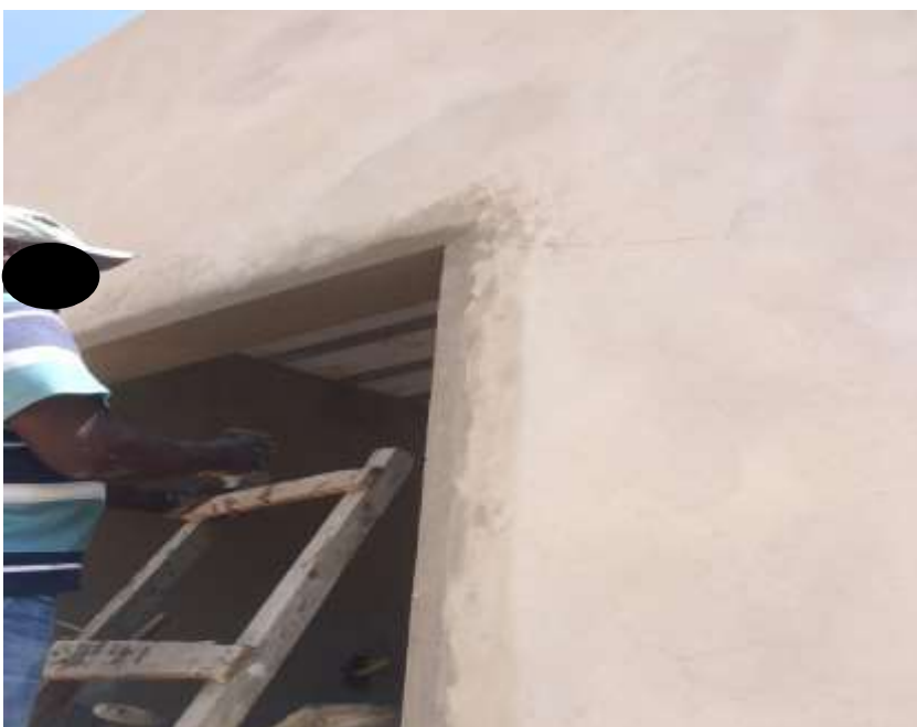
Figura 47 - Execução do reboco externo
