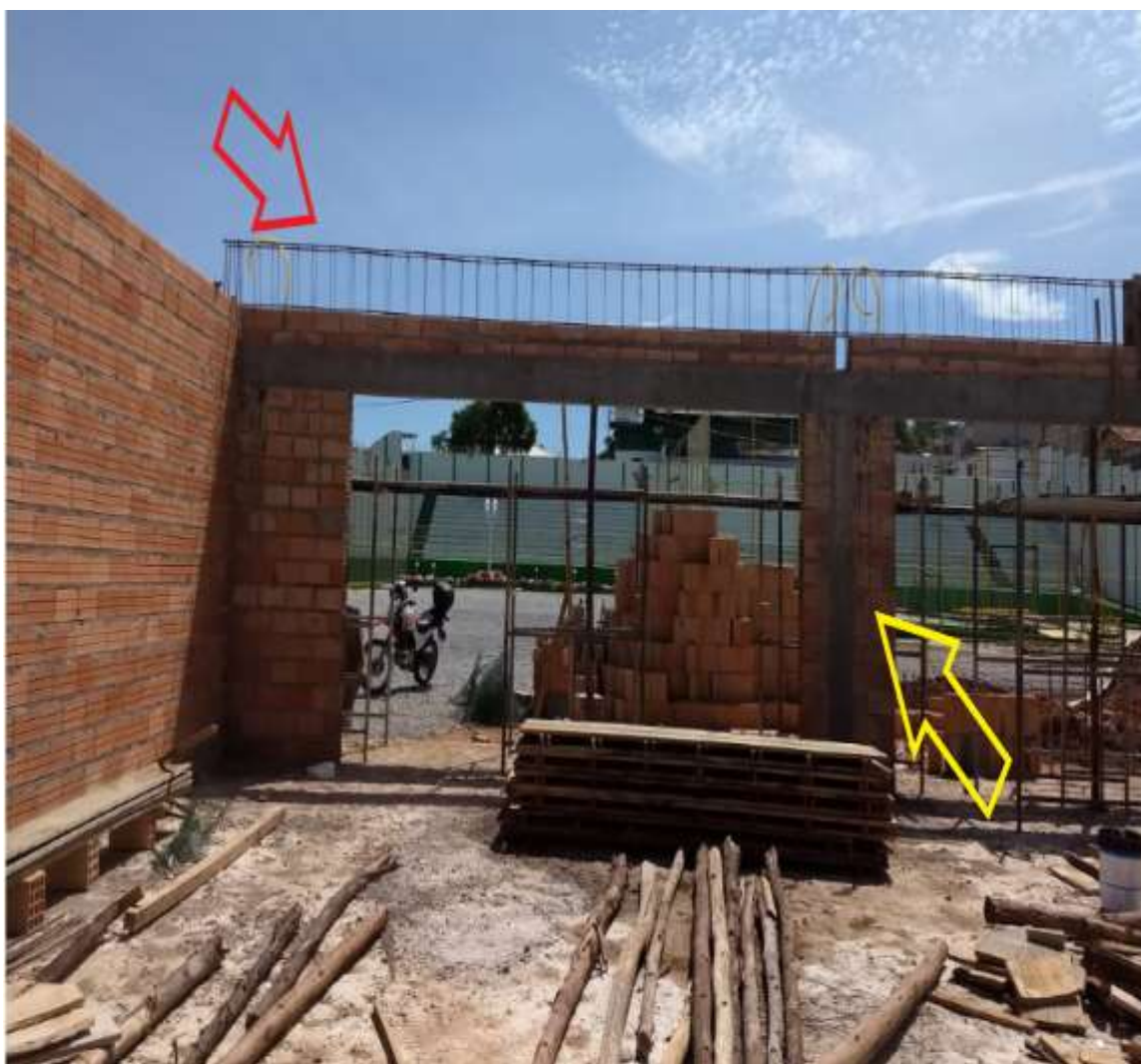
Figura 81 - Vigas e pilares de concreto armado
