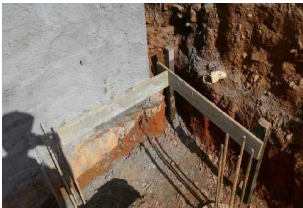
Figura 59 - Marcação do esquadro das vigas
