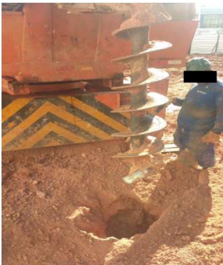
Figura 53 - Escavação da estaca
