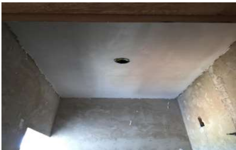
Figura 49 - Revestimento do teto em gesso liso
