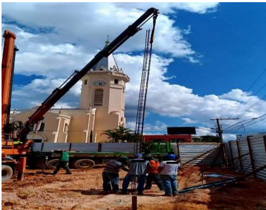
Figura 54 - Armação sendo posicionada dentro da perfuração
