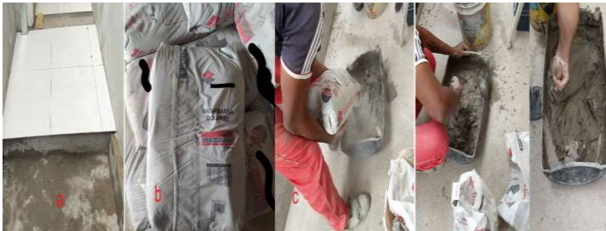
Figura 94 - Escolha da cerâmica, da argamassa e modo de preparo
