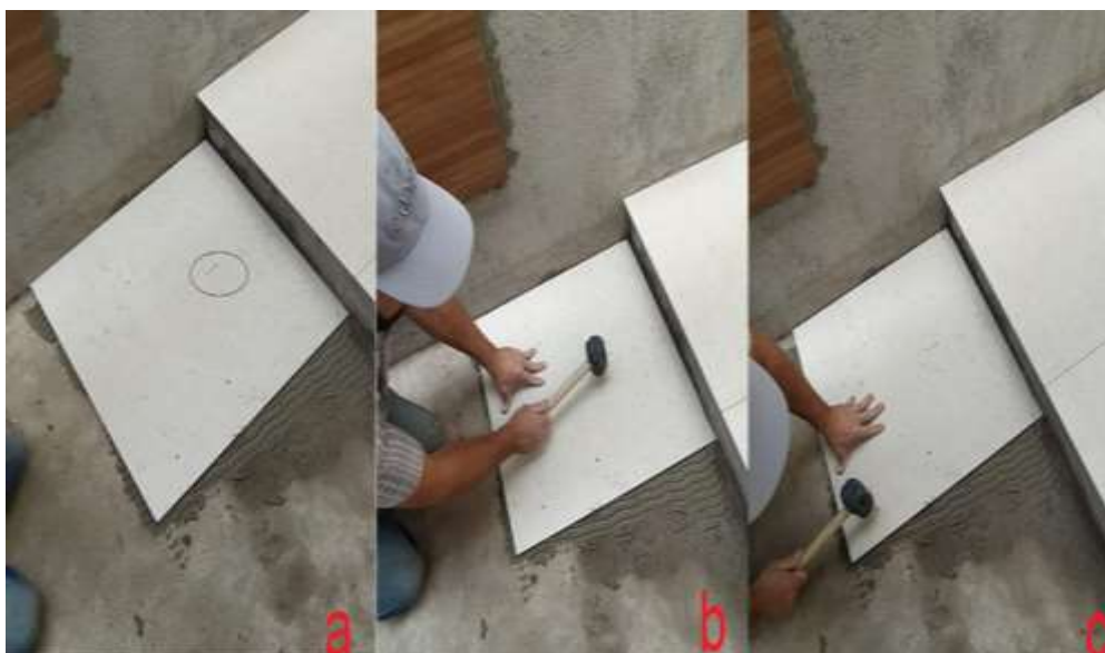
Figura 97 - Assentamento do piso
