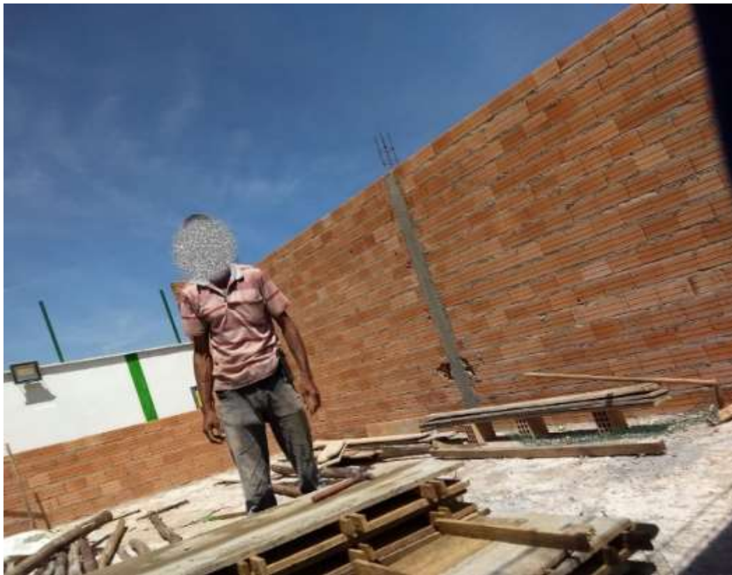
Figura 76 - Alvenaria de vedação
