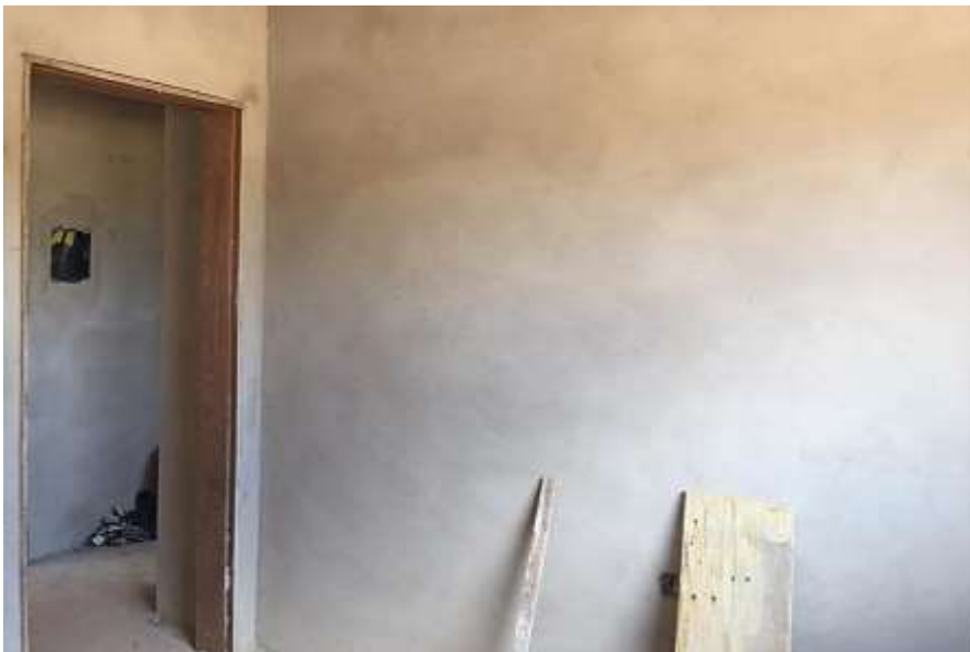
Figura 46 - Reboco interno
