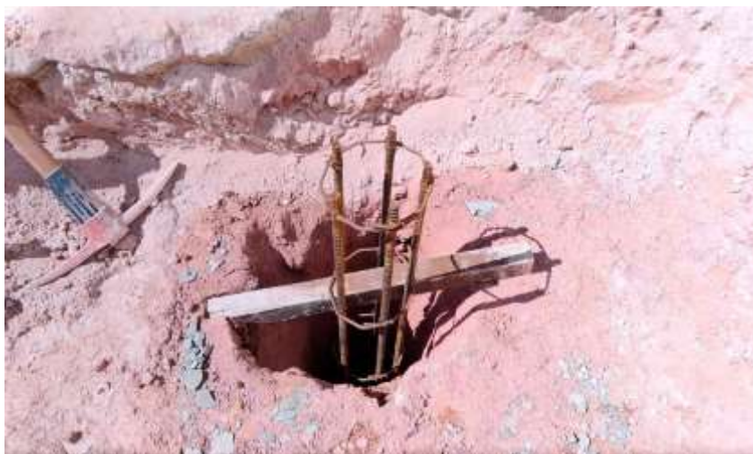
Figura 55 - Armação posicionada dentro da perfuração
