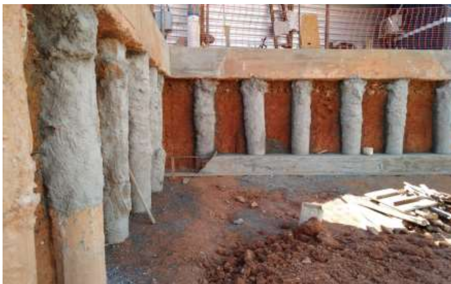
Figura 68 - Preparo para receber a alvenaria
