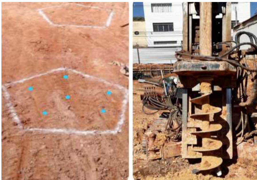
Figura 2 – Perfuração de Estacas
