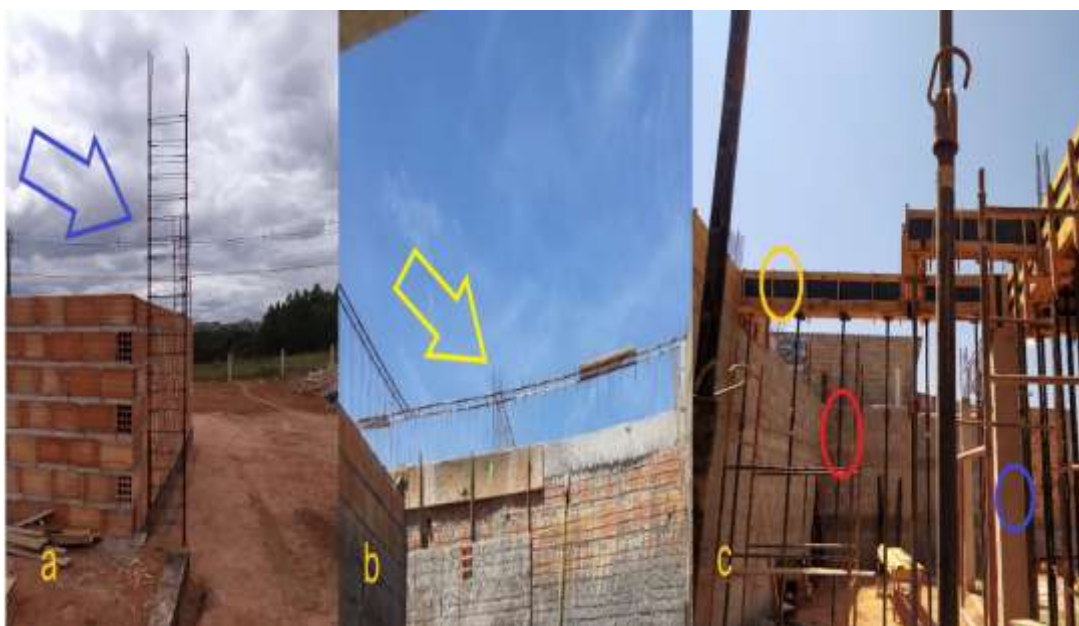
Figura 84 - Pilar, vigas e escoramento
