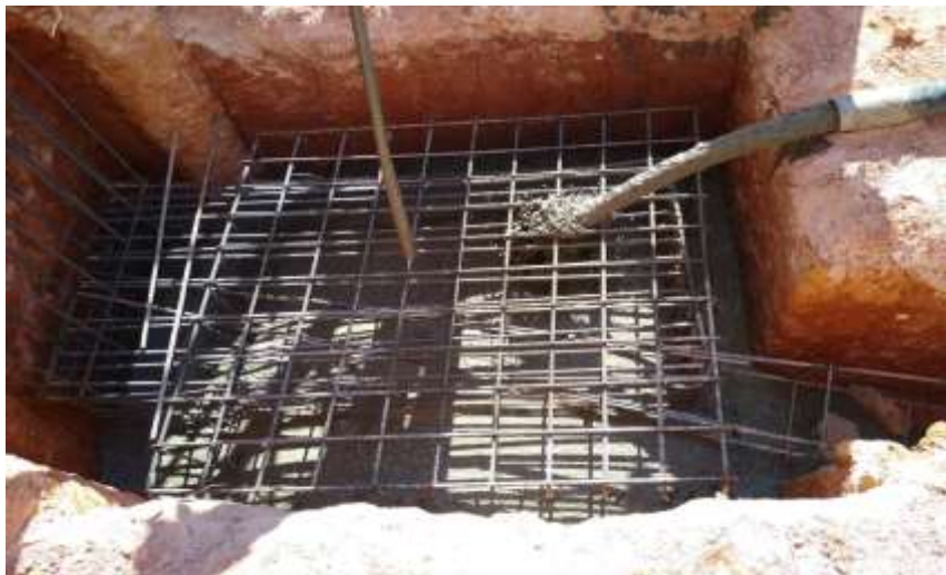
Figura 4 - Concretagem de Bloco de Coroamento
