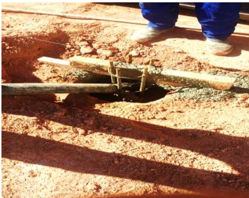
Figura 56 - Concretagem das estacas
