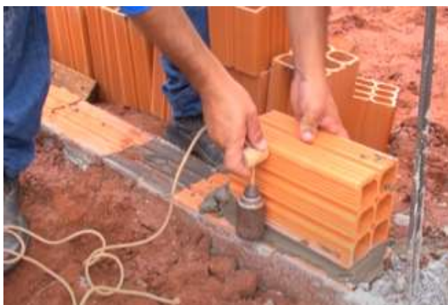
Figura 78 - Levantamento de parede: passo 2
