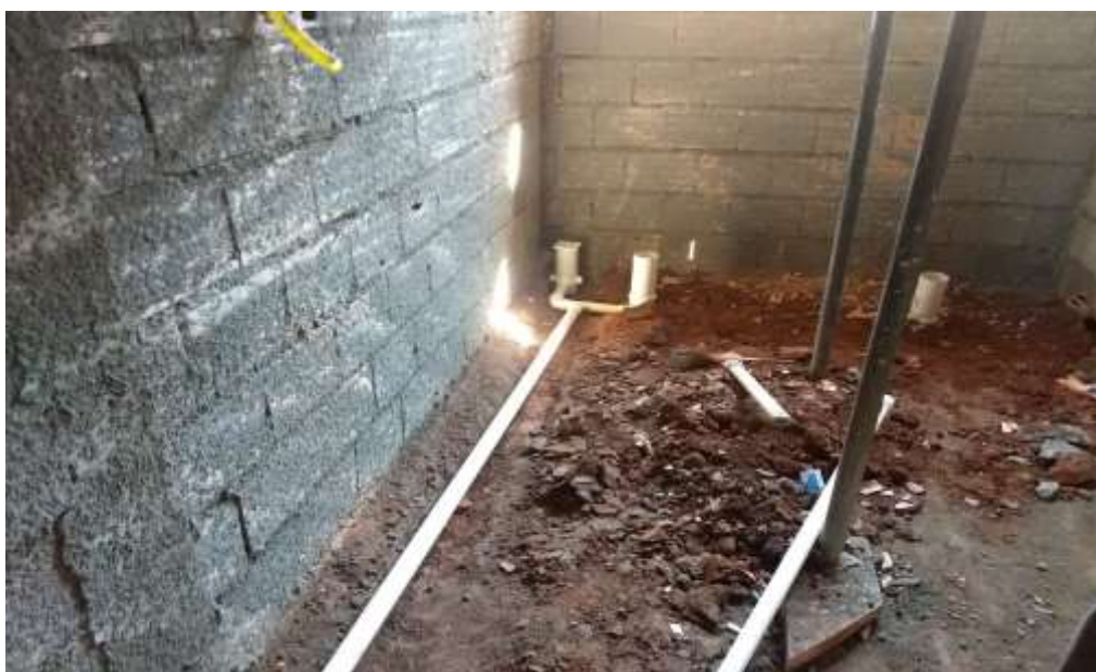
Figura 101 - Ligação sanitária de esgoto
