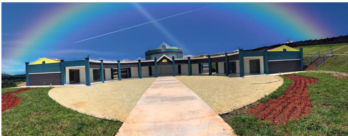
Figura 51 - Resultado final da obra
