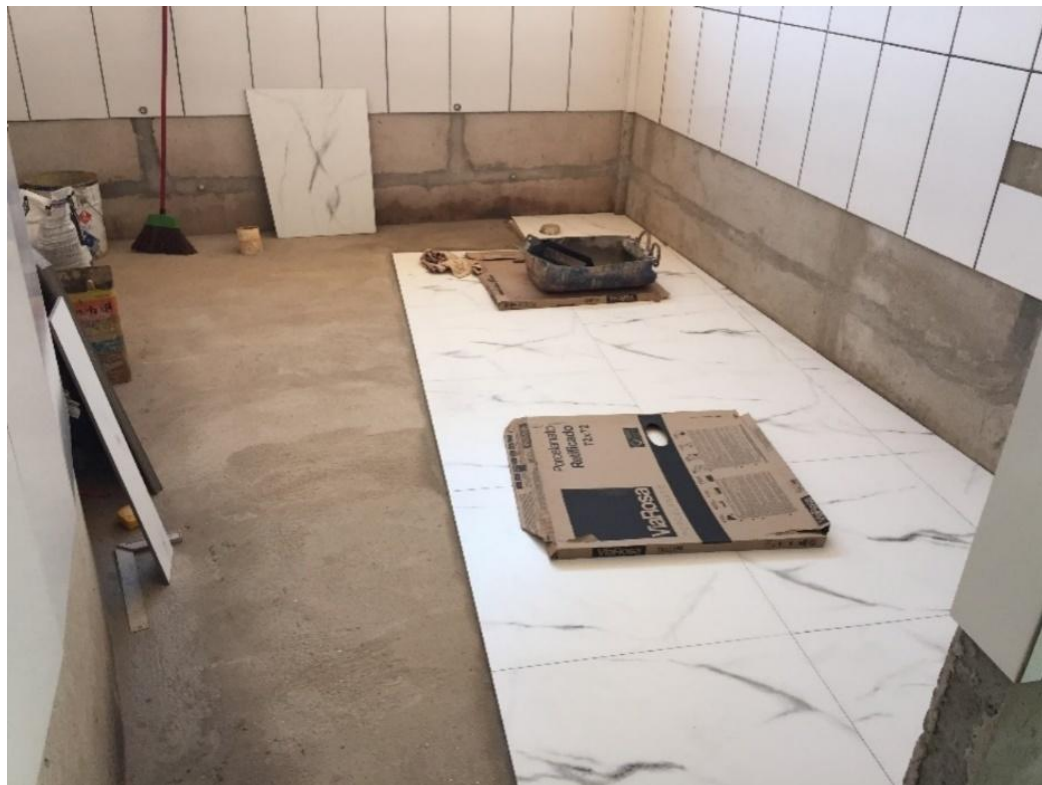
Figura 44 - Assentamento de pisos e azulejos
