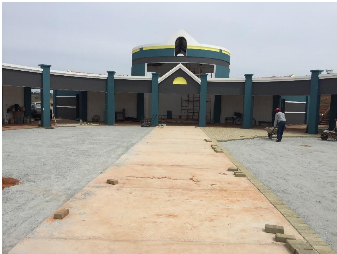
Figura 42 - Nivelamento do solo para assentamento do piso intertravado
