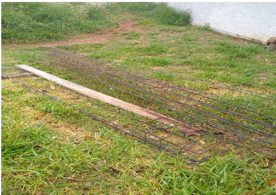
Figura 34 - Armaduras confeccionadas
