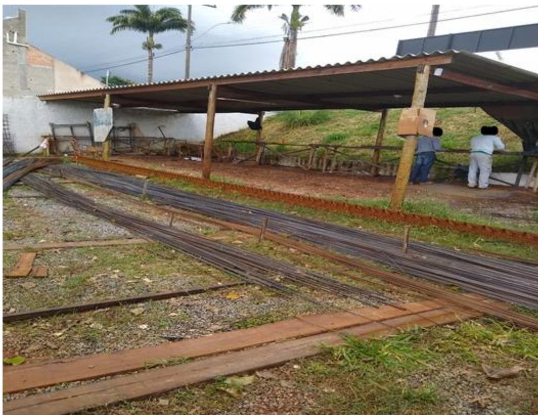
Figura 28 - Local da fabricação das armaduras
