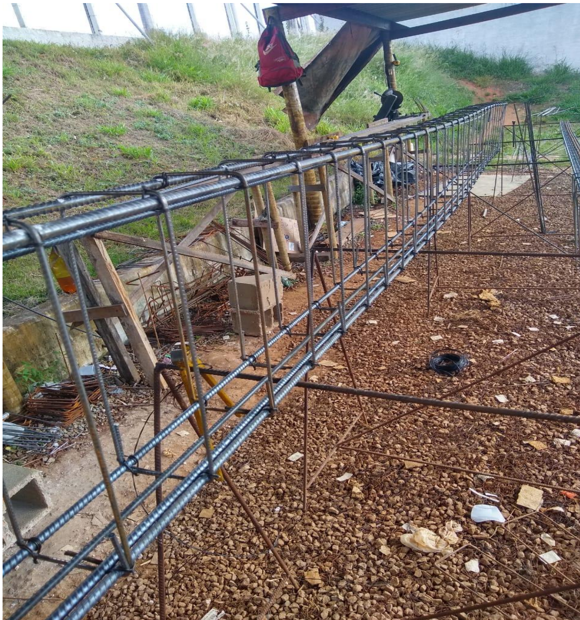
Figura 33 - Barras com os estribos
