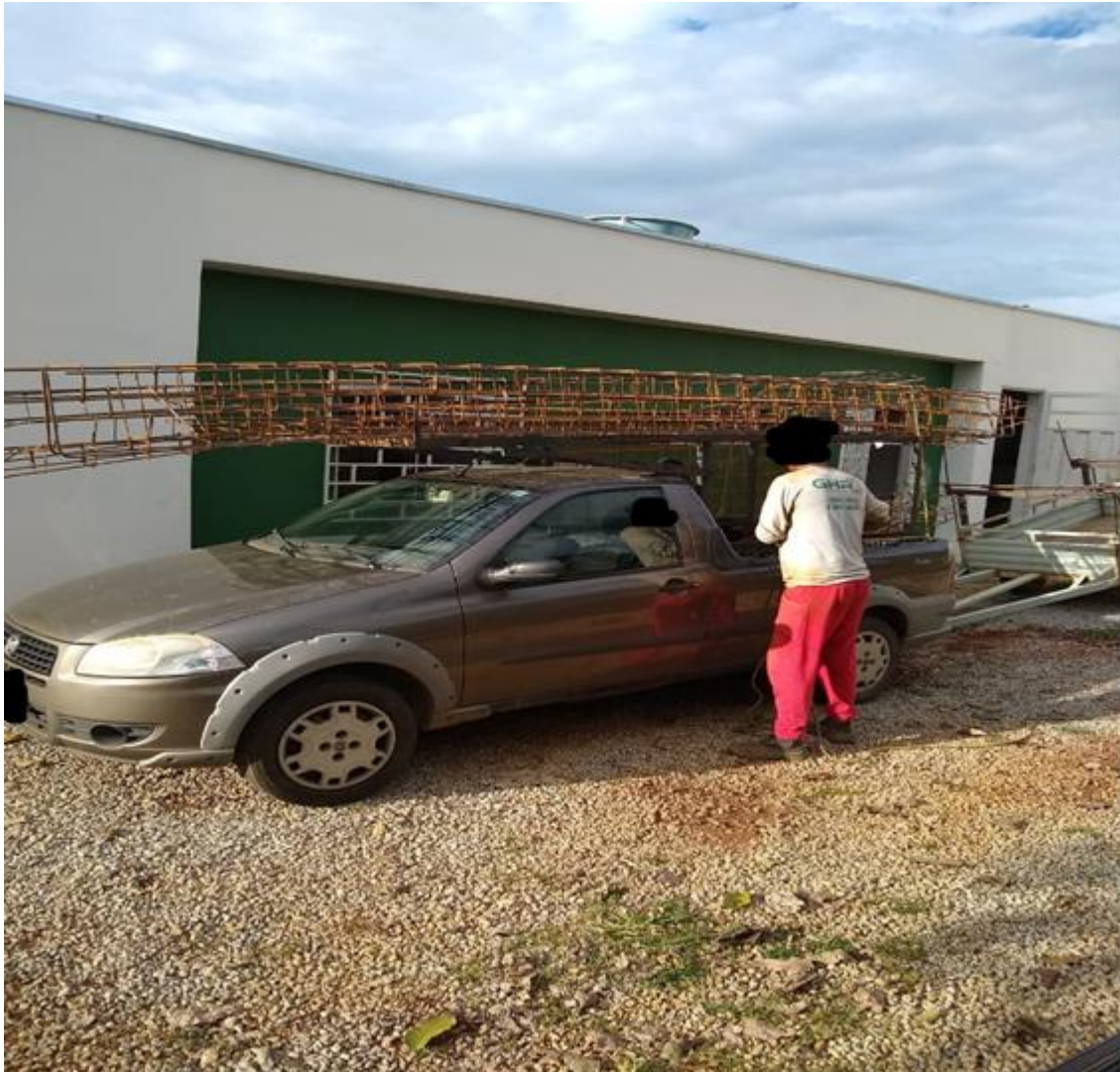
Figura 35 - Transporte das estruturas
