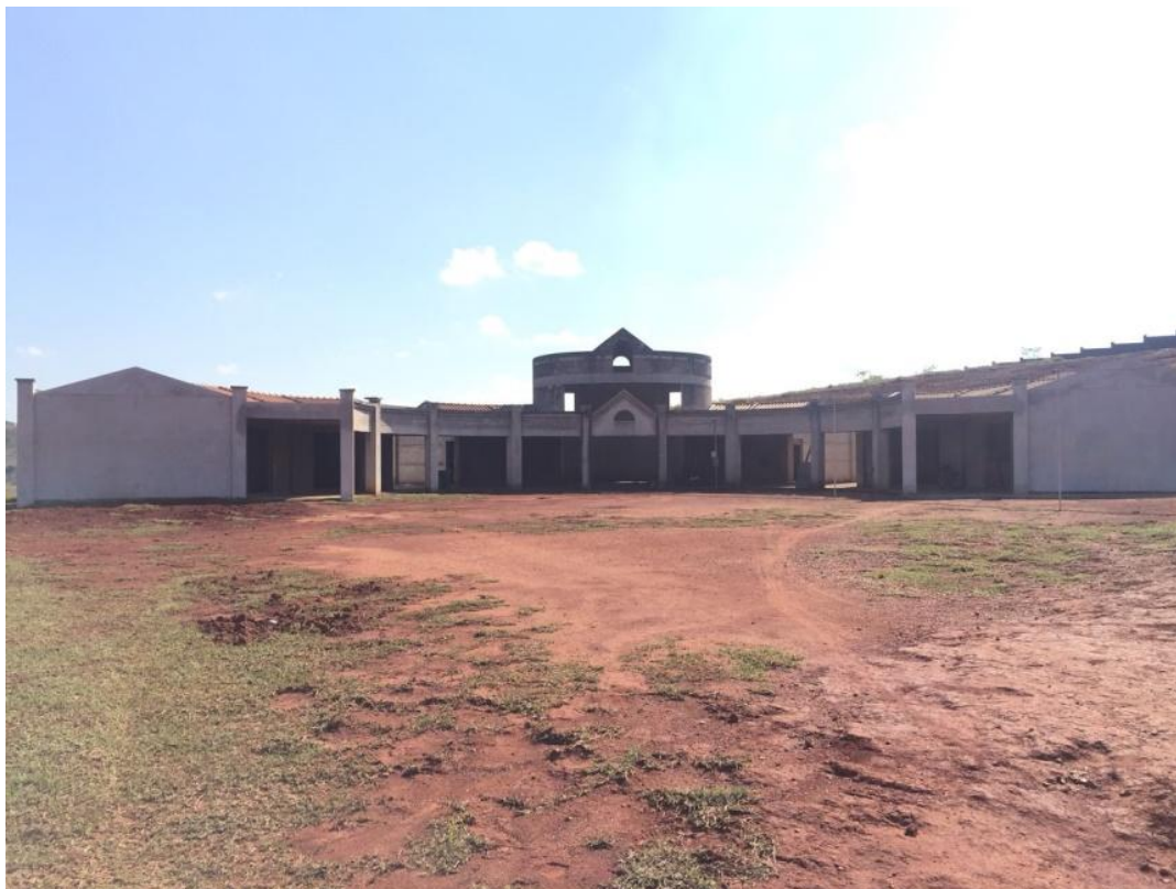
Figura 40 - Capela e velórios antes dos acabamentos
