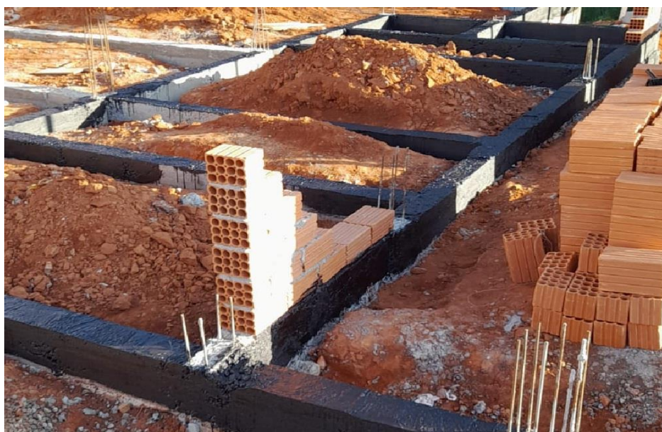
Figura 12 – Marcação e início da alvenaria de vedação
