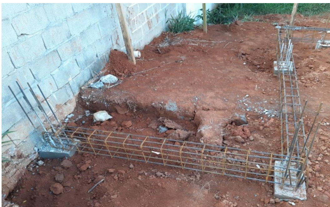
Figura 10 – Montagem das vigas Baldrames
