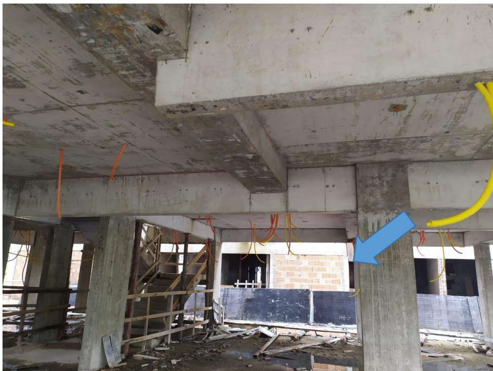
Figura 44 – Pilares de concreto armado
