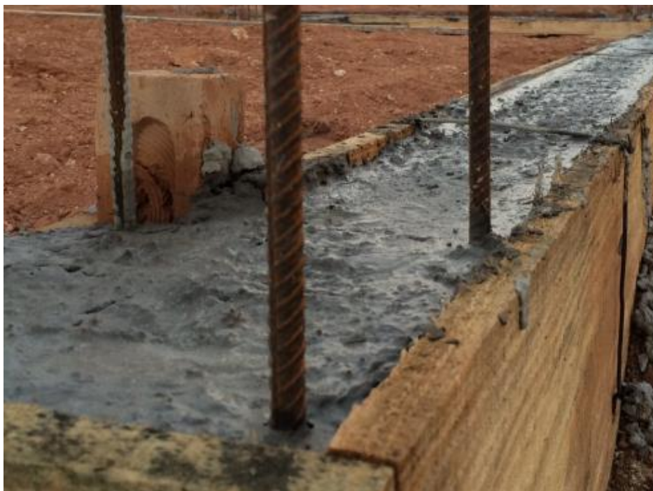
Figura 60 – Fechamento e concretagem da viga baldrame
