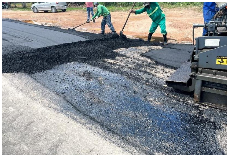
Figura 43 – Manutenção do pavimento
