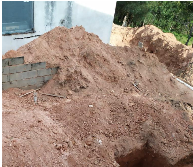
Figura 34 – Exemplo de empolamento
