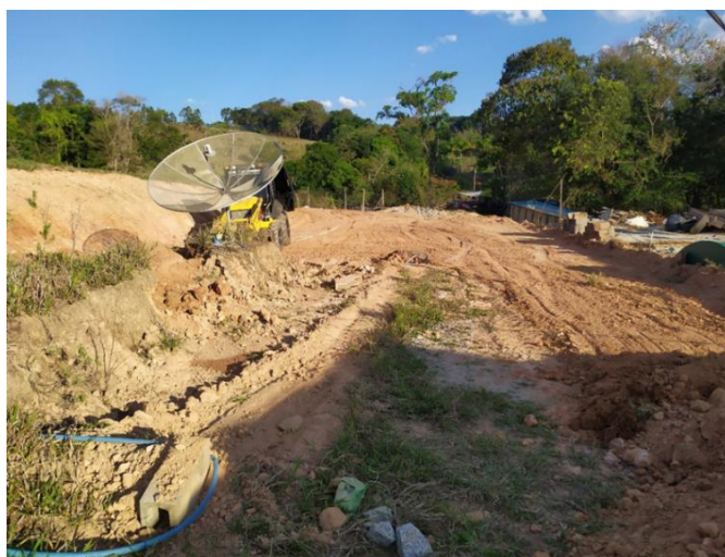
Figura 30 – Limpeza do Terreno
