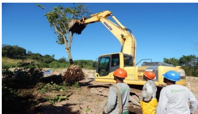
Figura 31 – Remoção de árvore
