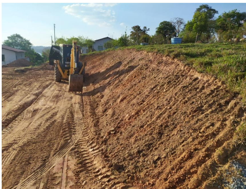
Figura 33 – Exemplo de escavação
