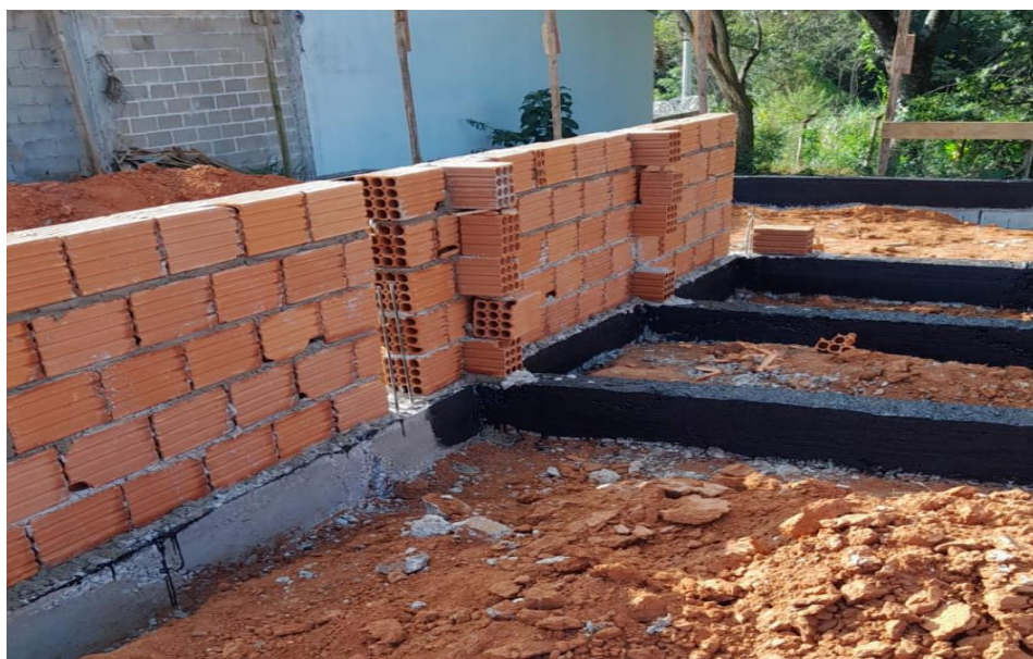
Figura 13 – Execução da Alvenaria de vedação
