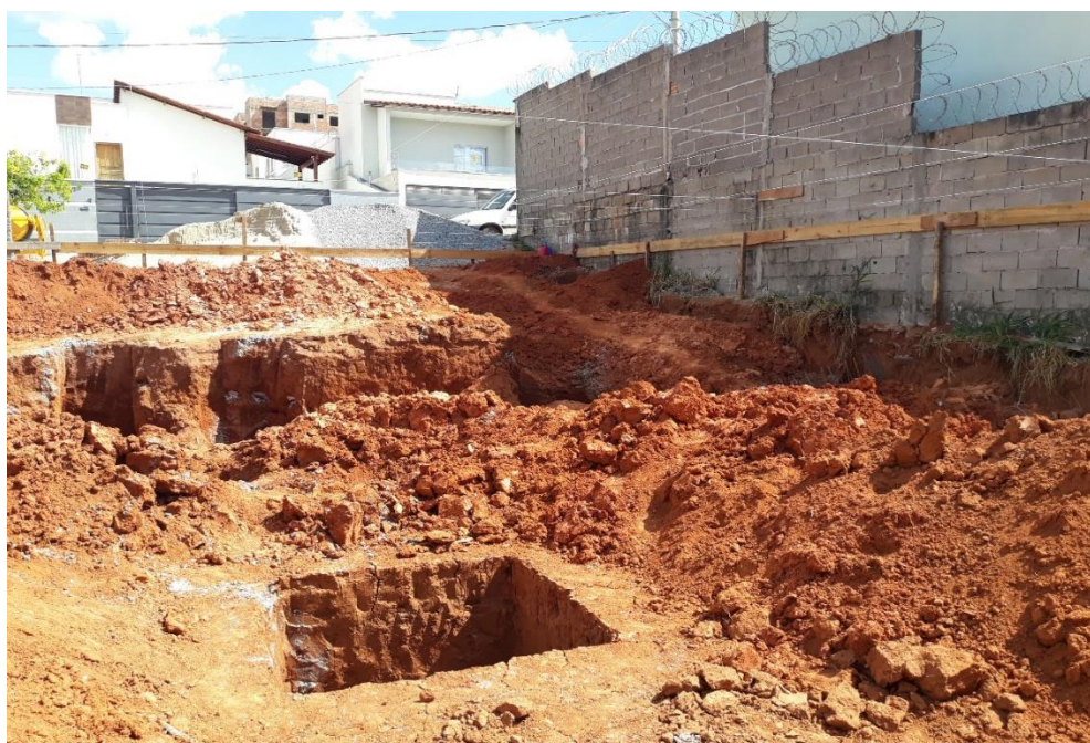
Figura 3 – Perfuração das valas de fundação
