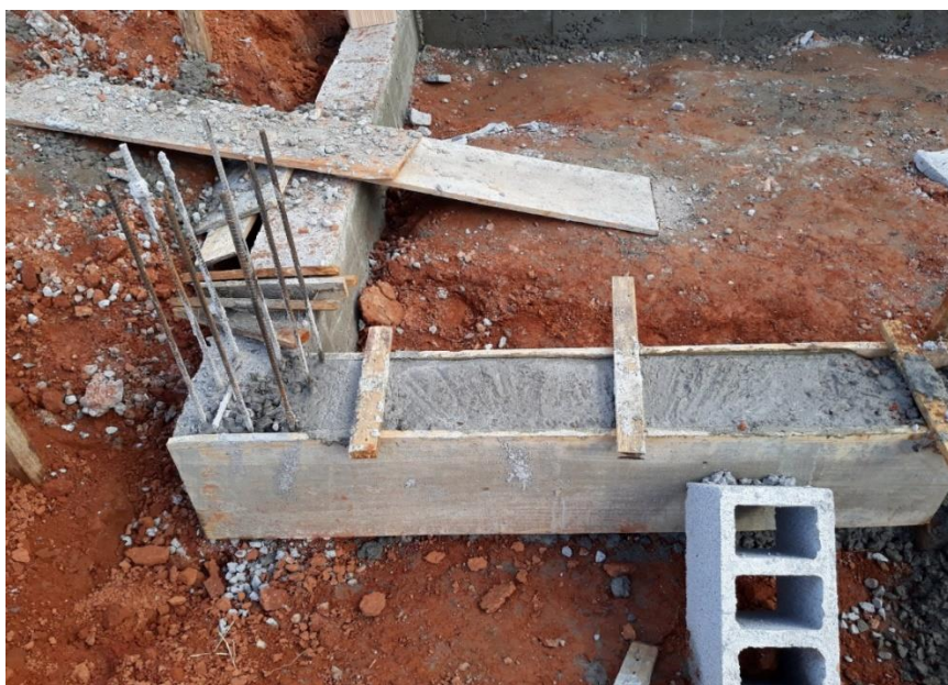
Figura 11 – Concretagem das vigas Baldrames
