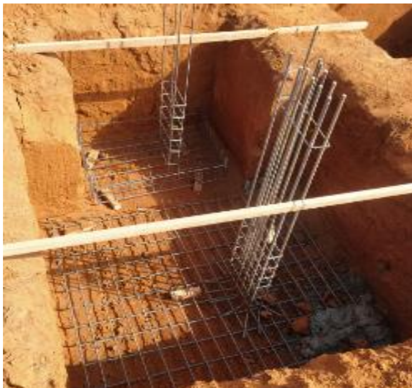
Figura 59 – Arranque de Pilar
