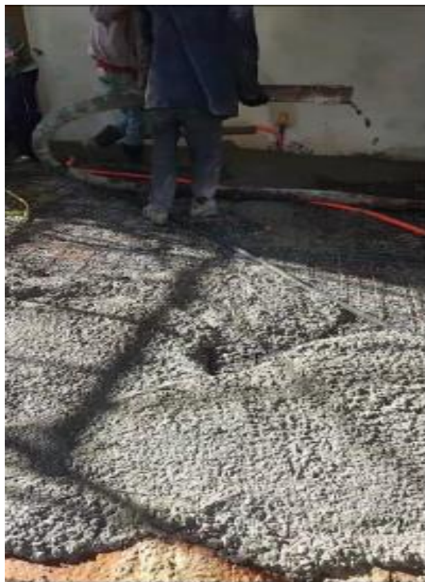
Figura 63 – Concretagem do contra piso
