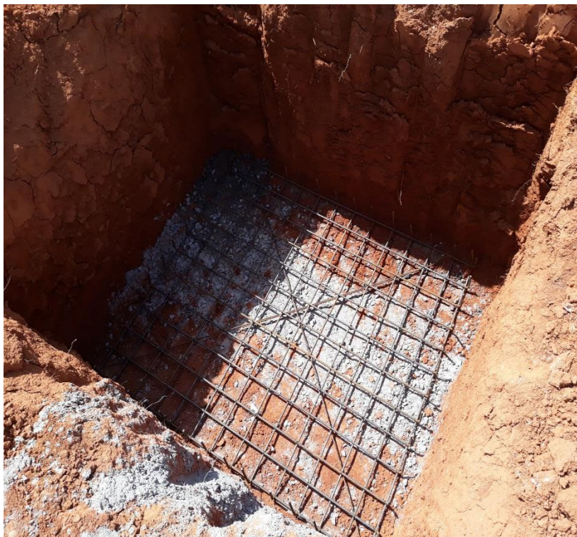
Figura 5 – Lastro de concreto das sapatas
