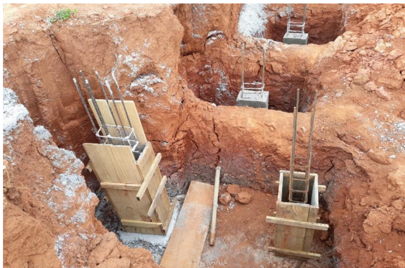
Figura 8 – Montagem das formas dos pilares
