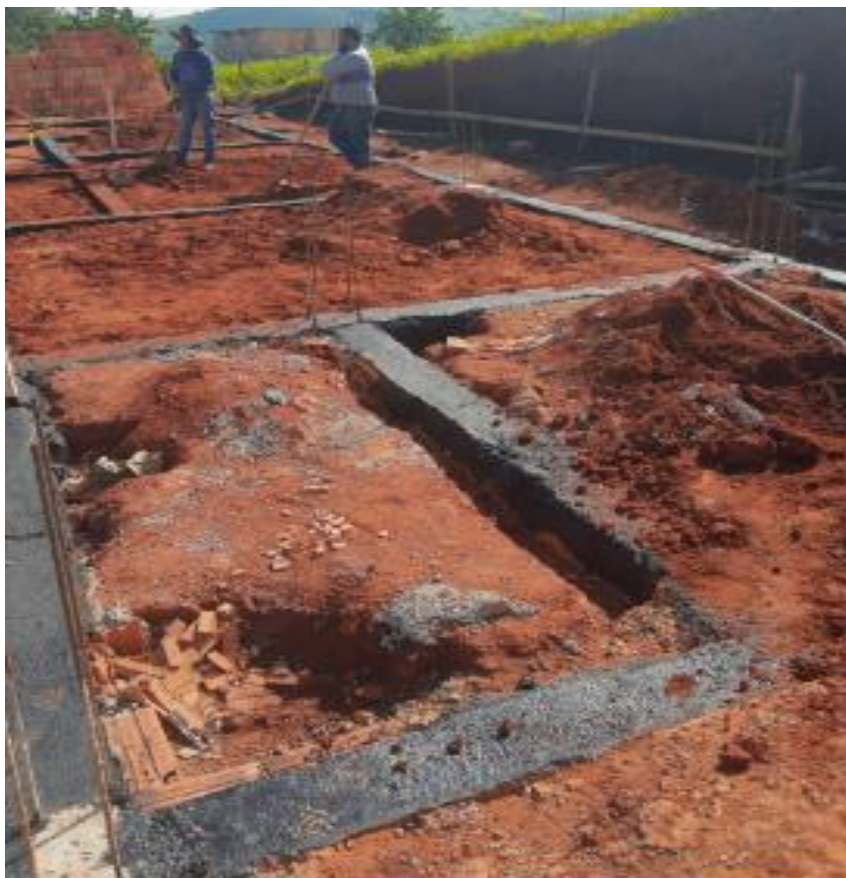
Figura 62 – Nivelamento da área interna
