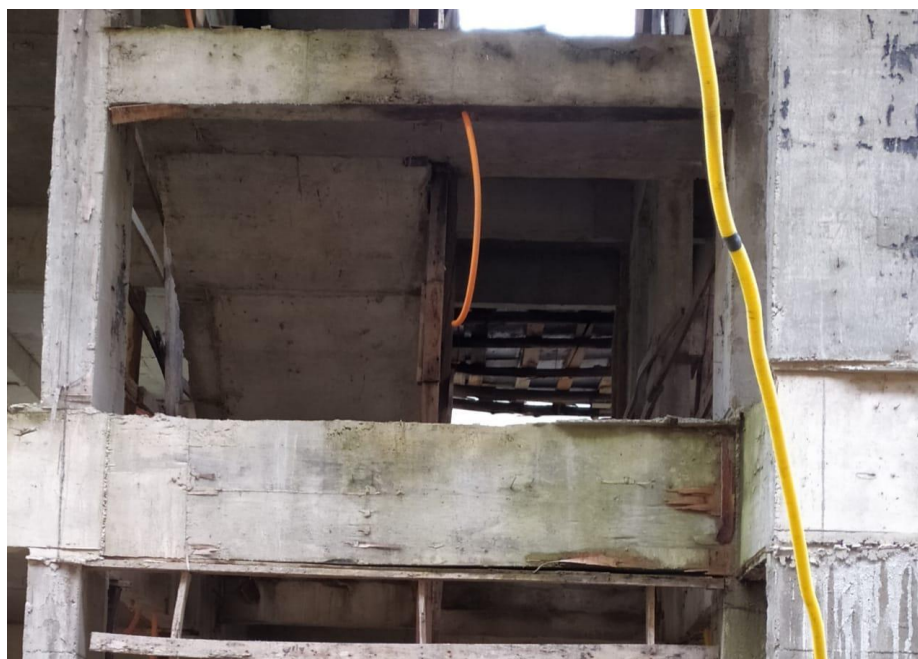
Figura 48 – Vigas e pilares
