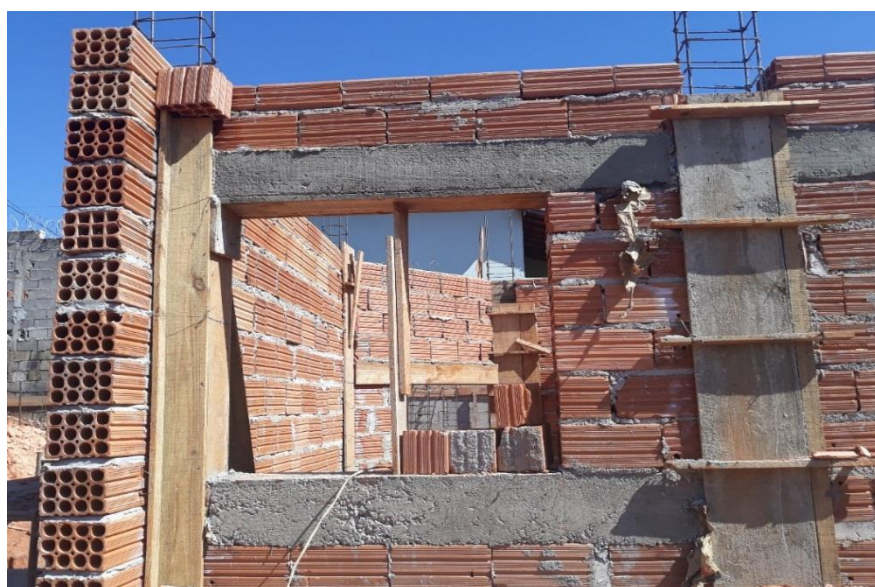
Figura 17 – Vergas e Contravergas Realizada
