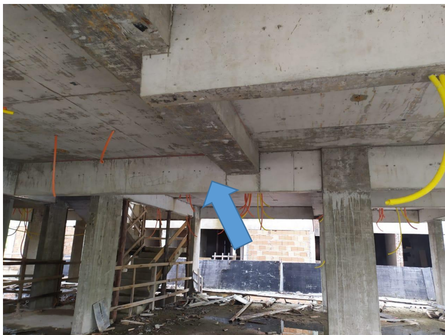
Figura 45 – Vigas de concreto armado
