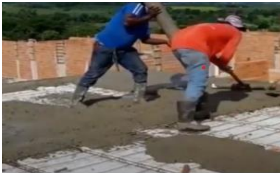
Figura 67 – Concretagem da laje treliçada
