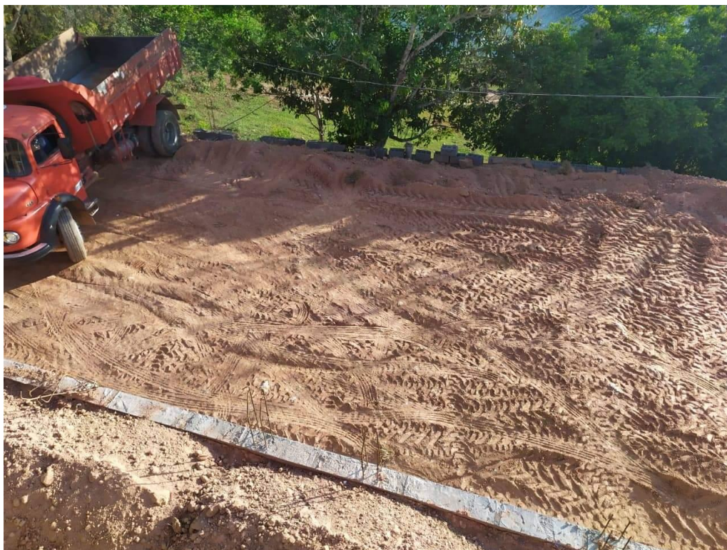
Figura 35 – Espalhamento dos materiais
