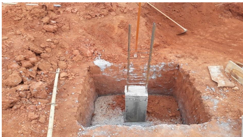
Figura 9 – Concretagem dos pilares da sapata
