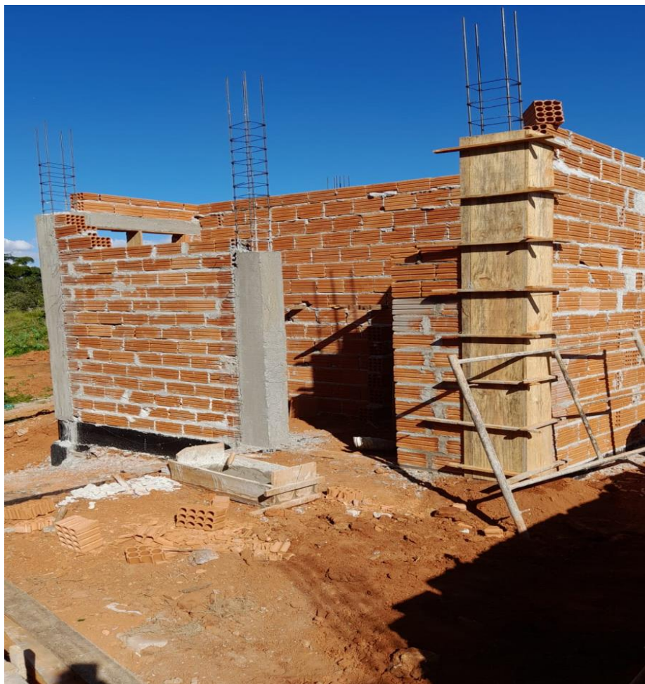
Figura 15 – Pilares Concretados com forma e finalizados
