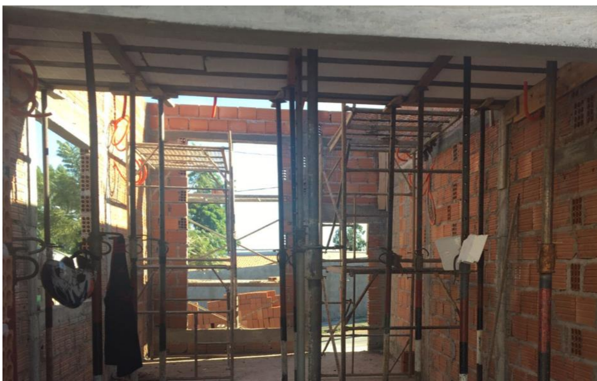
Figura 66 – Escoramento metálico
