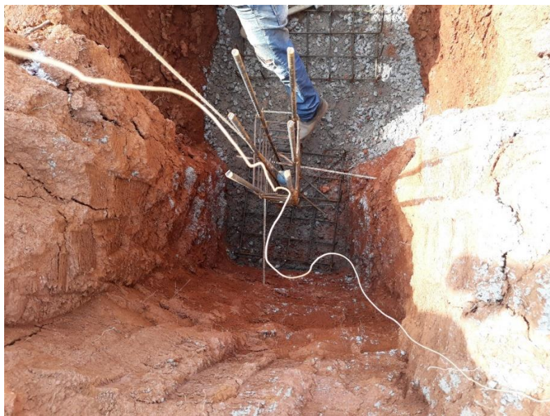
Figura 6 – Alinhamento e amarração do arranque do pilar
