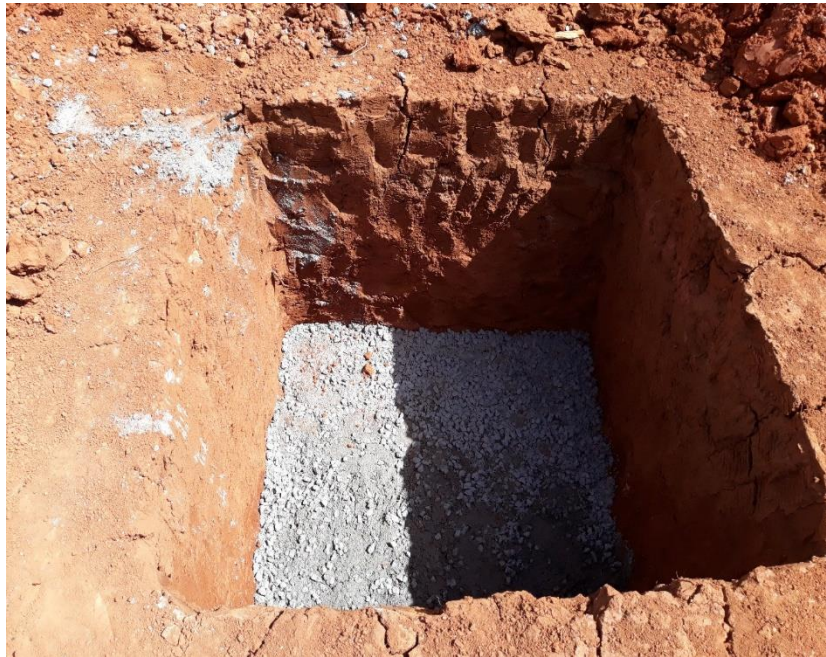
Figura 4 – Conferência da dimensão da sapata
