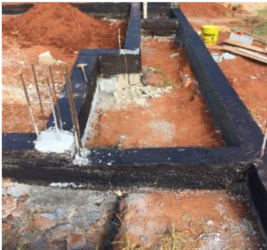
Figura 61 – Vigas impermeabilizadas
