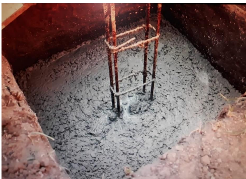
Figura 7 – Concretagem do arranque do pilar
