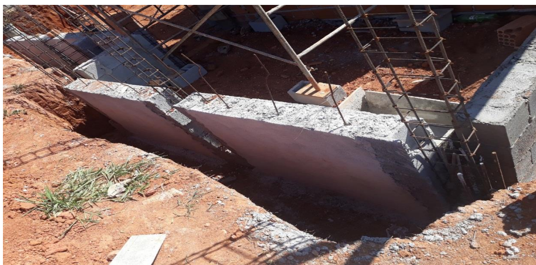
Figura 14 – Pilar antes da concretagem
