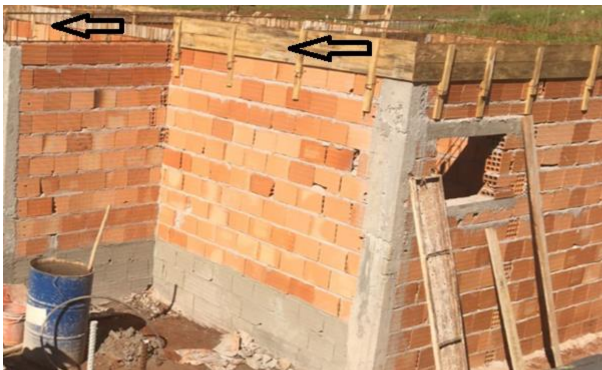
Figura 65 – Estrutura viga apoiada
