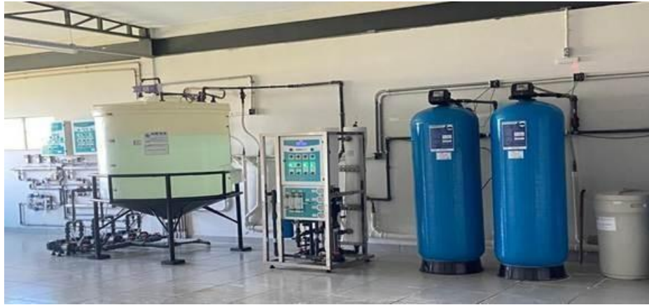
Figura 3 – Tanque de osmose reversa da água, para utilizar na hemodiálise.
