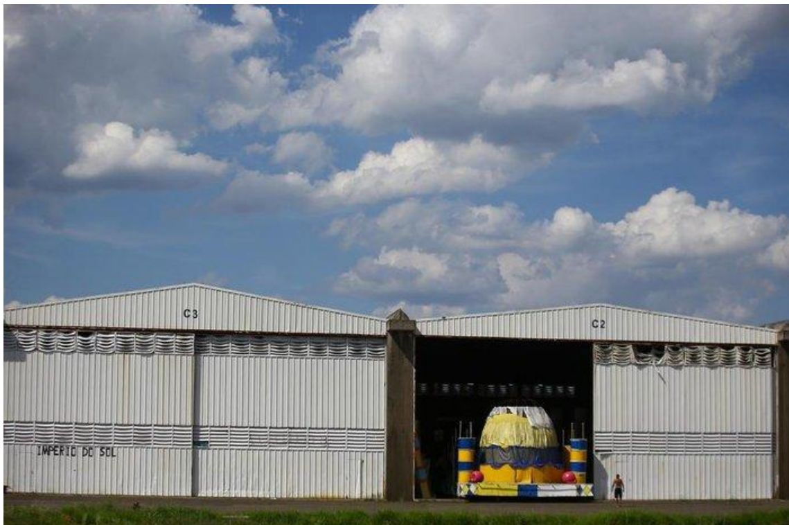
Figura 21 - Fachada dos Barracões
