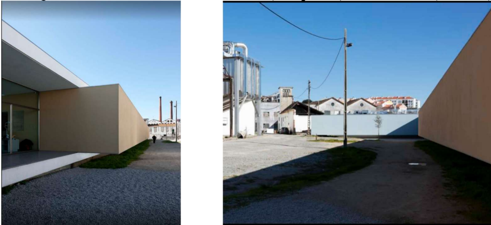
Figura 20 – Fachada Norte vista Leste (à esquerda) e vista Oeste (à direita)
