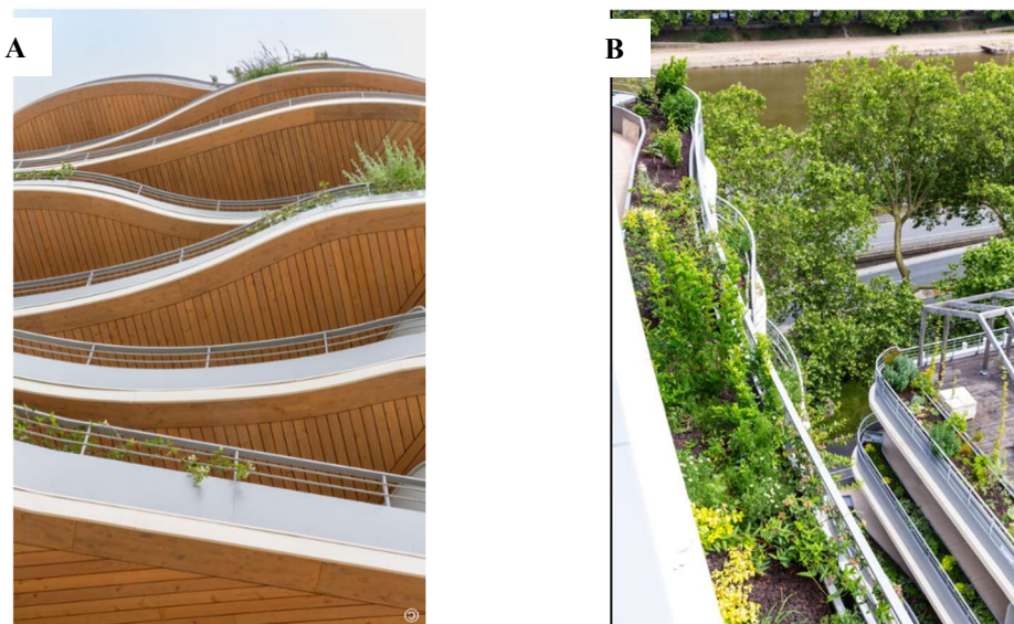
Figura 15 – Imagem A representa as curvas das varandas possibilitando as vistas desobstruídas e Imagem B representa as áreas plantadas para melhorar o conforto térmico
