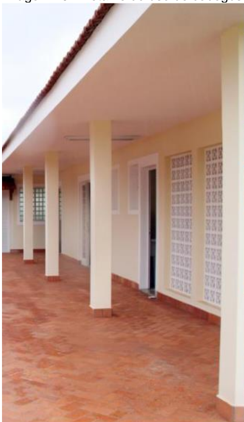
Imagem 19 - Detalhe do uso de cobogós
