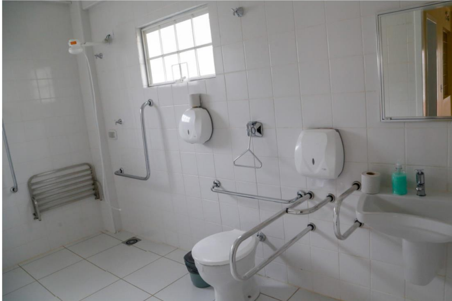
Imagem 20 - Imagem interna do banheiro
