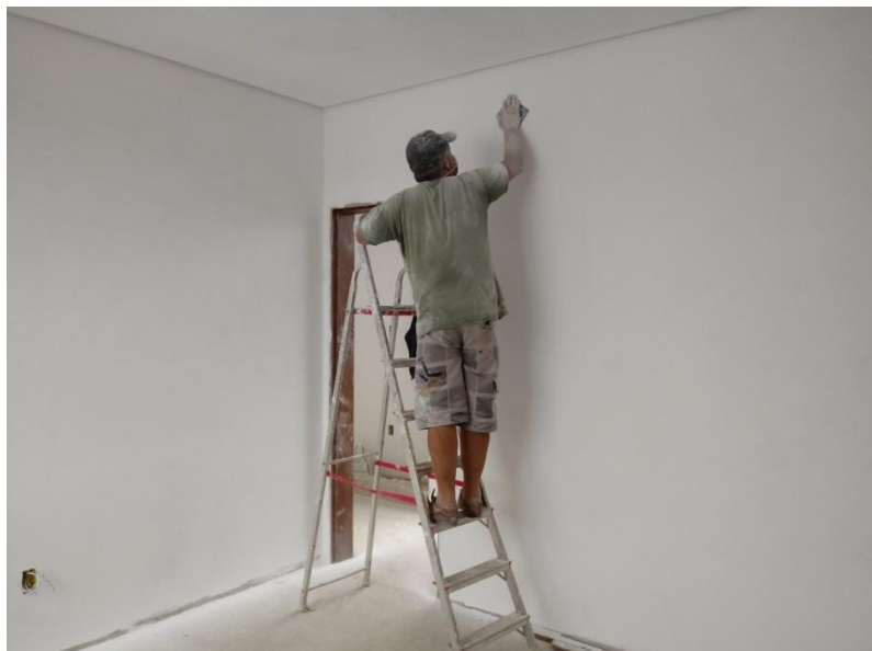
Figura 28 – Lixamento de parede depois de receber a massa corrida
