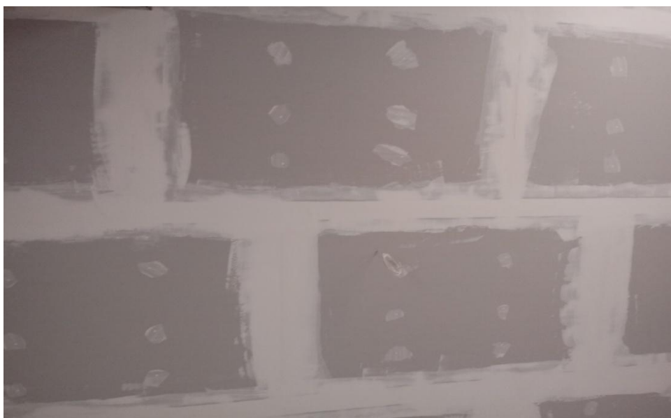
Figura 36 – Rejuntamento das placas de gesso
