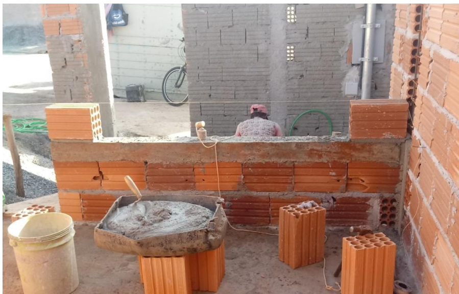
Figura 48 – Marcação do alinhamento
