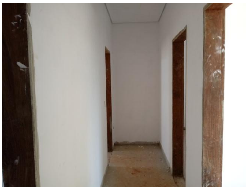
Figura 27 – Massa corrida nas paredes
