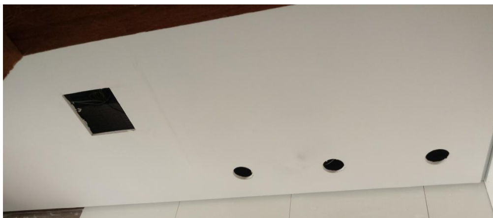
Figura 37 – Corte da placa para iluminação
