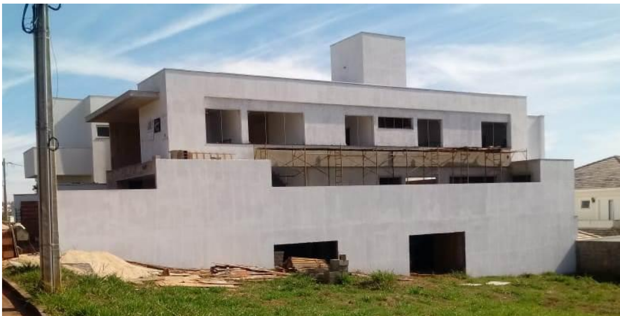
Figura 30 – Selador acrílico aplicado nas paredes externas
