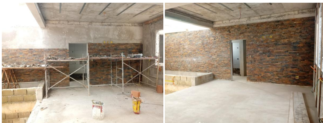
(a) Assentamento de revestimento
