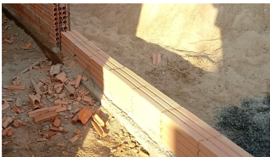
Figura 49 – Primeira fiada da alvenaria
