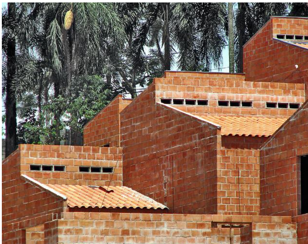
Figura 39 – Alvenaria estrutural
