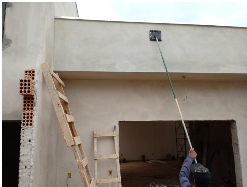
Figura 26 – Lixamento de parede
