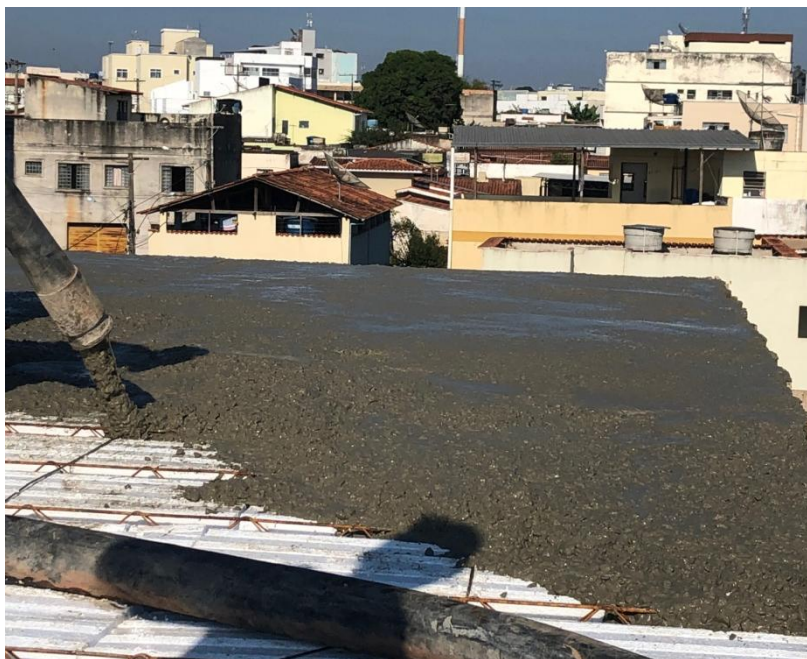
Figura 14 – Lançamento do concreto na laje pré-moldada de isopor.
