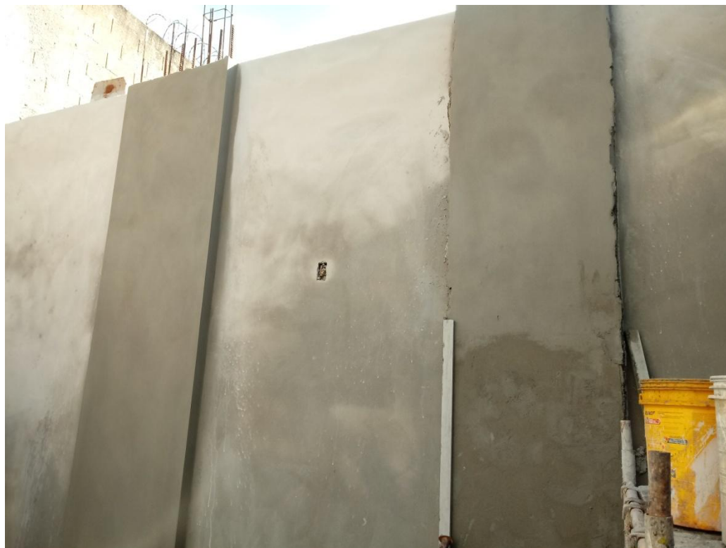
Figura 19 – Reboco
