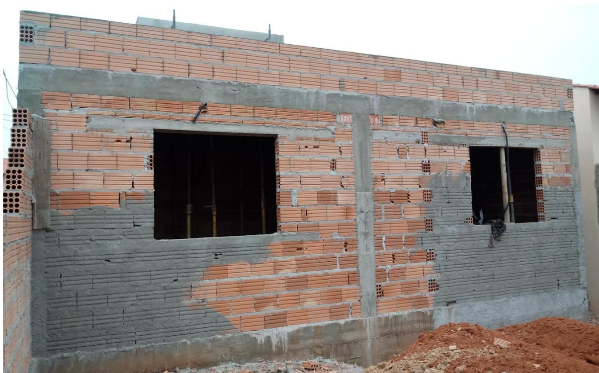
Figura 40 – Alvenaria de vedação
