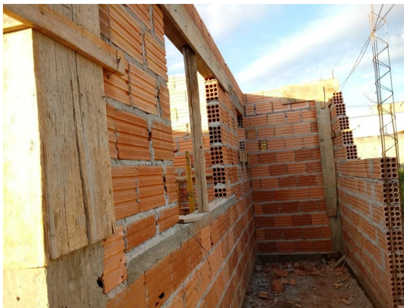
Figura 47 – Tijolos assentados de cutelo
