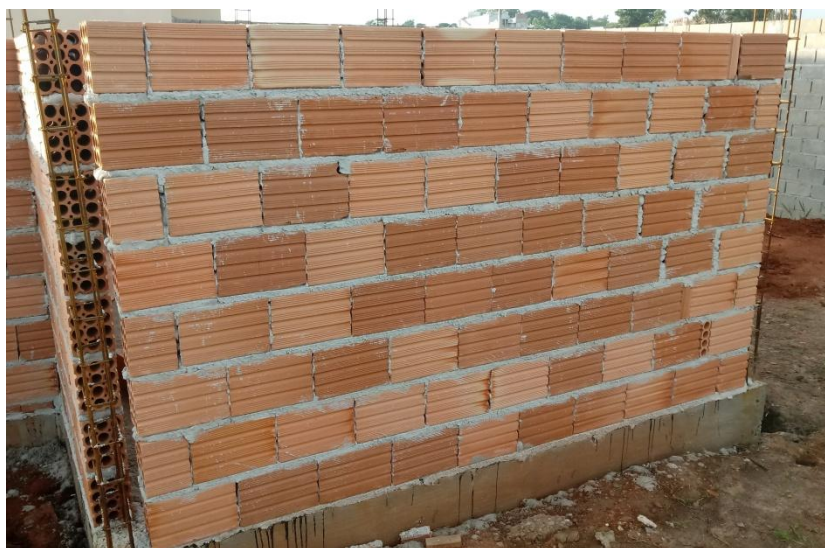
Figura 51 – Elevação da alvenaria
