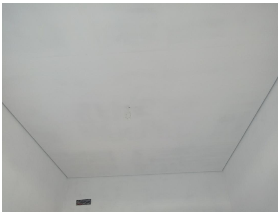
Figura 38 – Massa corrida nas placas de gesso
