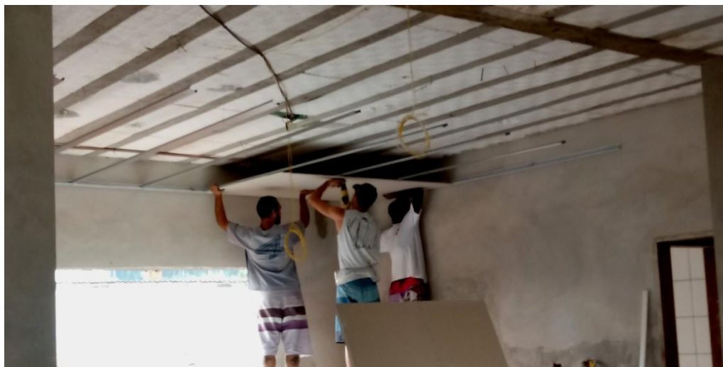
Figura 35 – Instalação da placa de gesso cartonado
