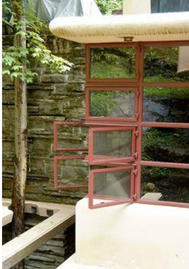
Imagem 7- Esquadria da Residência.
