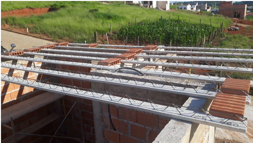
Figura 80 - Laje com enchimento
