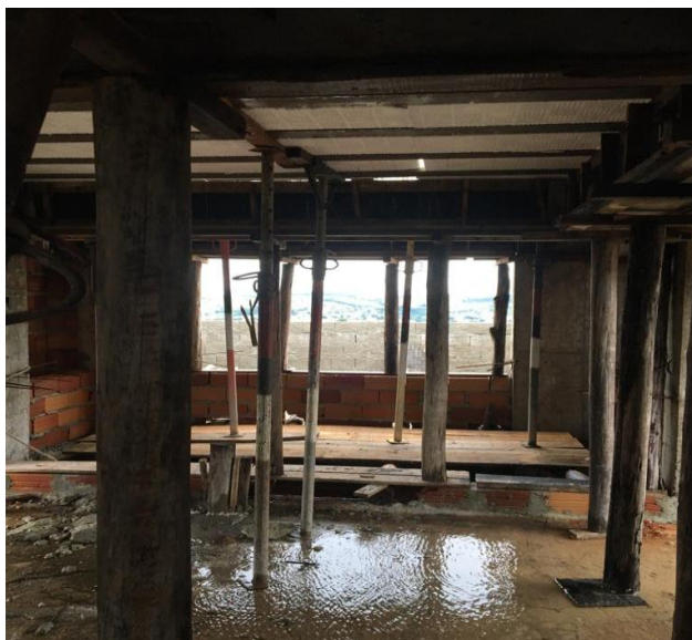
Figura 121 - Laje com escoramentos metálicos e de madeira
