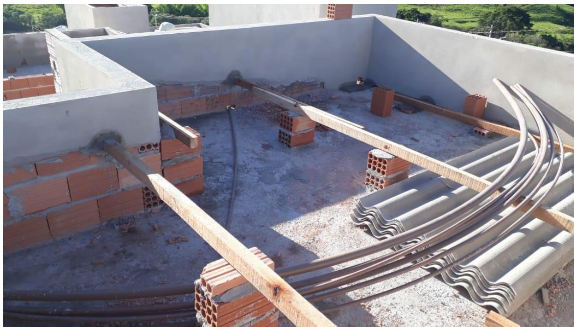
Figura 84 - Estrutura do telhado
