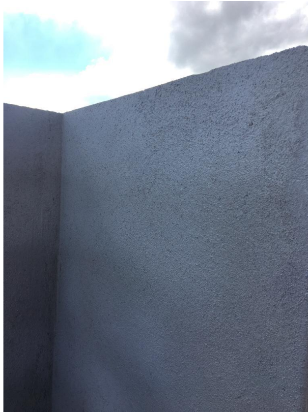
Figura 131 - Parede com reboco finalizado
