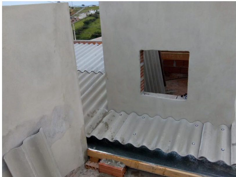
Figura 88 - Fixação de calha
