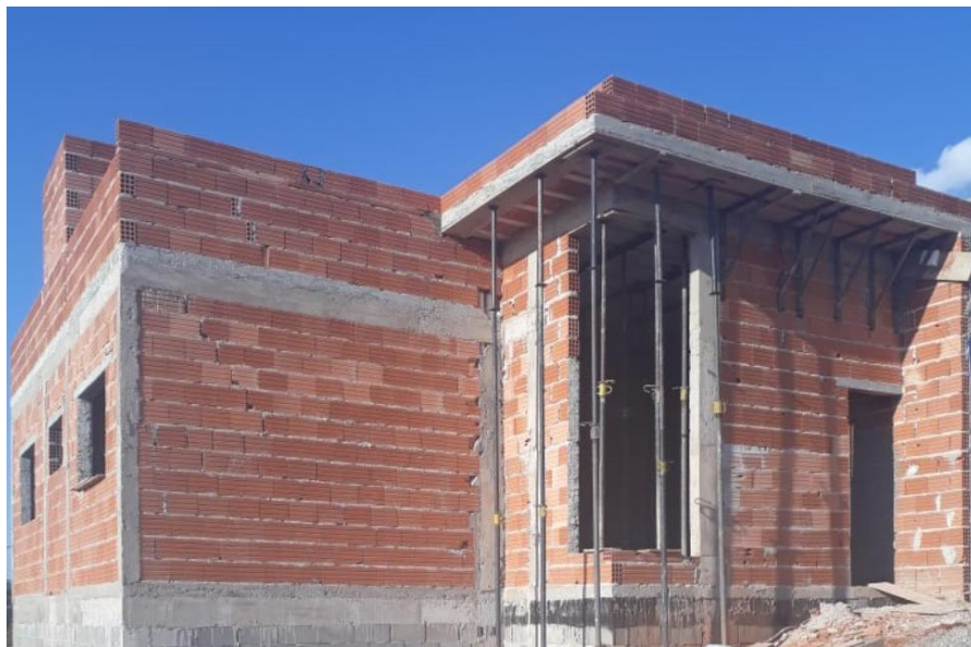
Figura 76 - Vergas na alvenaria
