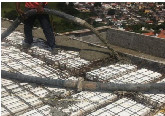
Figura 122 - Laje sendo concretada
