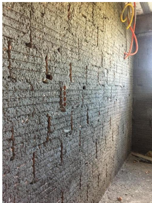
Figura 128 - Parede chapiscada
