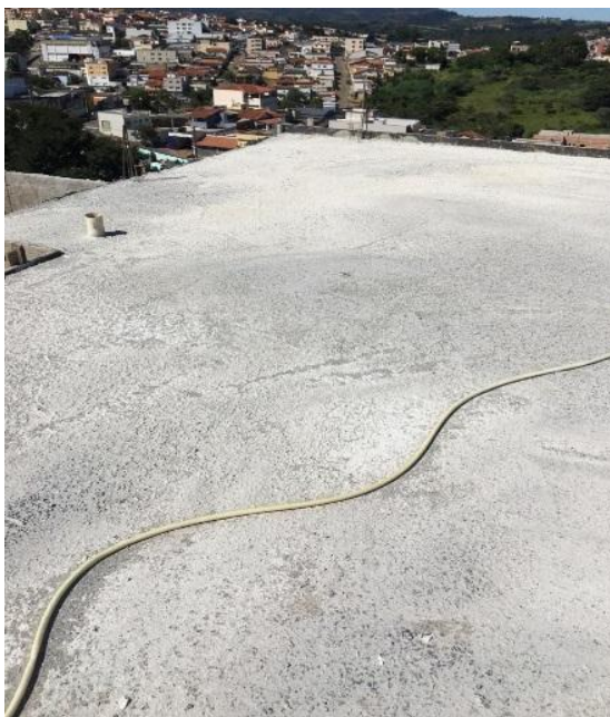
Figura 124 – Laje concretada
