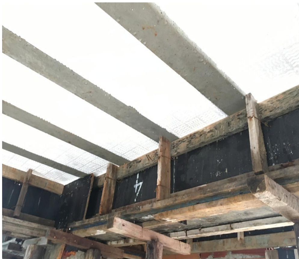
Figura 118 - Vigotas, isopor (EPS) e formas de vigas
