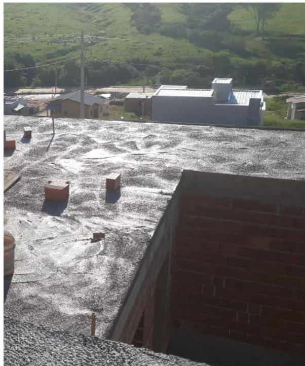
Figura 83 - Laje concretada
