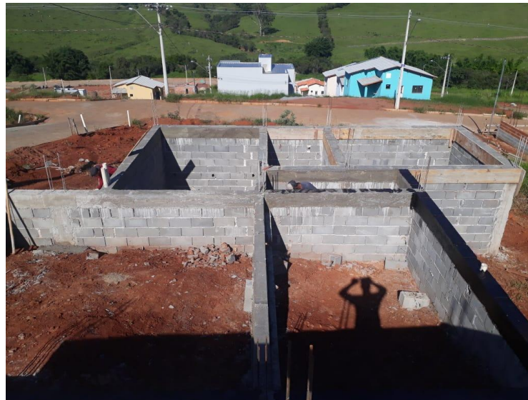
Figura 70 - Estrutura de regularização
