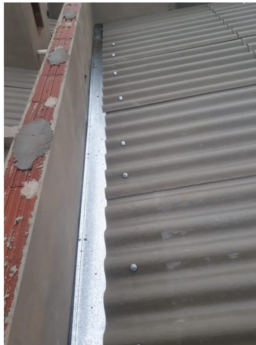
Figura 89 - Calha e telhado
