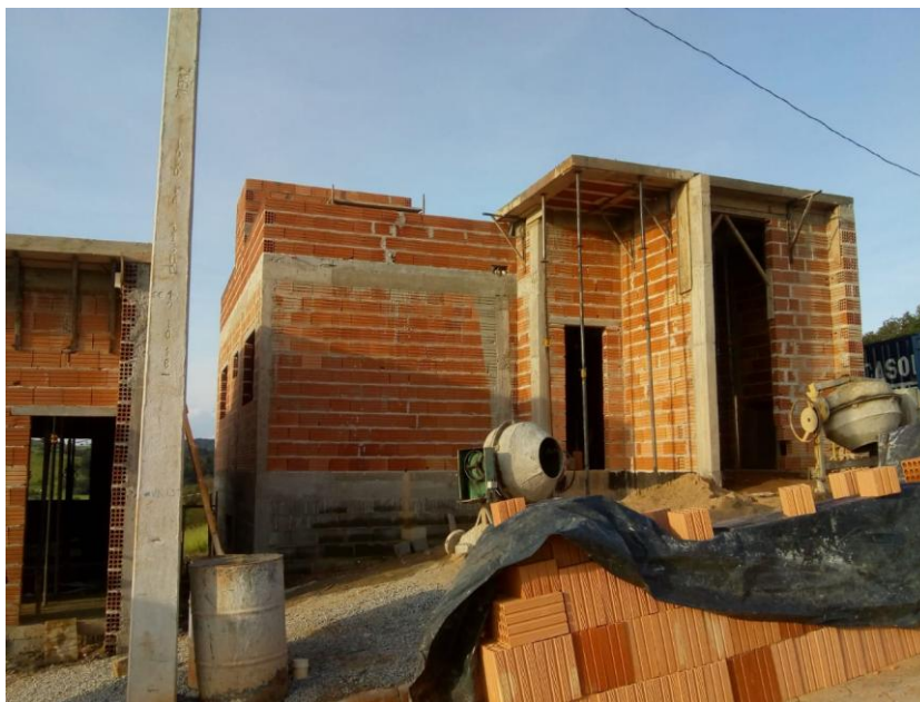
Figura 81 - Escoramento da laje na fachada
