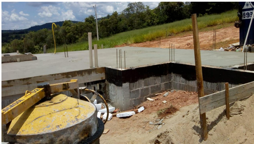
Figura 72 - Regularização da casa superior
