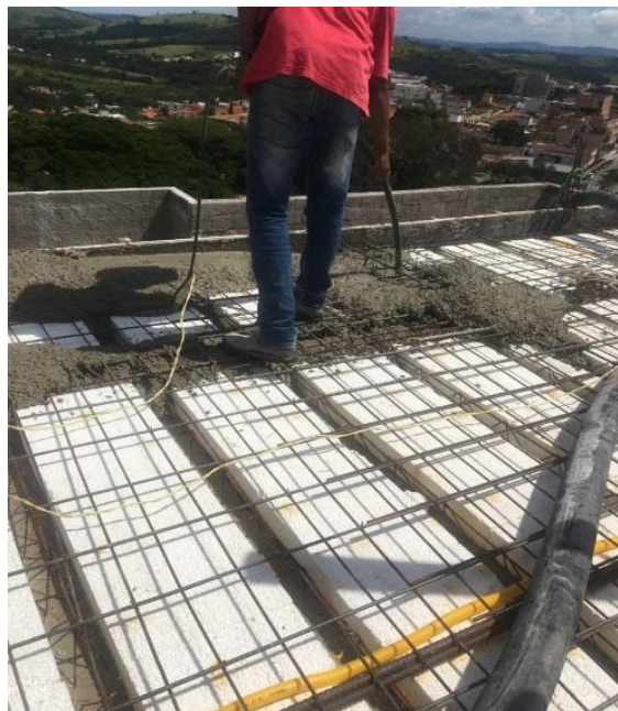
Figura 123 - Vibrador por imersão
