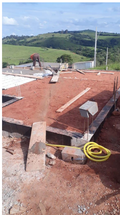
Figura 71 - Estrutura de regularização
