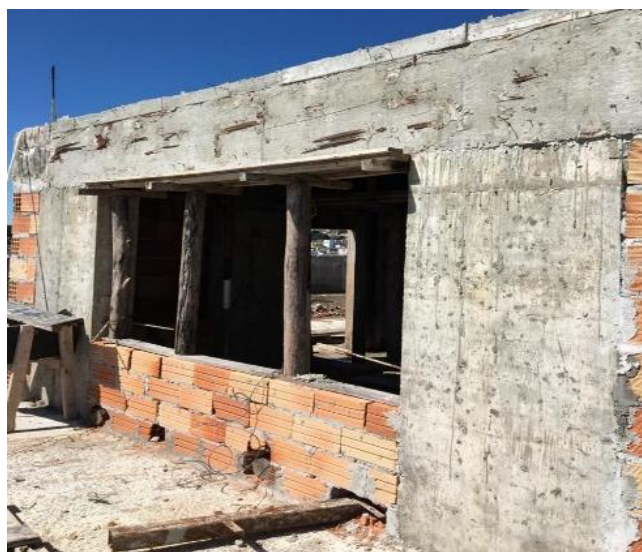
Figura 125 - Viga e laje desenformada
