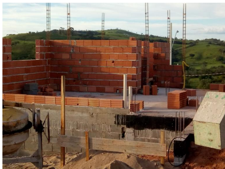
Figura 75 - Execução de alvenaria
