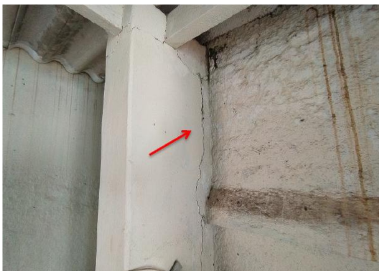
Figura 50 - Trincas
