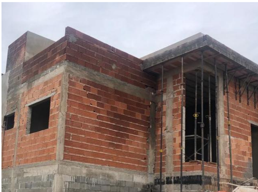
Figura 82 - Escoramento da laje na fachada
