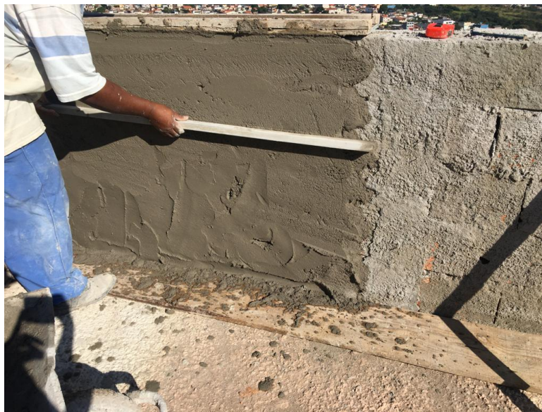
Figura 130 - Parede sendo realizado o reboco
