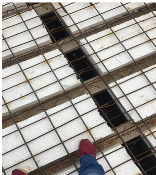
Figura 120 - EPS posicionados
