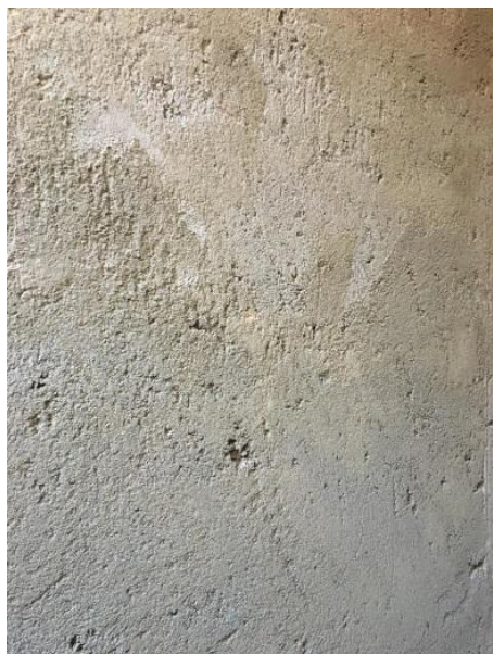
Figura 129 - Parede com etapa emboço finalizada
