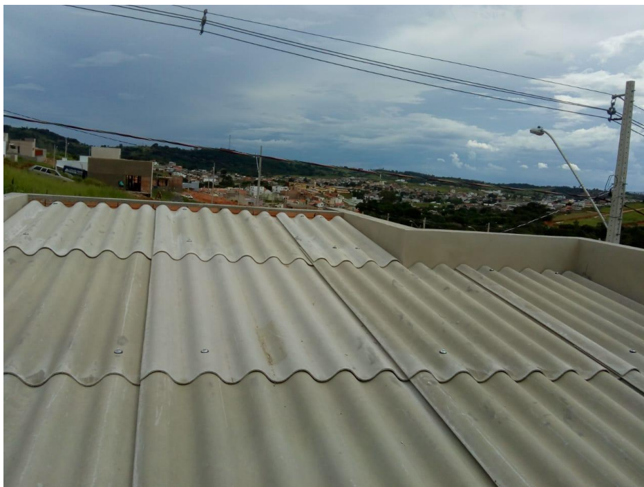
Figura 87 - Telhas fixadas
