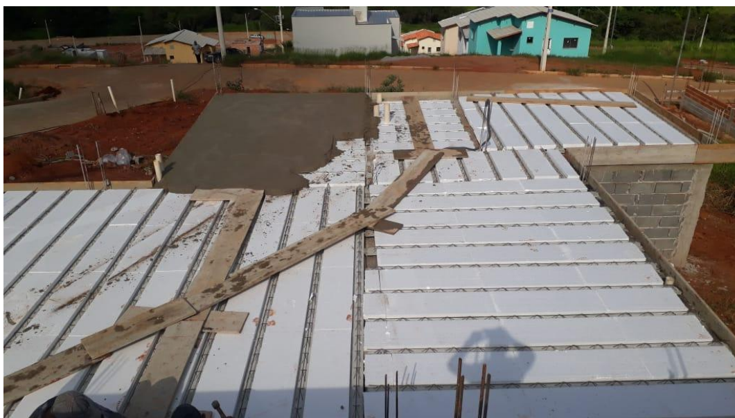
Figura 73 - Concretagem da laje da casa inferior
