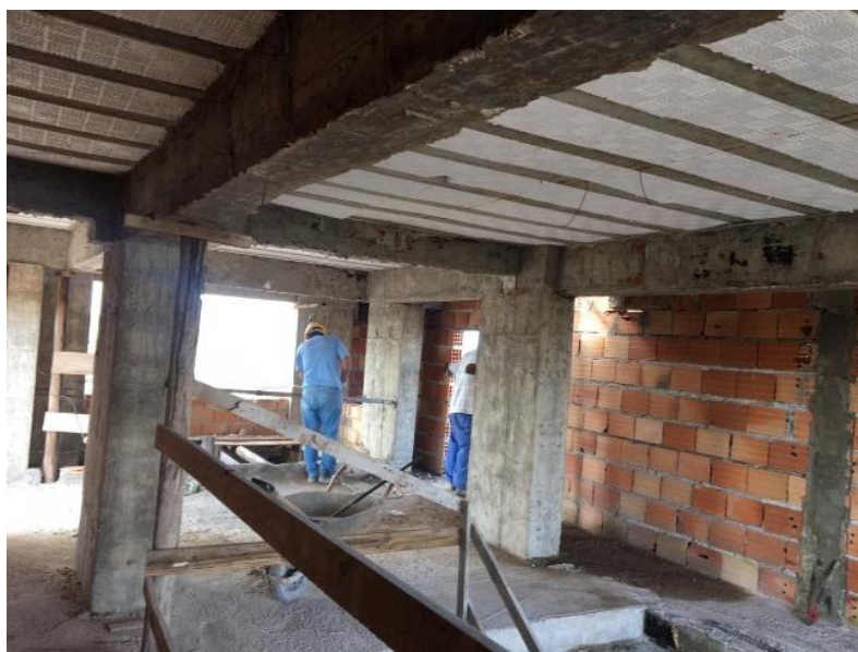
Figura 126 – Laje com escoramento retirado
