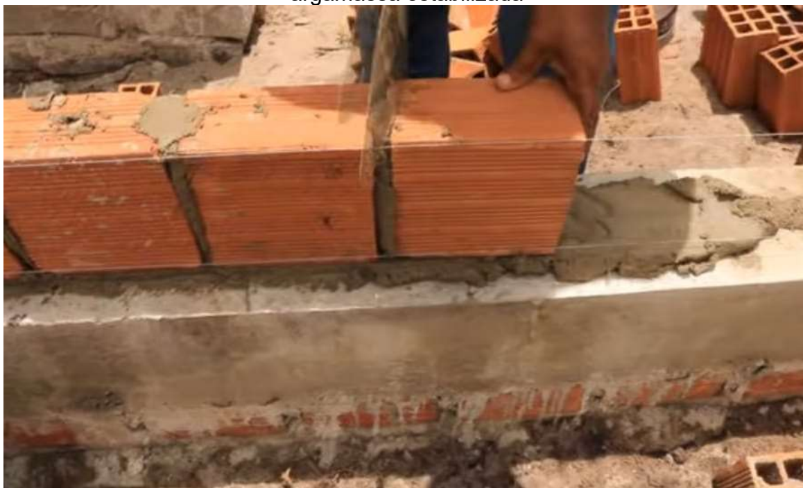
Figura 18 - Parte do relatório com fotografia do assentamento de tijolos feito com a argamassa estabilizada
