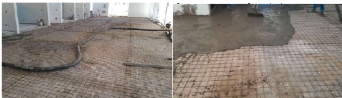
Figura 11 - Parte do relatório com fotografia da aplicação do concreto.
