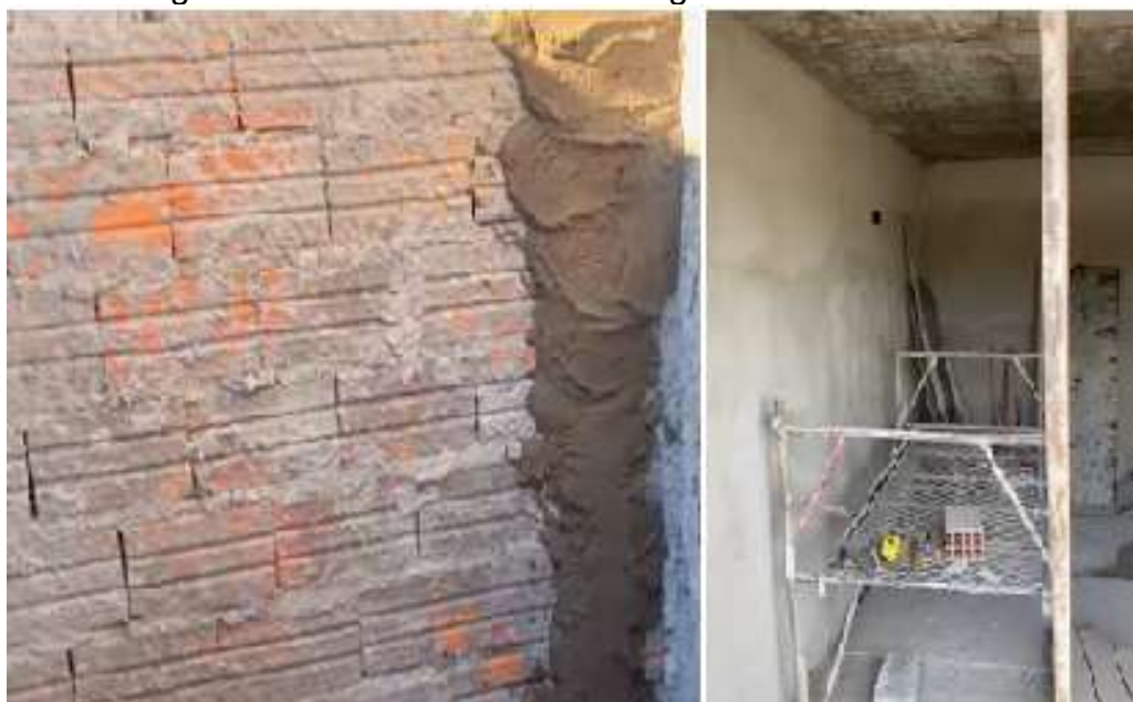
Figura 17 - Reboco feito com a argamassa estabilizada
