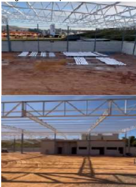
Figura 10 - Galpão a ser concretado
