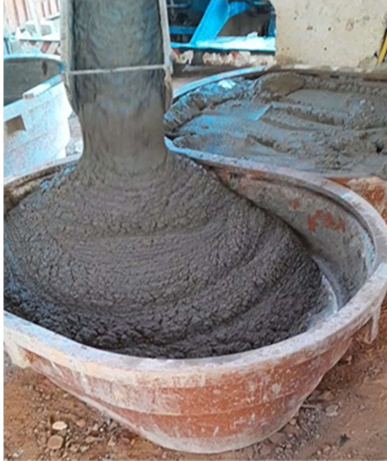
Figura 16 - Armazenamento da argamassa estabilizada
