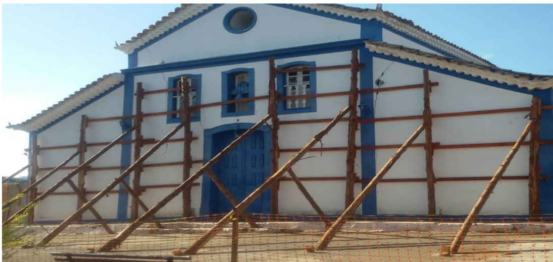
Figura 20 - Escoramento da Igreja Nossa Senhora do Rosário - Ibituruna – MG
