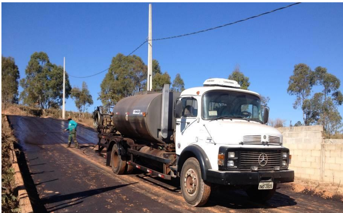
Figura 50 - Aplicação da pintura de ligação sobre a estrada vicinal do Rosário
