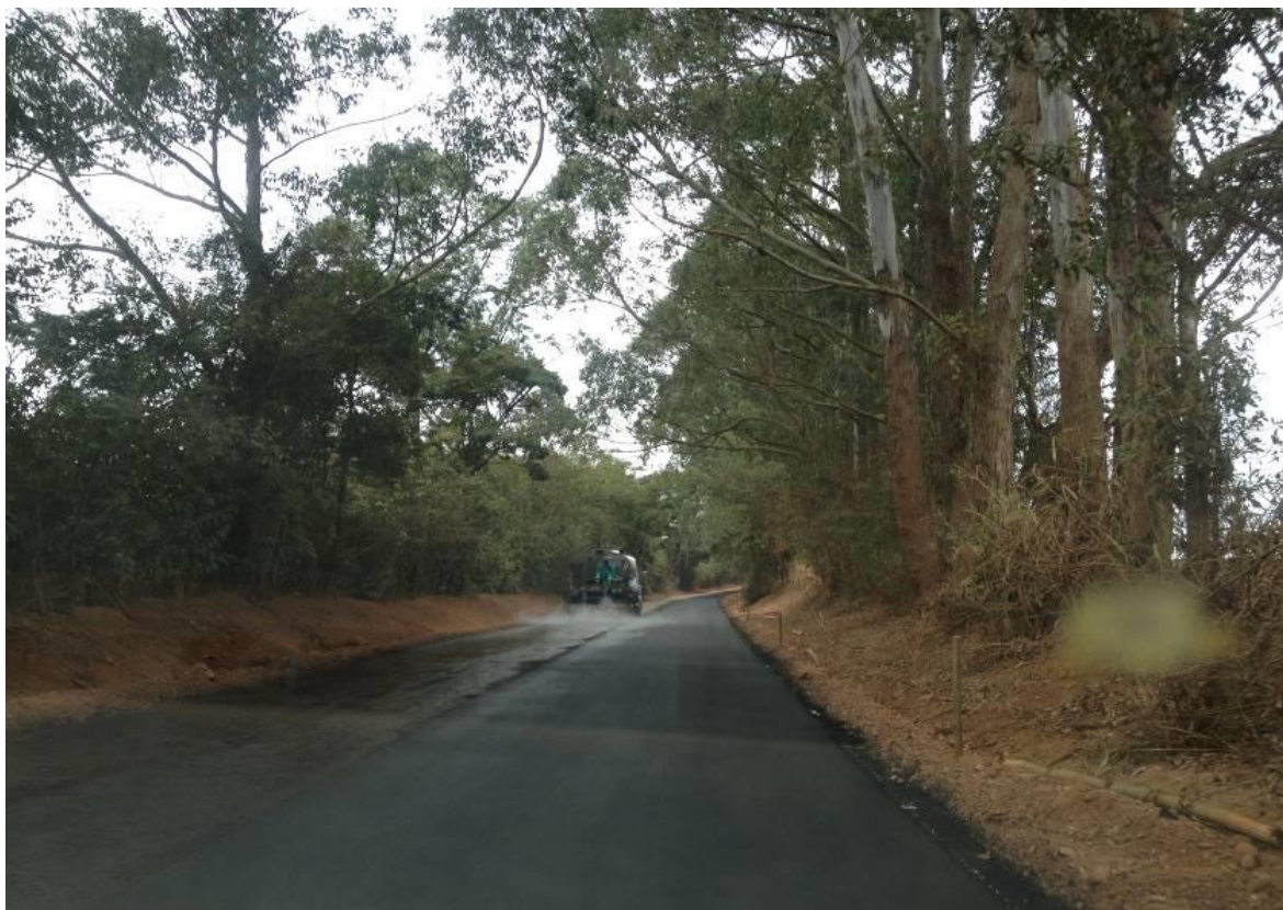
Figura 49 - Aplicação da pintura de ligação sobre a imprimação das vias urbanas
