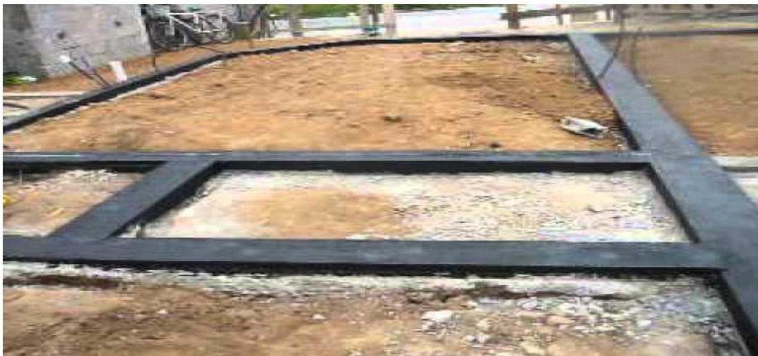
Figura 12 - Impermeabilização da viga baldrame
