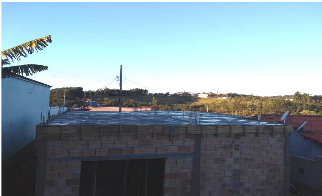
Figura 27 - Cura do concreto
