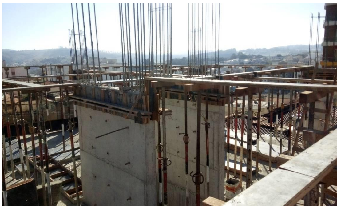
Figura 66 - Escoras Metálicas Verticais apoiando as vigas.
