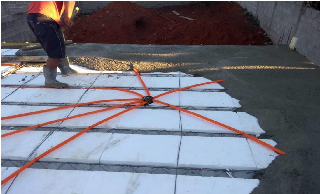
Figura 26 - Concretagem e regularização
