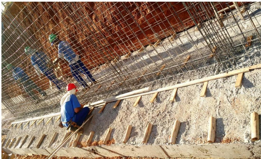
Figura 103 - Montagem da armação do muro
