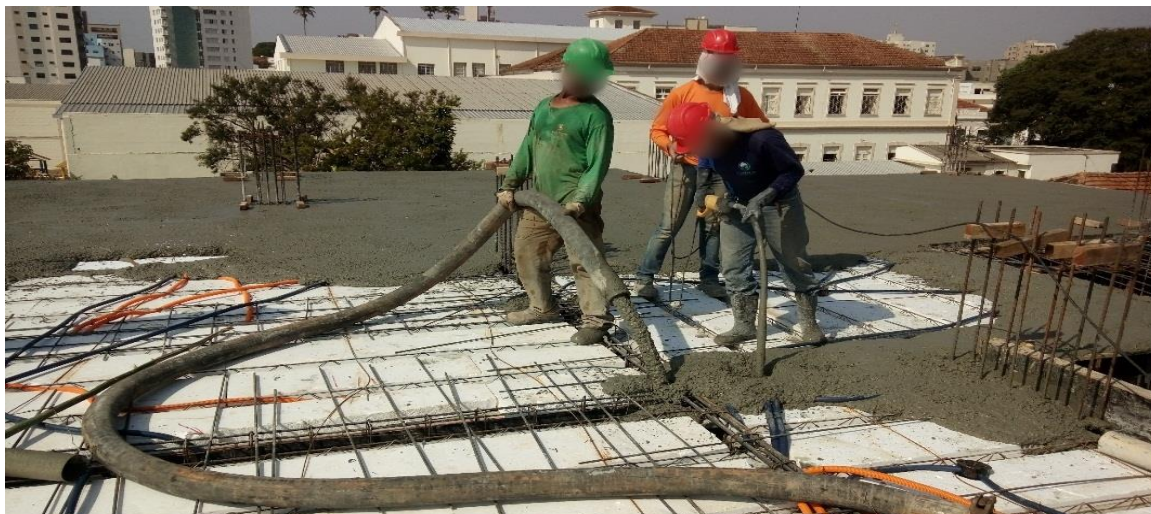
Figura 70 - Concretagem da laje pré – moldada
