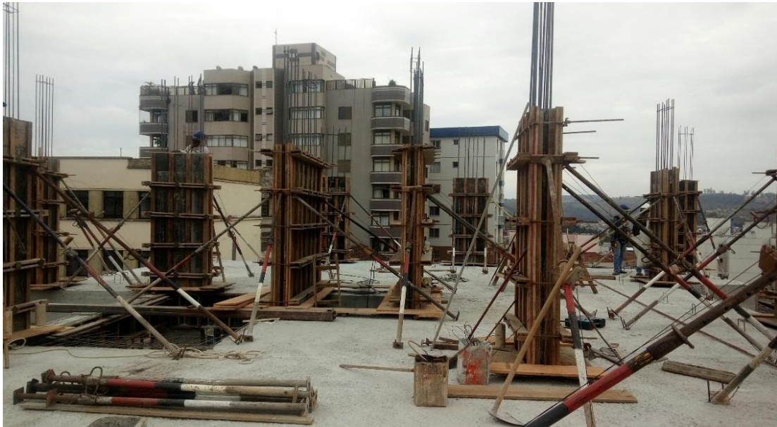
Figura 84 - Fôrmas prumadas e alinhadas á espera da concretagem
