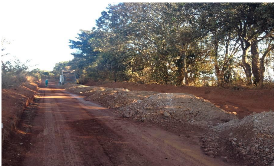
Figura 40 - Estocagem de cascalho para execução da base
