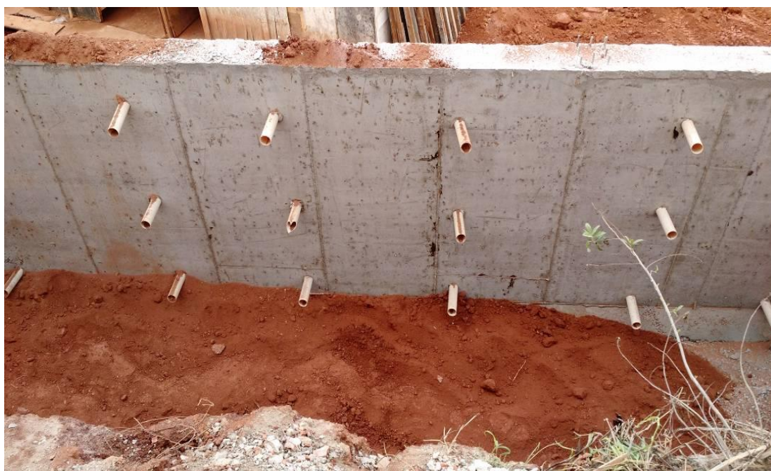
Figura 106 - Início do aterro do muro de arrimo com a tubulação de drenagem
