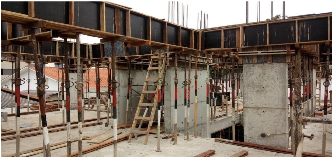
Figura 76 - Fôrmas fechadas á espera de agulhas e borboletas
