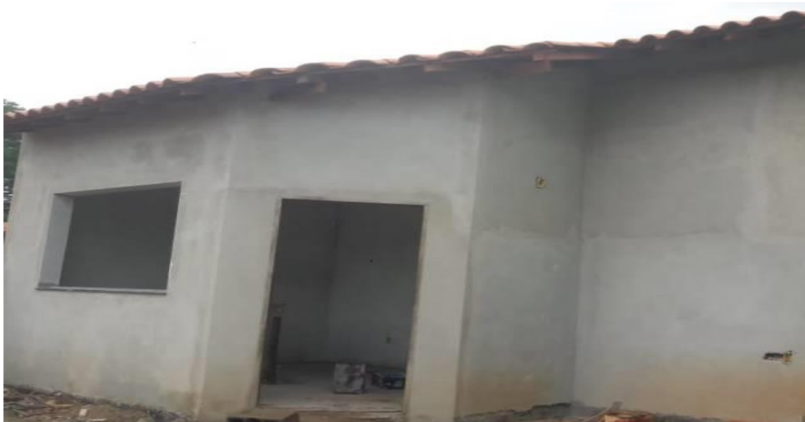
Figura 13 - Obra do estágio
