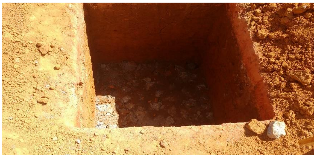
Figura 05 - Escavação de sapata isolada
