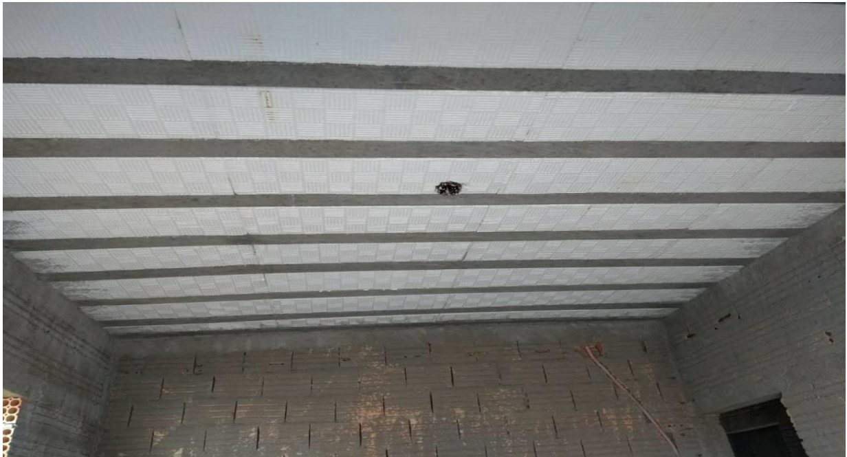
Figura 25 - Laje em EPS
