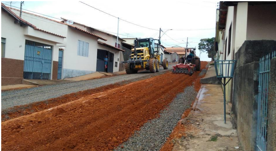
Figura 43 - Execução da base das vias urbanas
