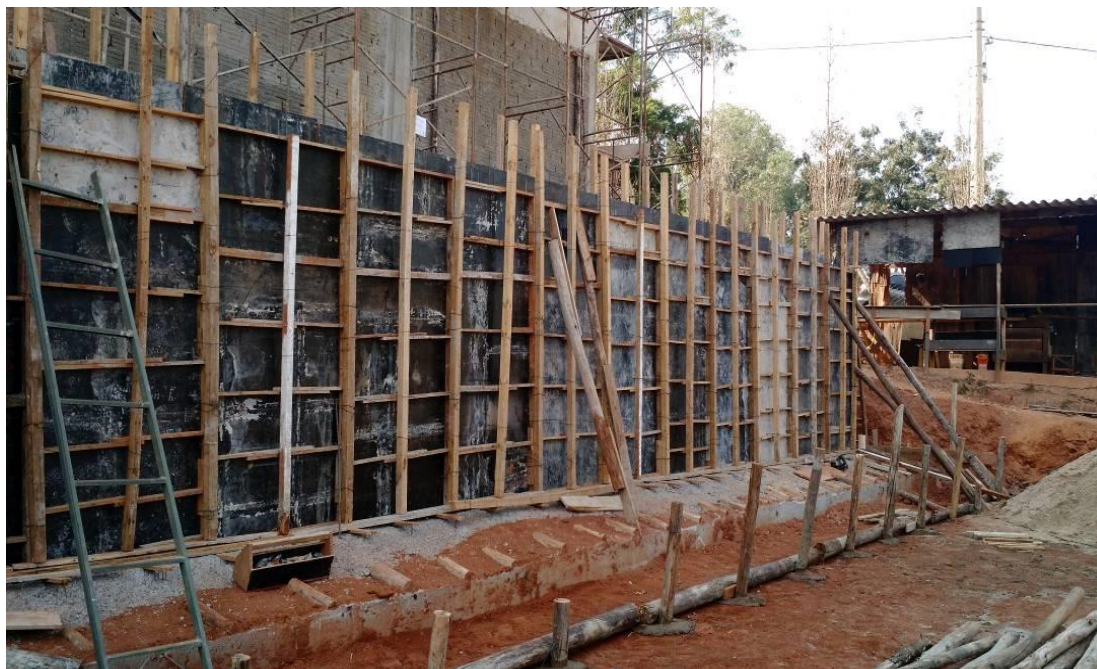
Figura 104 - Montagem de forma do muro
