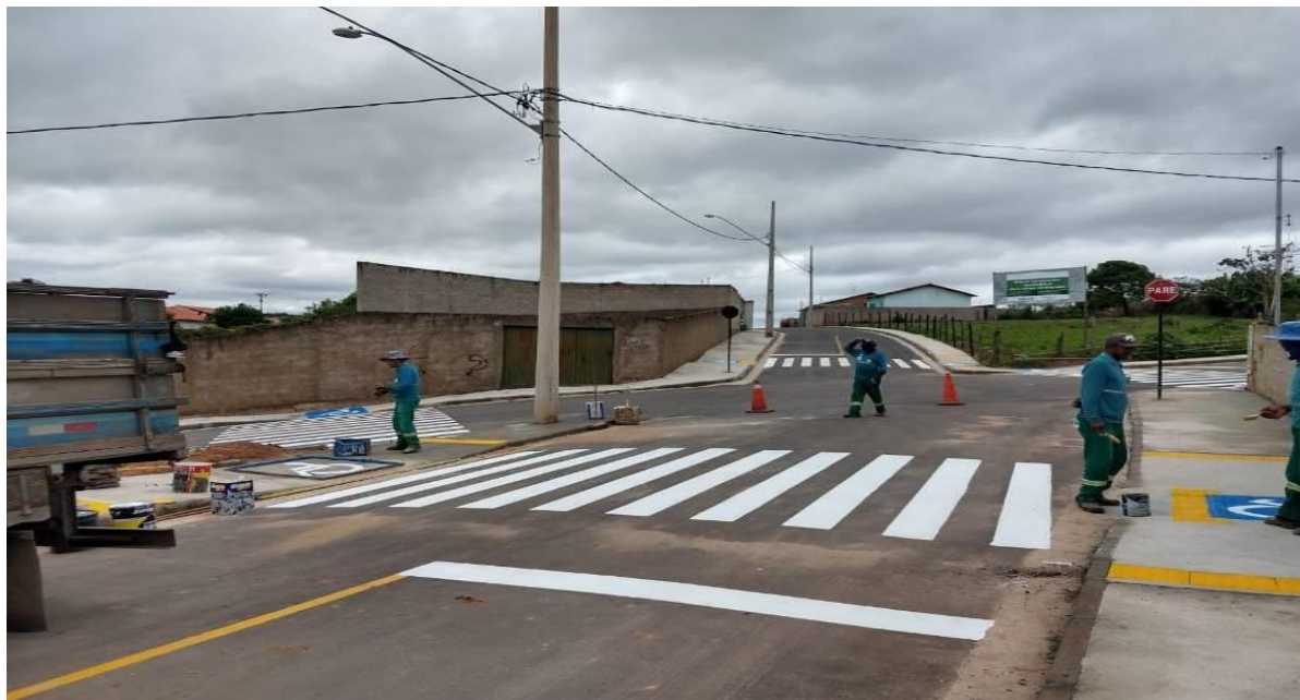
Figura 57 - Sinalização horizontal e vertical
