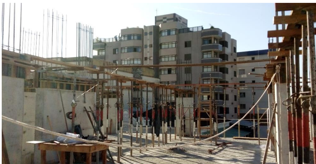
Figura 75 - Fundo de Vigas sendo posicionadas.
