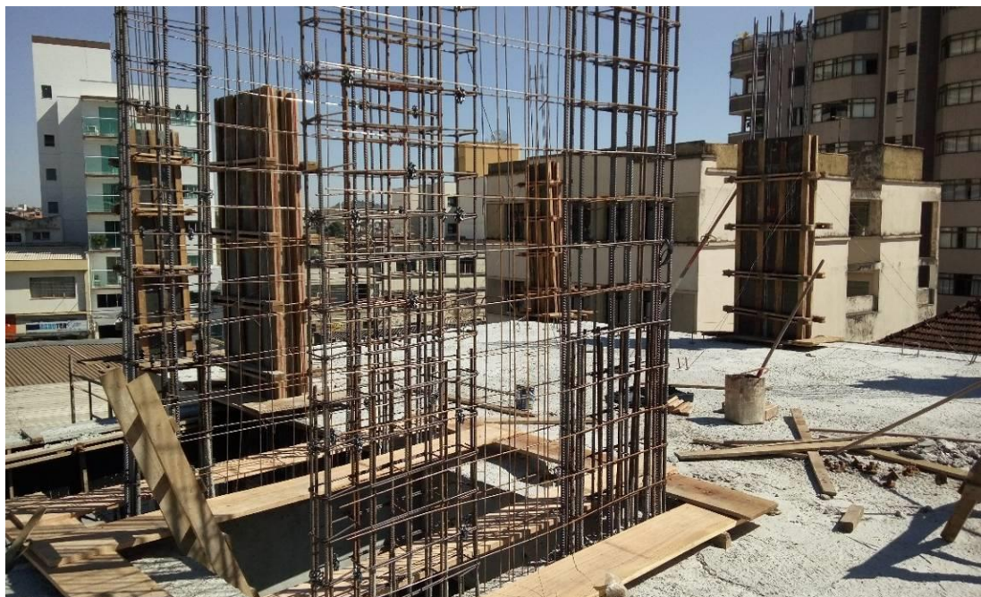
Figura 83 - Armação dos pilares.
