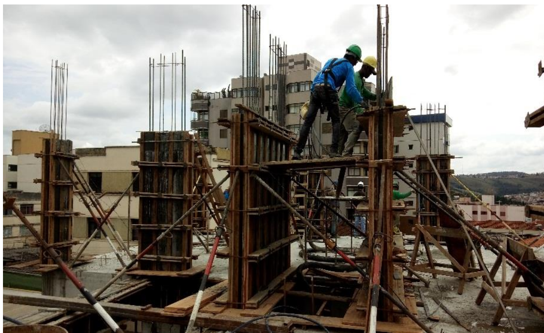
Figura 86 - Pilares concretados e desformados
