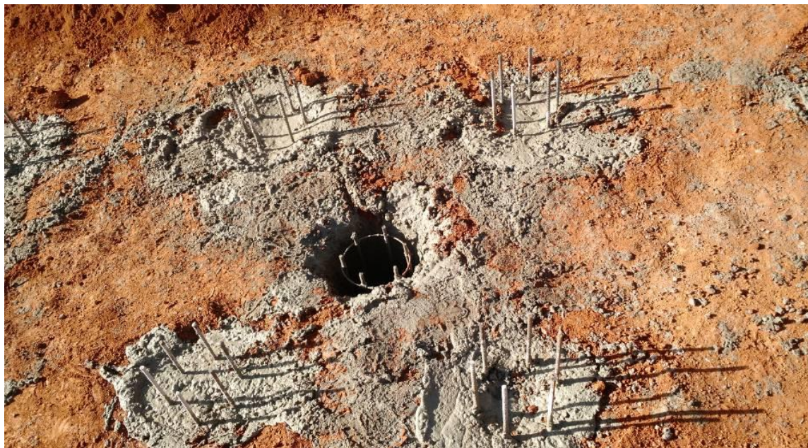
Figura 96 - Concretagem das estacas
