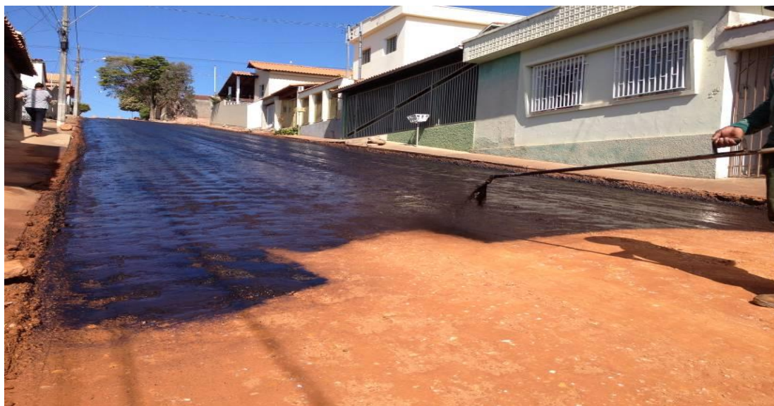
Figura 48 - Aplicação da imprimação sobre as vias urbanas
