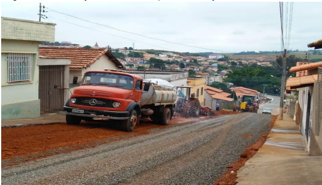
Figura 42 - Umectação dos materiais para a execução da base
