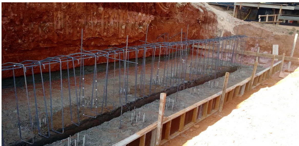
Figura 99 - Montagem da ferragem das cintas do muro
