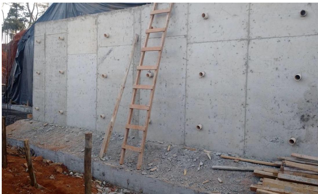
Figura 105 - Cortina de concreto muro de arrimo com tubos de drenagem
