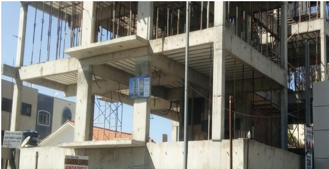
Figura 74 - Retirada dos escoramentos do primeiro pavimento residencial.
