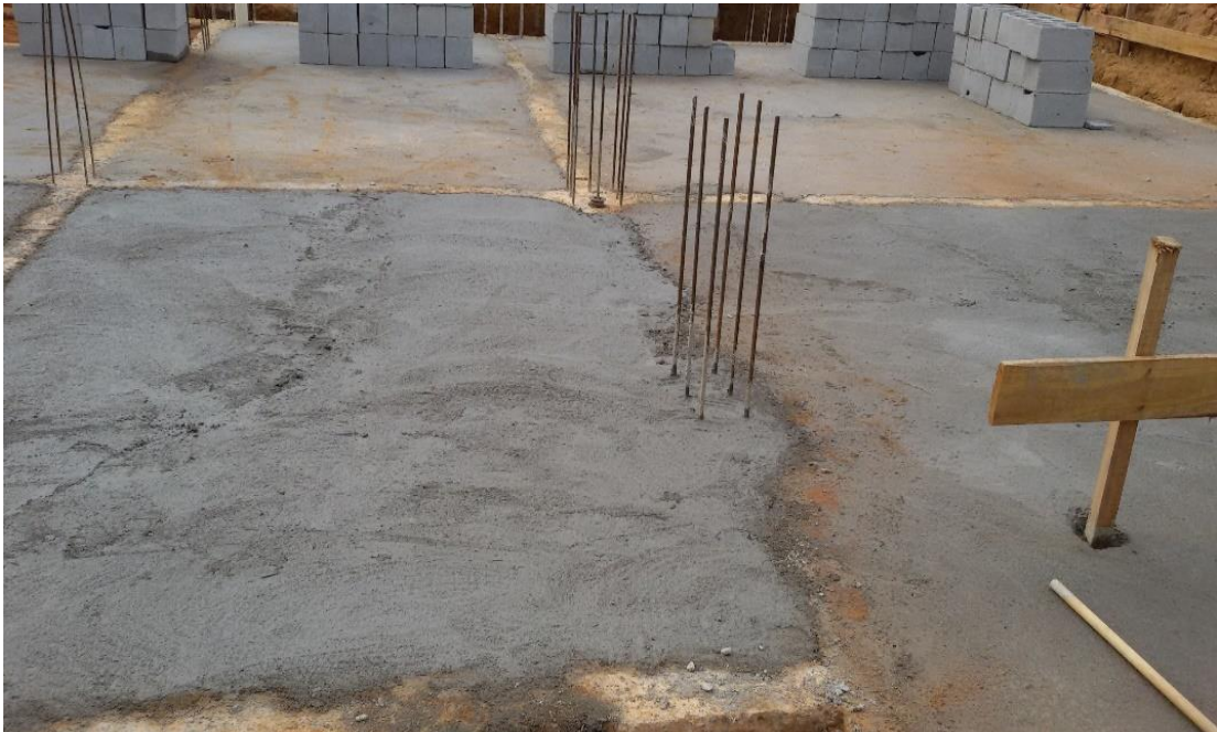
Figura 14 - Arranques dos pilares
