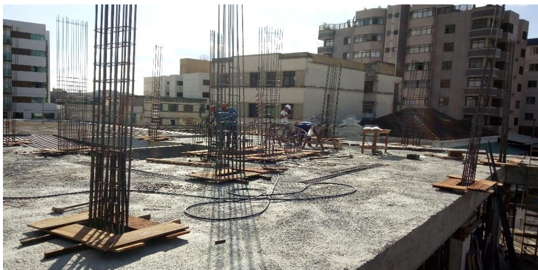
Figura 81 - Berços dos Pilares alinhados e prumados
