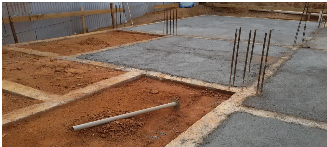
Figura 13 - Construção do contrapiso
