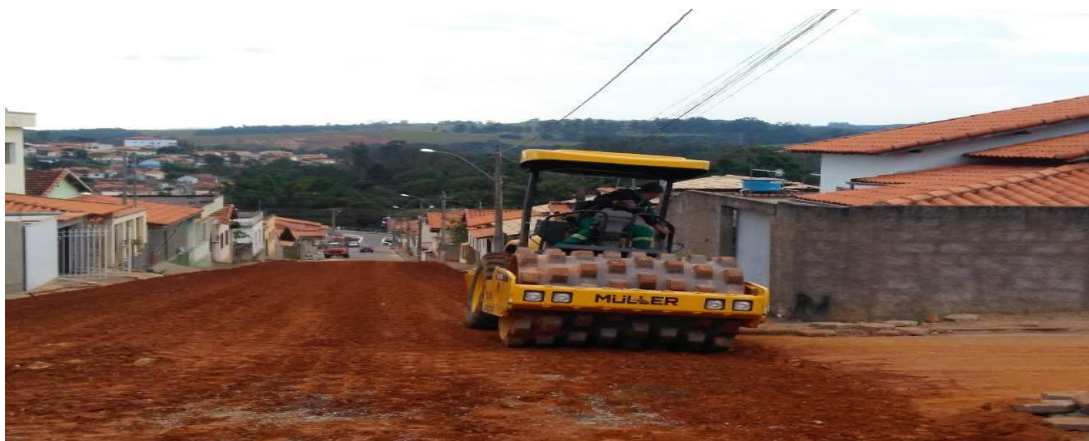
Figura 45 - Compactação da base das vias urbanas
