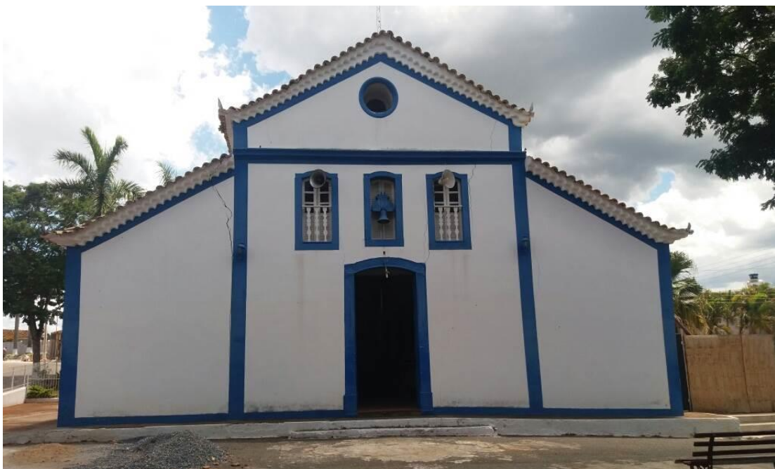
Figura 19 - Igreja Nossa Senhora do Rosário interditada - Ibituruna - MG
