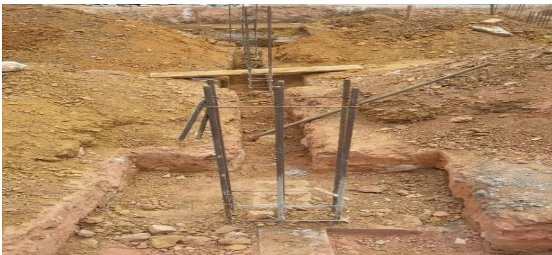
Figura 09 - Valas para viga baldrame
