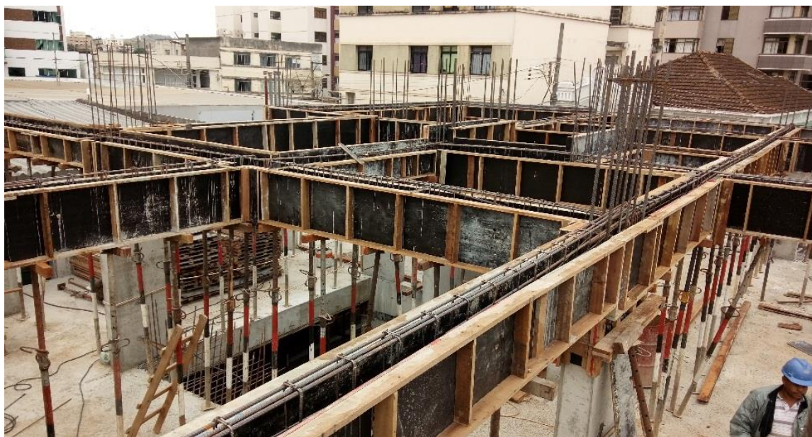
Figura 78 - Armaduras das vigas posicionadas nas fôrmas.
