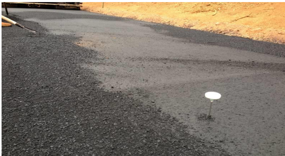
Figura 55 - Termômetro do CBUQ
