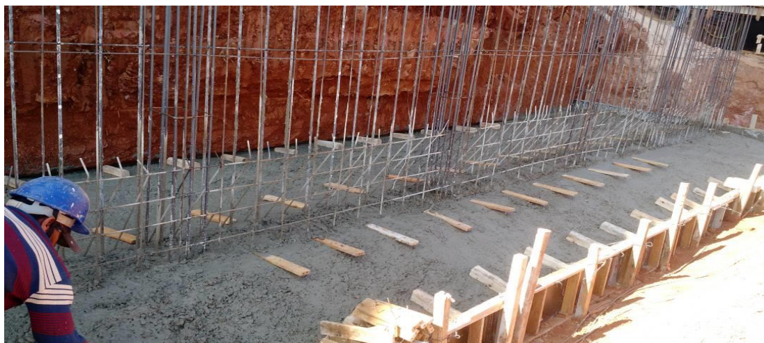
Figura 102 - Concretagem das cintas e sapata corrida
