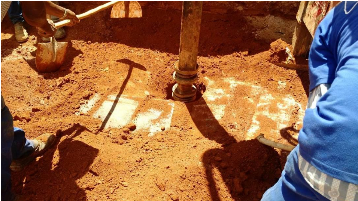
Figura 93 - Perfuração de estacas com caminhão Perfuratriz
