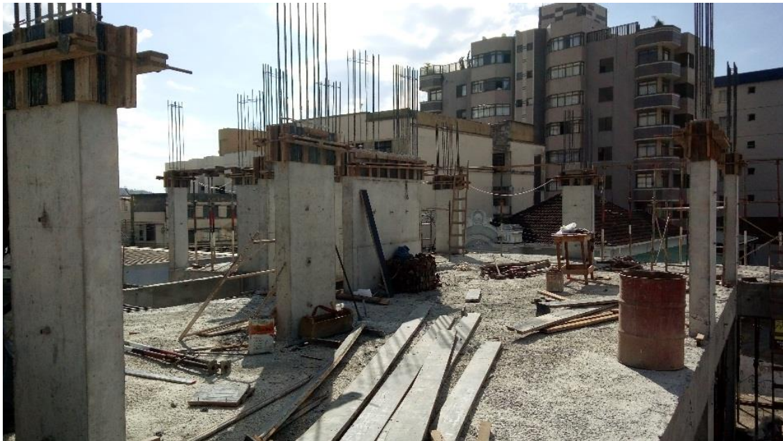
Figura 87 - Pilares concretados e desformados
