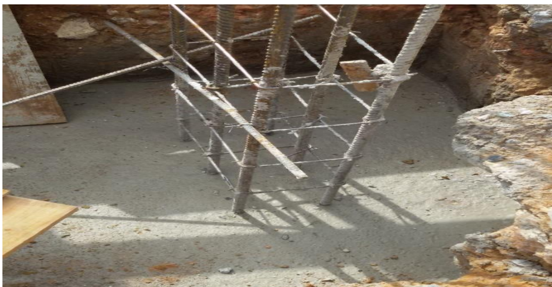
Figura 08 - Concretagem da sapata isolada
