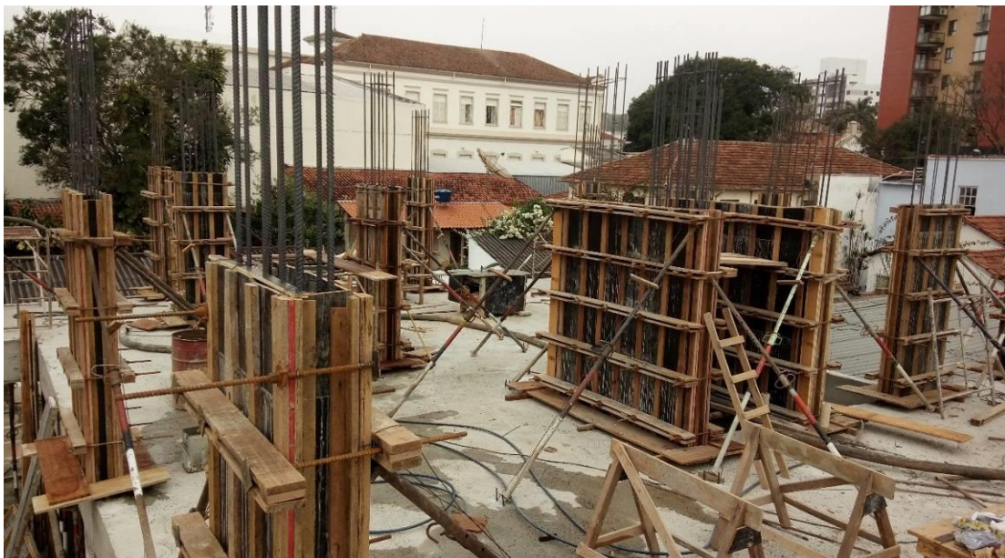
Figura 85 - Fôrmas prumadas e alinhadas á espera da concretagem.
