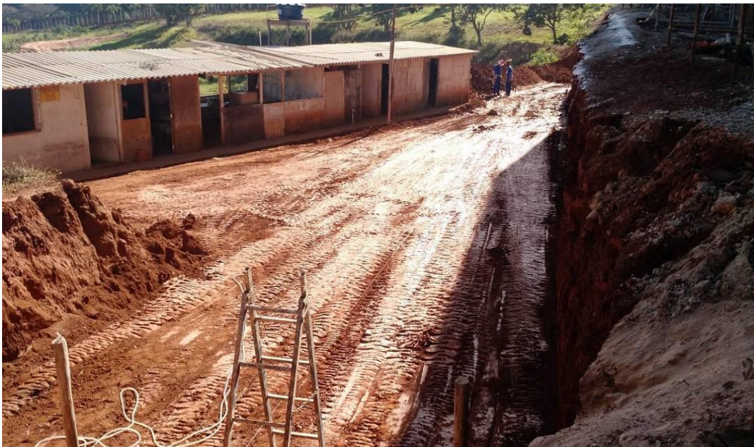
Figura 91 - Limpeza do terreno
