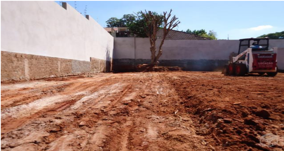
Figura 03 - Desaterro e aterro do terreno
