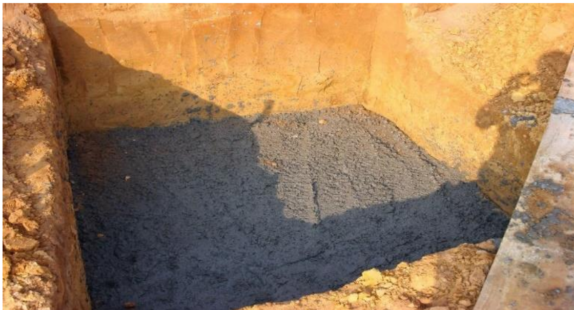
Figura 06 - Execução do lastro de concreto
