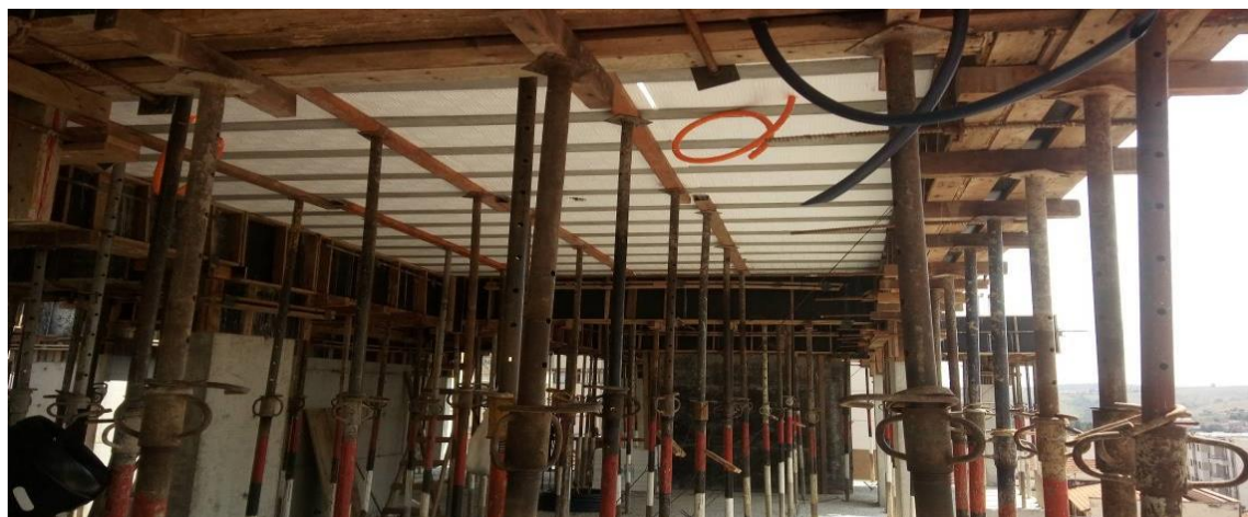
Figura 65 - Escoras Metálicas Verticais e Horizontais.
