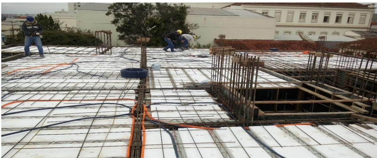
Figura 68 - EPS, Instalações Hidráulicas e Elétricas
