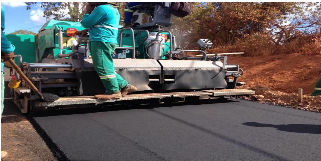
Figura 54 - Execução do CBUQ
