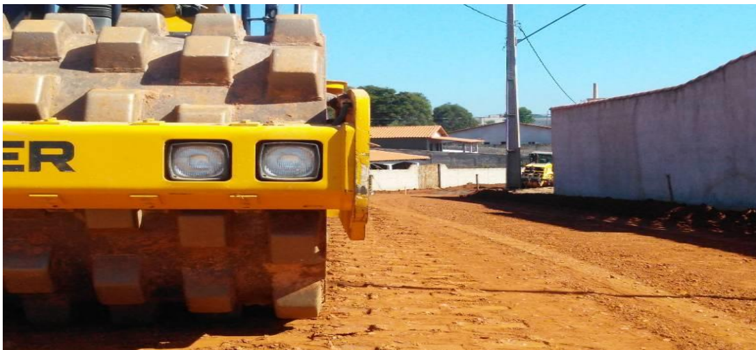
Figura 46 - Rolo compactador pé de carneiro
