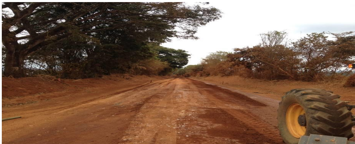
Figura 38 - Regularização do Subleito Estrada Vicinal do Rosário
