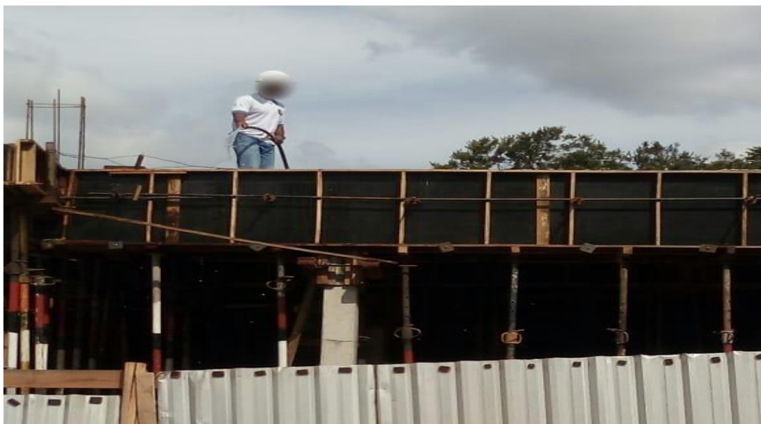
Figura 73 - Procedimento de cura do concreto na laje pré – moldada.
