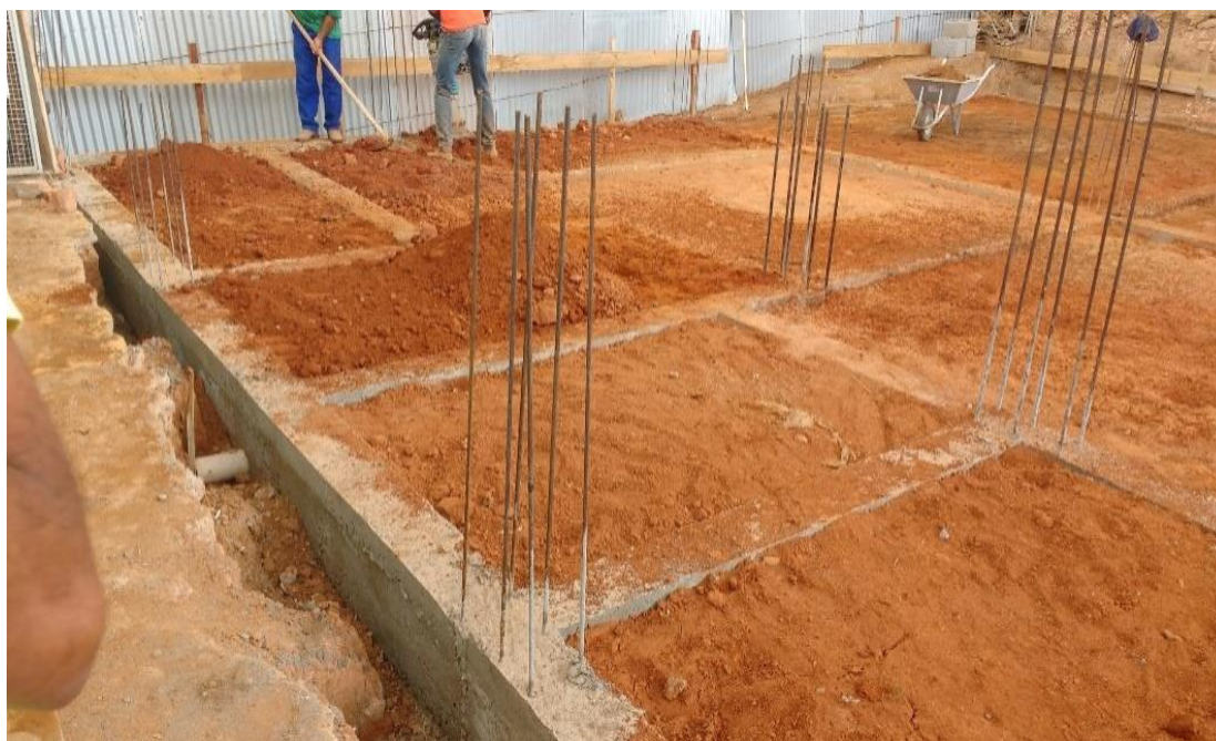
Figura 11 - Reaterro, e nivelamento do contrapiso.
