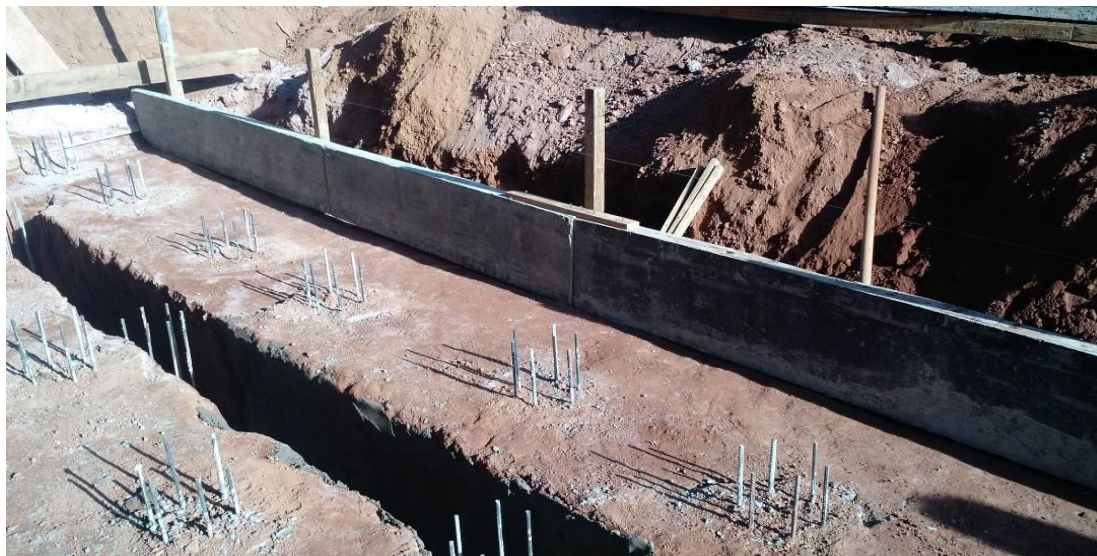
Figura 98 - Cintas escavadas e prontas para receber a ferragem
