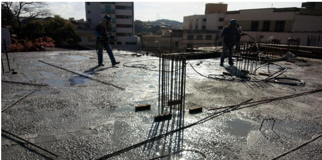
Figura 72 - Procedimento de cura do concreto na laje pré – moldada.
