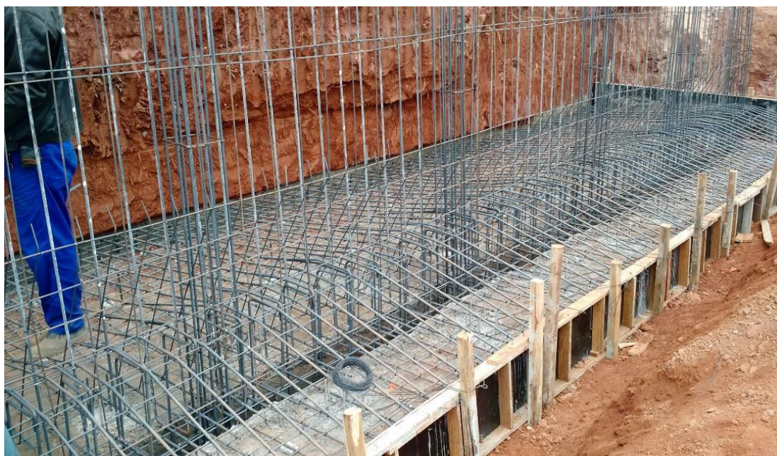
Figura 100 - Armação da cinta e sapata e muro
