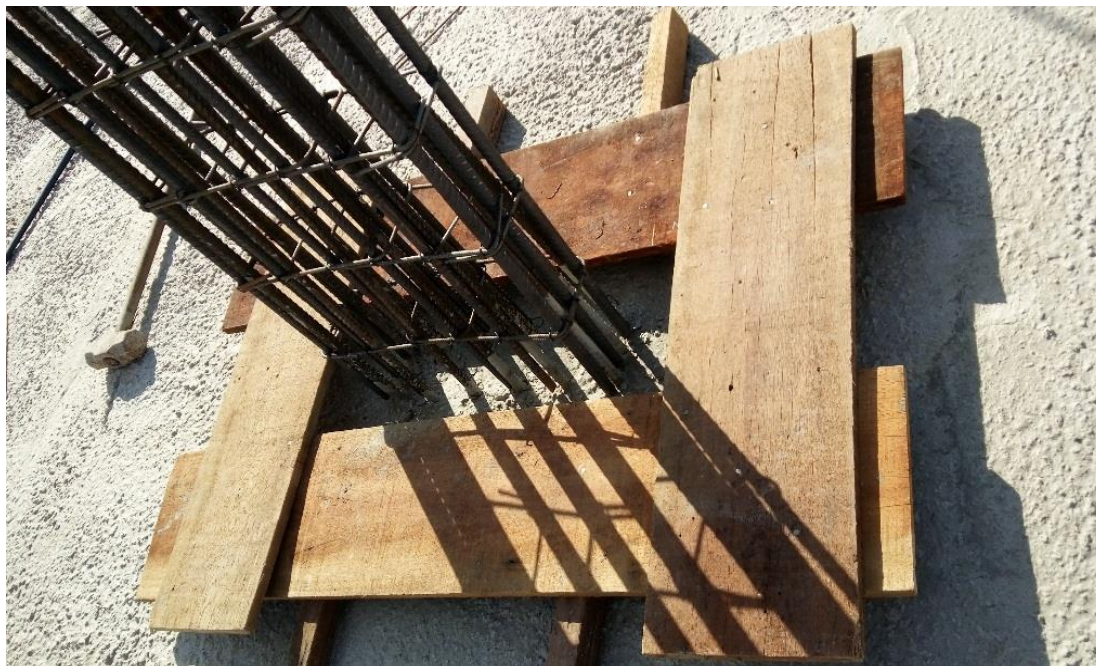
Figura 82 - Berços dos pilares alinhados e prumados
