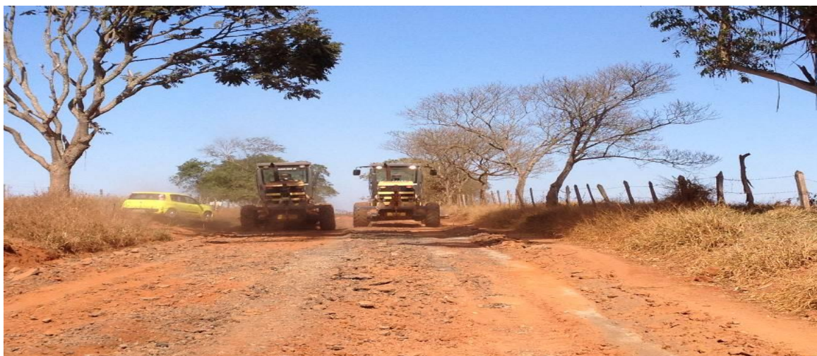
Figura 39 - Regularização do subleito e retirada do material
