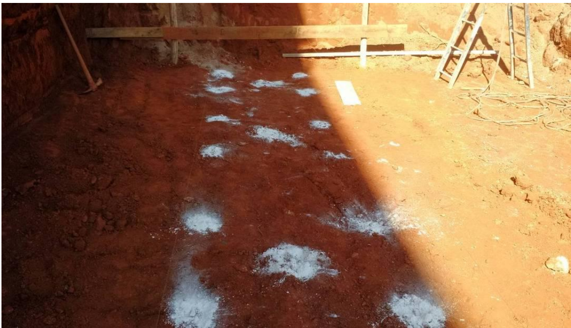
Figura 92 - Locação das estacas
