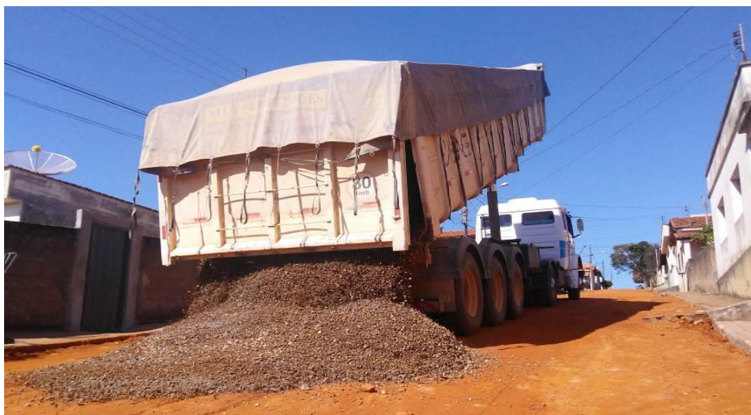
Figura 41 - Estocagem de brita para execução da base
