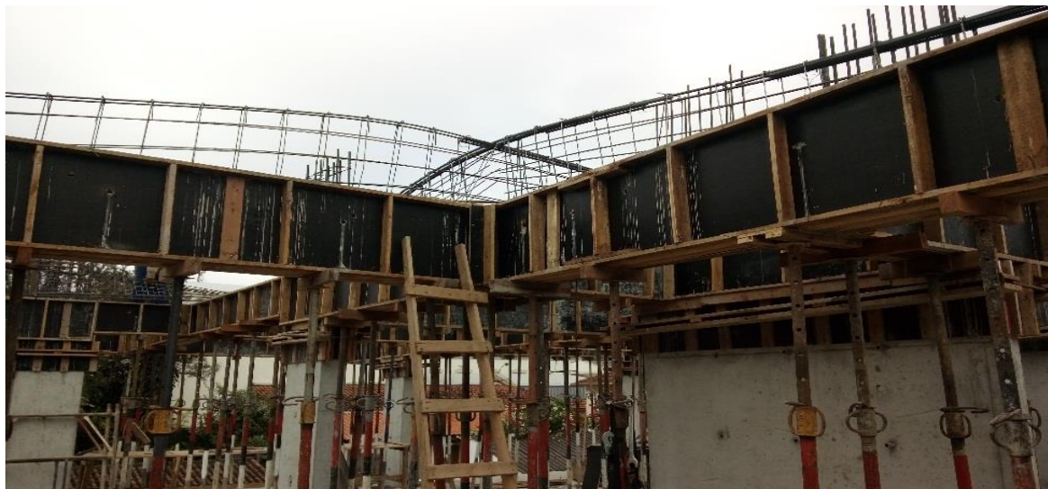
Figura 77 - Armaduras das vigas sendo posicionadas nas fôrmas.
