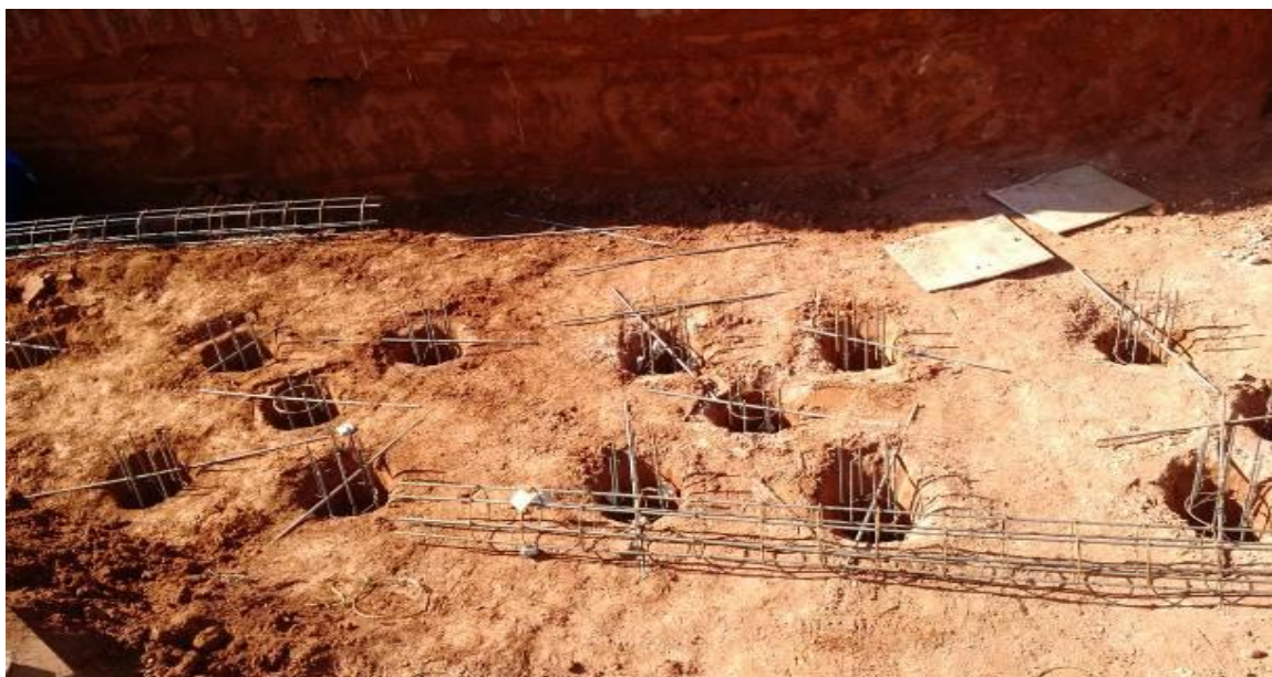
Figura 95 - Posicionamento das estacas para concretagem
