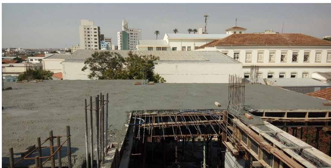
Figura 71 - Concretagem da laje pré – moldada
