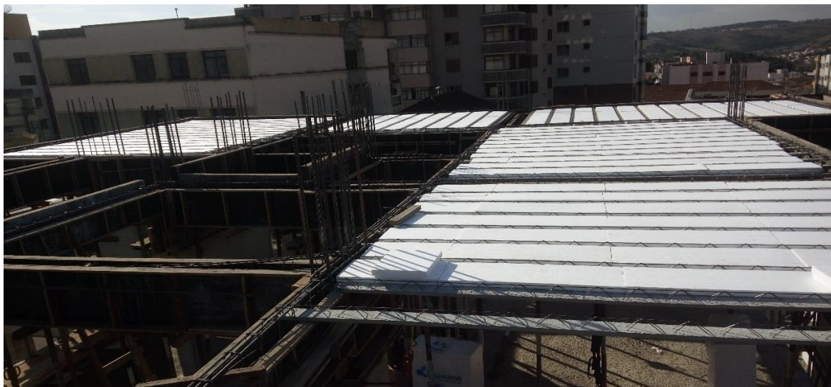
Figura 67 - Colocação de Vigotas Treliçadas.
