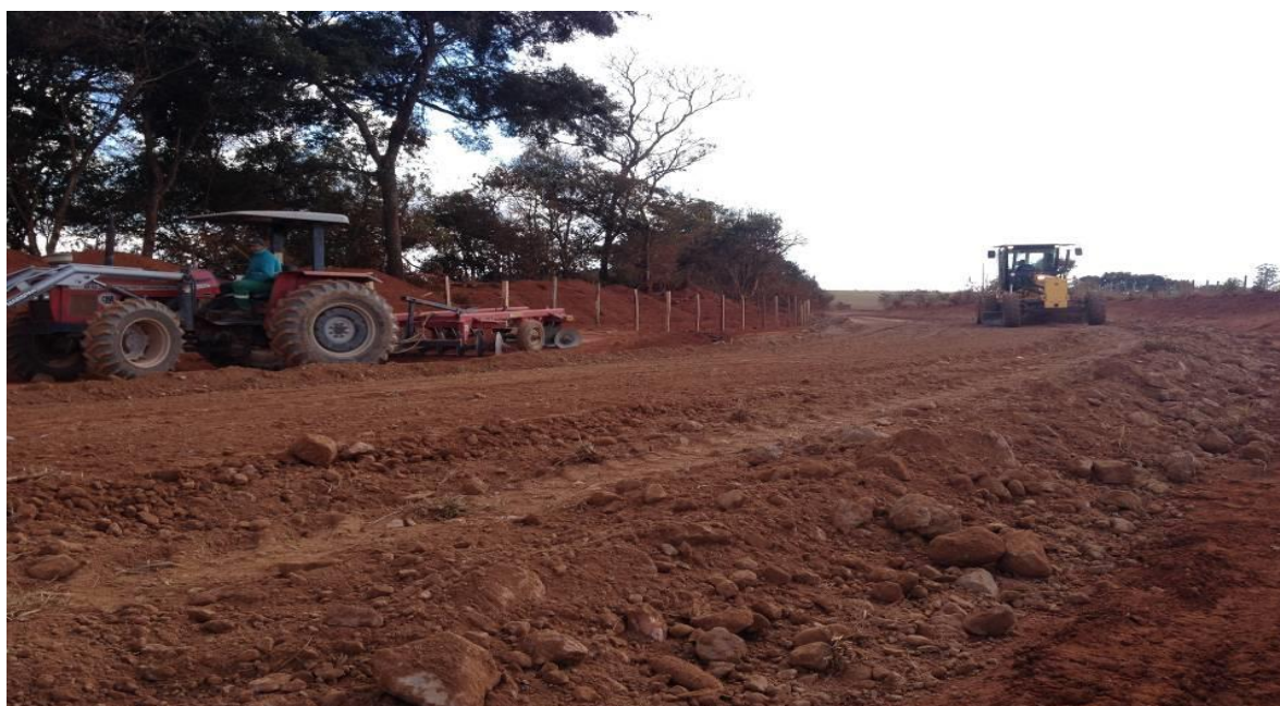
Figura 44 - Execução da base da estrada vicinal do Rosário
