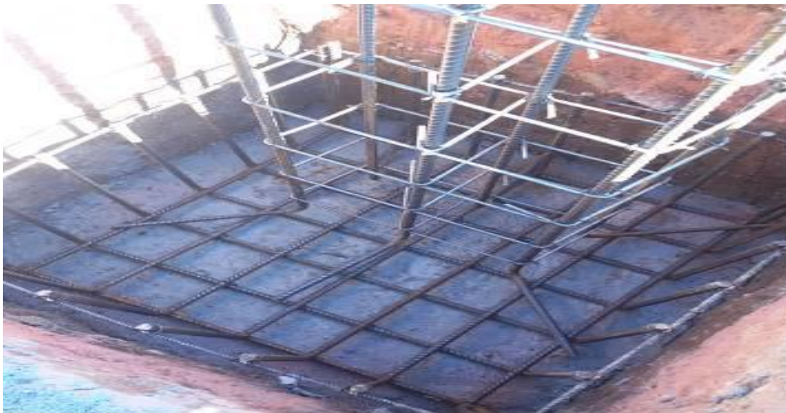
Figura 07 - Armaduras de aço
