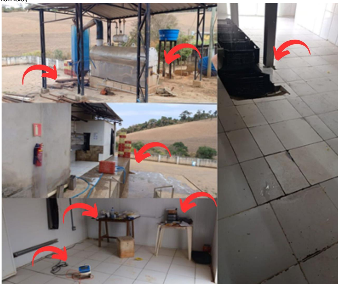
Figura 4: Ambiente sem higienização adequada, pontos críticos indicados pelas setas vermelhas,
