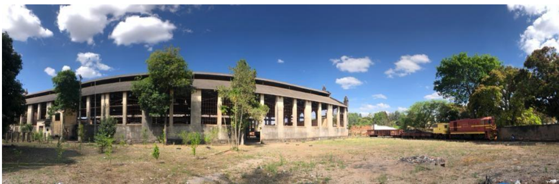
Imagem 26 – Galpões da Antiga Rede Ferroviária
