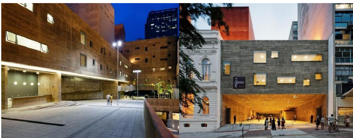
Imagem 18 – Travessa das Artes (parte aberta e fechada)
