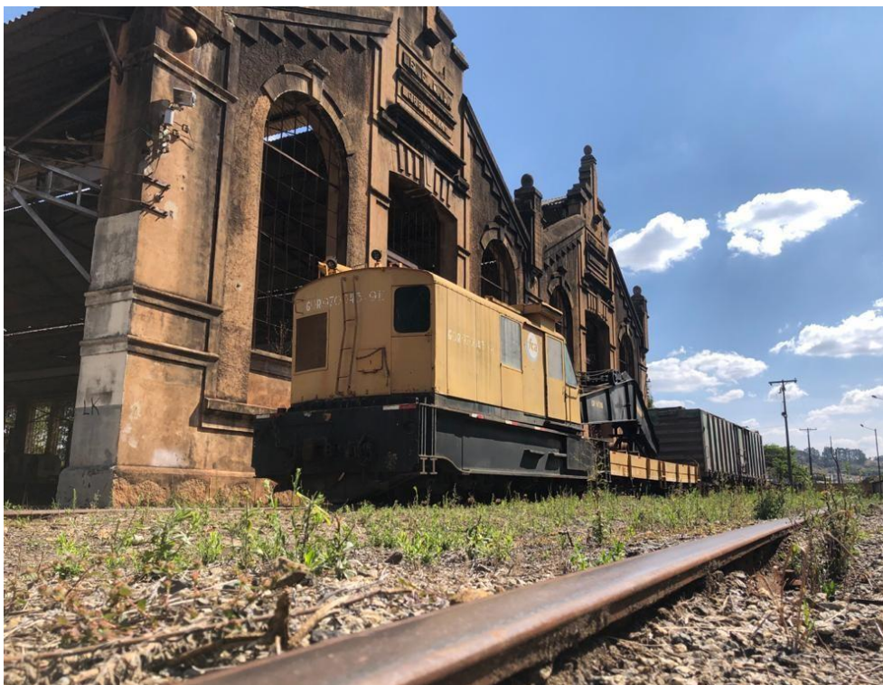
Imagem 7 – Galpões da Antiga Rede Ferroviária
