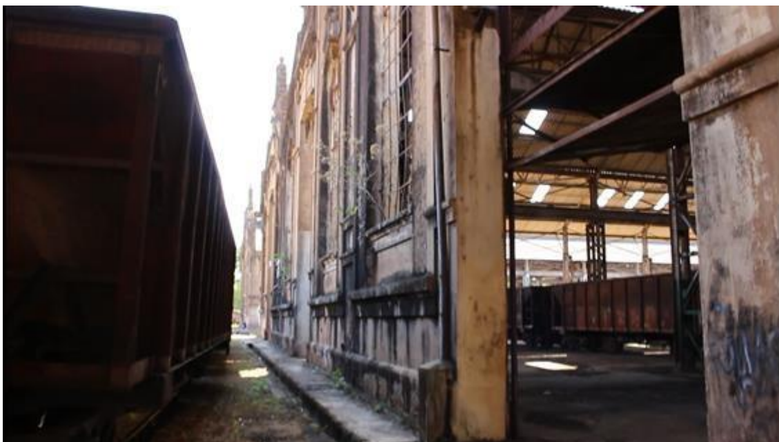
Imagem 27 – Galpões da Antiga Rede Ferroviária
