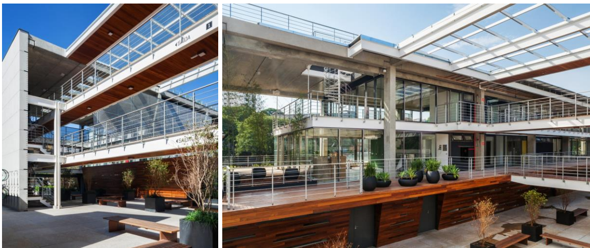
Imagem 9: Interior da edificação e passarelas intermediando os blocos noroeste e sudeste
