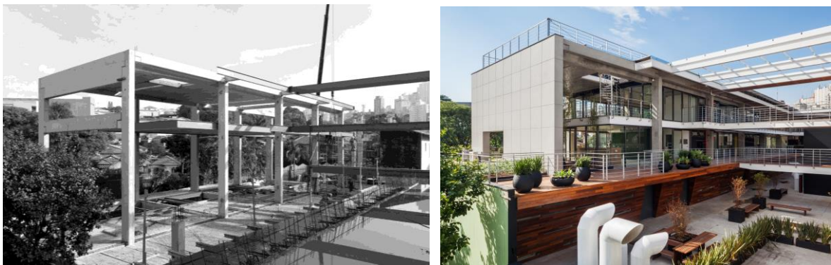
Construção do Edifício Corujas, 2012 (A); Finalização da obra, 2014 (B). Fonte: Fran Parente (A); Rafaela Netto (B). Retirado do site ArchDaily (2016).
