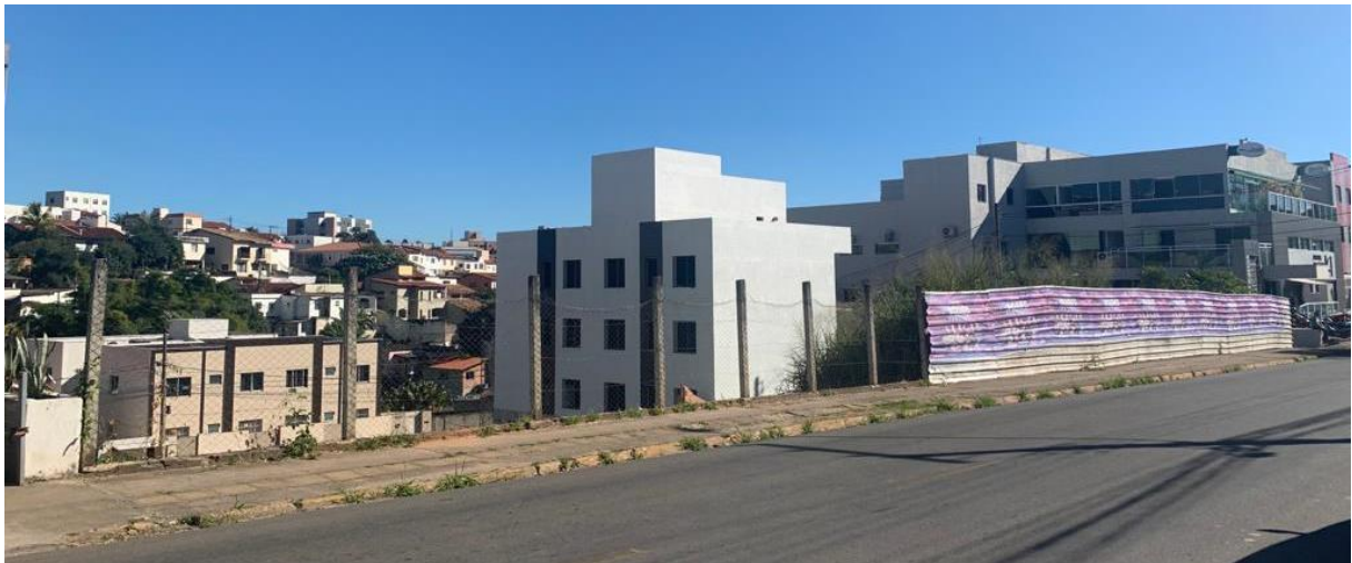
Imagem 26: Vista frontal do terreno
